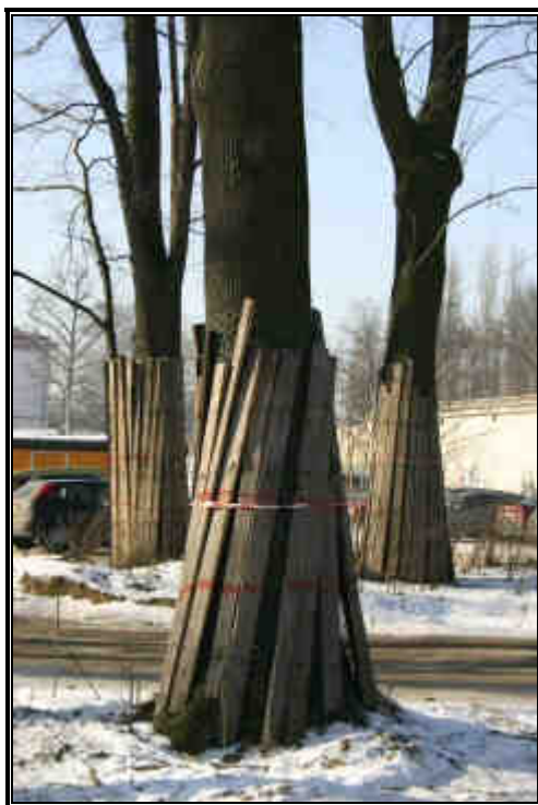
Fot. 10.3 Przykładowy sposób ochrony pnia drzewa przed uszkodzeniem związanym z pracami wykonywanymi w jego pobliżu [100]
