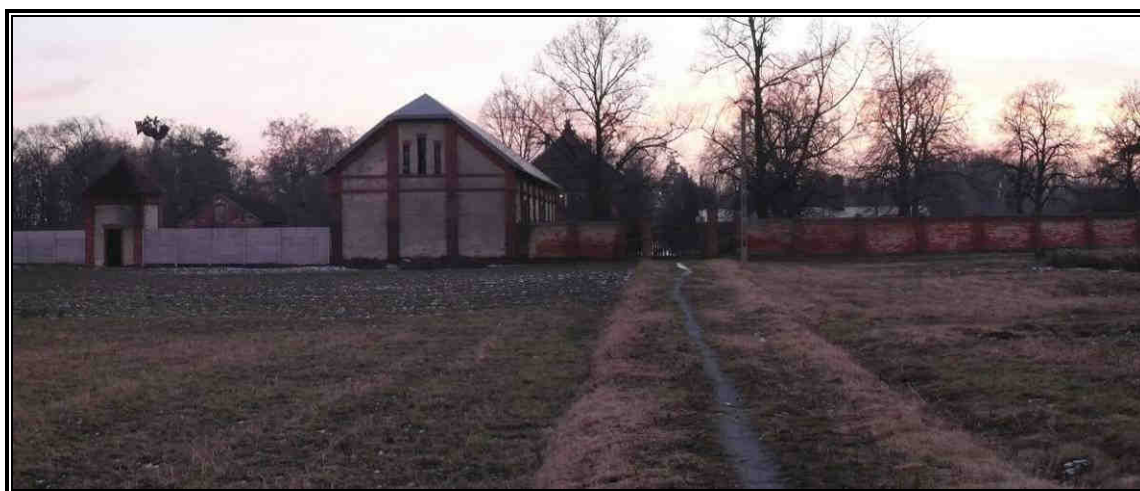
Fot. 6.13 Widok od strony północnej – murowany mur i stodoła
