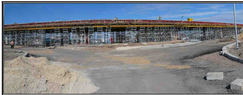
Fot. 6.3 Faza budowy wiaduktu
