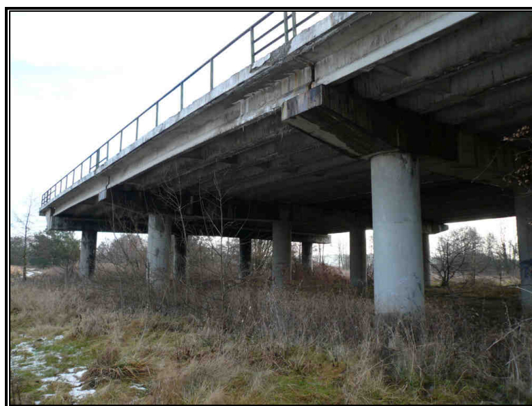
Fot. 2.1 Nieukończony wiadukt w rejonie Bolimowa (km 406+800)
