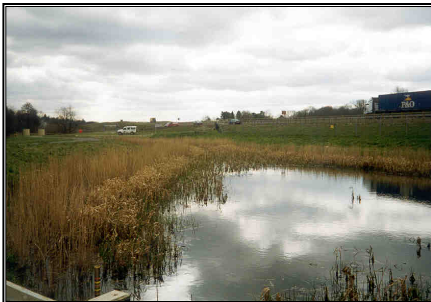
Fot. 10.2 Przykład wykonania zbiornika retencyjno-infiltracyjnego – obwodnica Newbury (Wielka Brytania)
