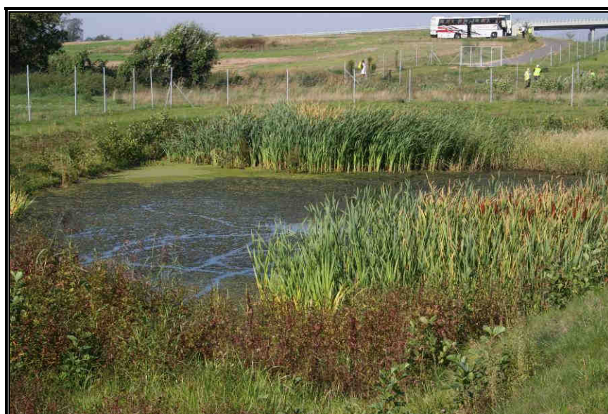
Fot. 10.1 Przykład wykonania zbiornika retencyjno-infiltracyjnego na autostradzie A-2
