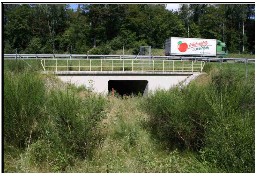
Fot. 10.6 Przykład przepustu o przekroju prostokątnym (autostrada A4, okolice Kędzierzyna–Koźła)
