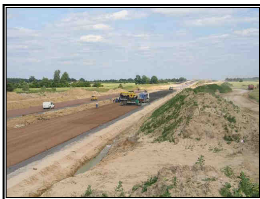
Fot. 6.2 Przykłady fazy budowy drogi w otwartym krajobrazie
