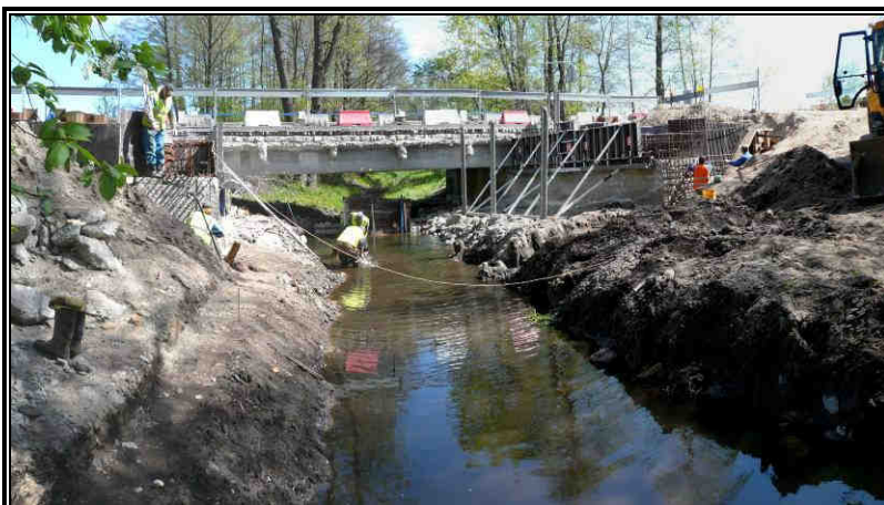
Fot. 6.4 Faza realizacji inwestycji drogowej (przykłady)
