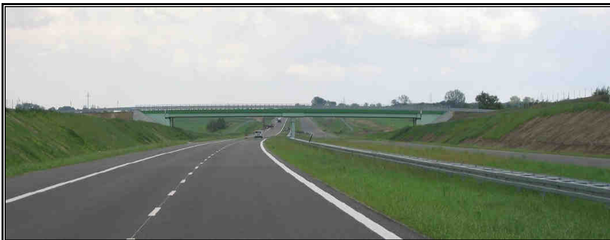
Fot. 6.10 Droga poprowadzona w wykopie jest niewidoczna z terenów sąsiadujących z nią. Takie rozwiązanie pozwala też znacznie obniżyć nasypy dojazdu do przejazdu nad drogą [109]
