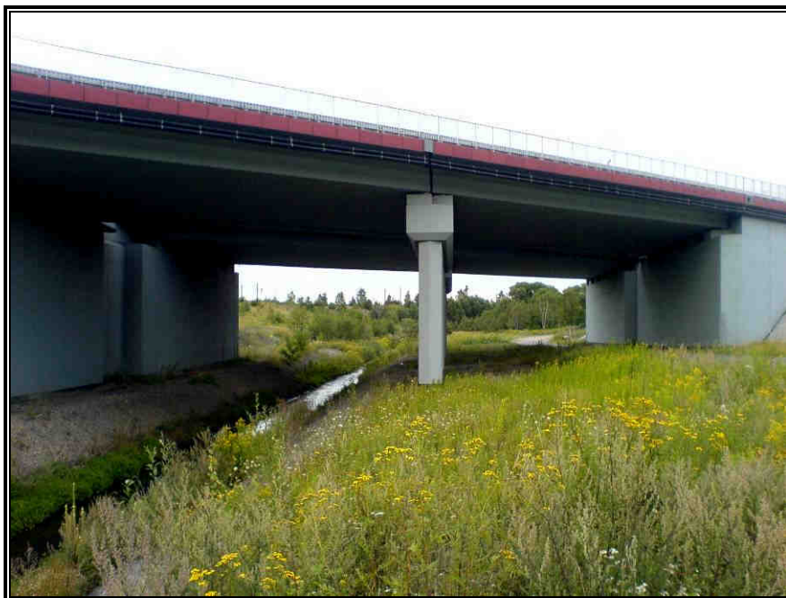
Fot. 10.5 Przykład przejścia dolnego dla zwierząt średnich zespolonego z ciekim (autostrada A4, okolice Gliwic)
