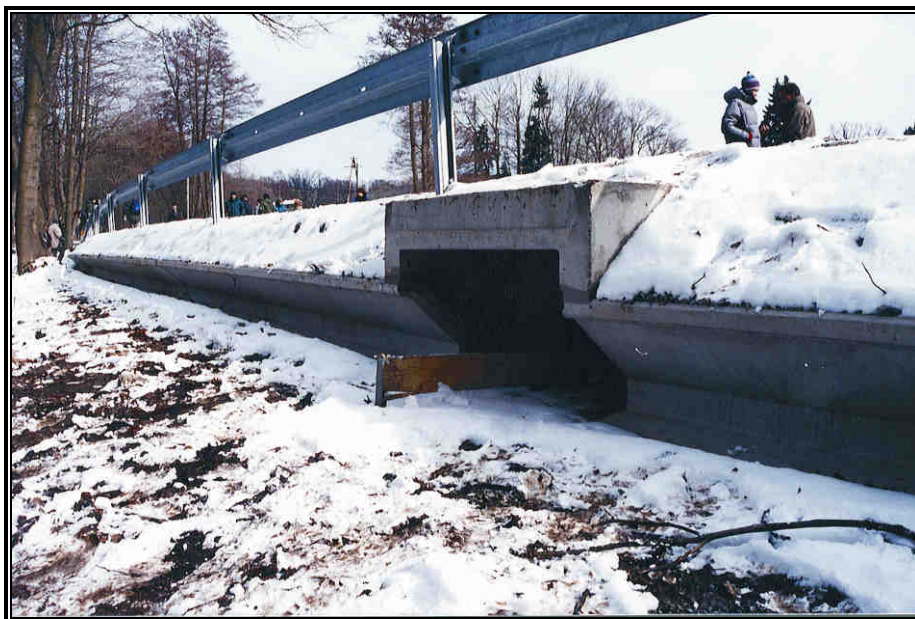
Fot. 10.8 Przykład przejścia dla płazów z płótkiem naprowadzającym (Park Narodowych Gór Stołowych)
