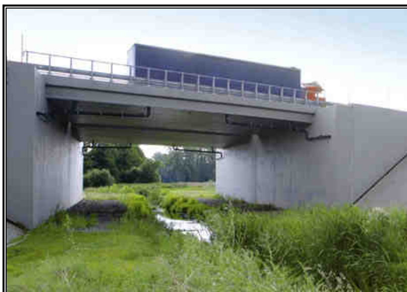
Fot. 10.4 Przykład dolnego przejścia dla dużych zwierząt zespolonego z ciekim (autostrada A-2, okolice Poznania) – obiekt z początkowej fazy eksploatacji
