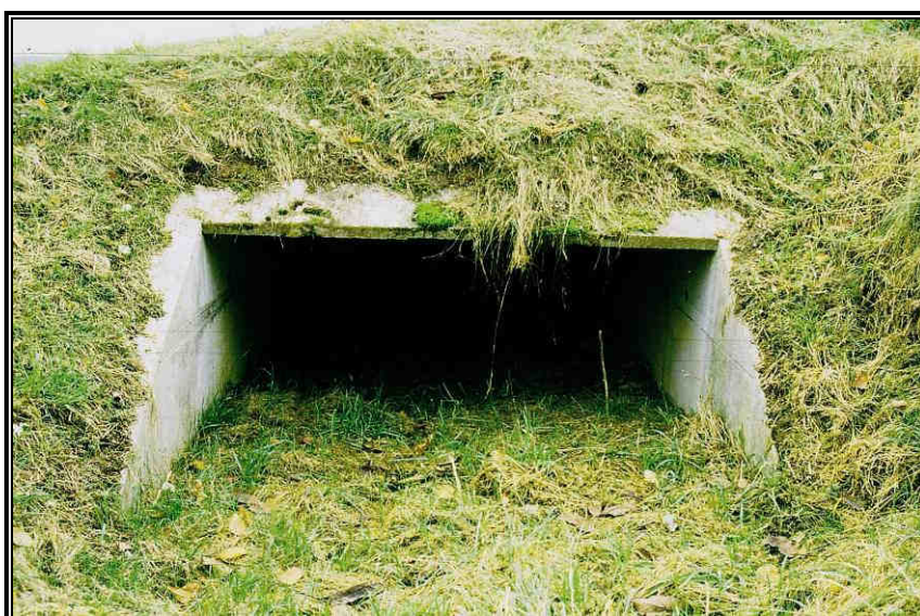
Fot. 10.7 Przykład przepustu o przekroju prostokątnym (Niemcy)
