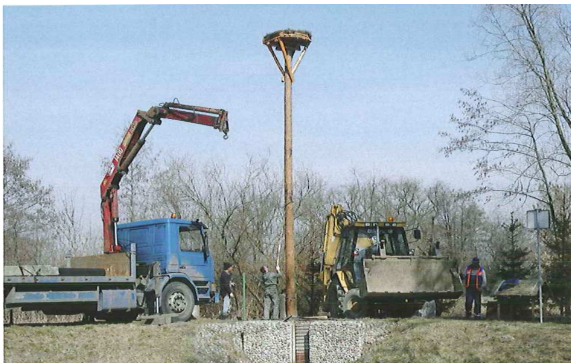
Fot. 22. Montaż słupa z platformą gniazdową dla bociana białego w miejscowości Chyliczki ul. Wł. Jagiełły 66.
