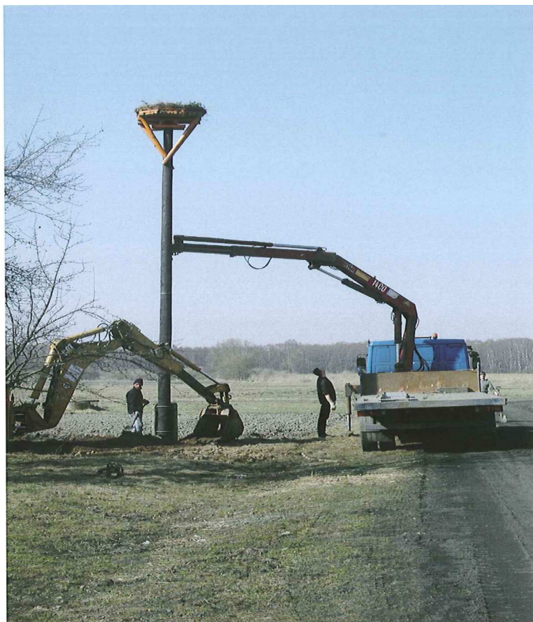
Fot. 23. Montaż słupa z platformą gniazdową dla bociana białego w miejscowości Chyliczki ul. Wł. Jagiełły 78.
