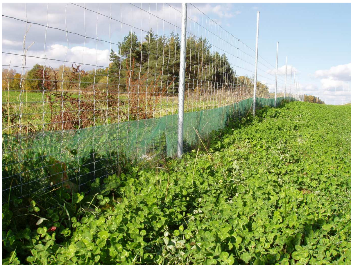
Fot. 26. Siatka z tworzywa sztucznego w okolicy przepustu dla małych zwierząt i płazów na odcinku autostrady A4 (źródło – materiał firma BETAFENCE).
