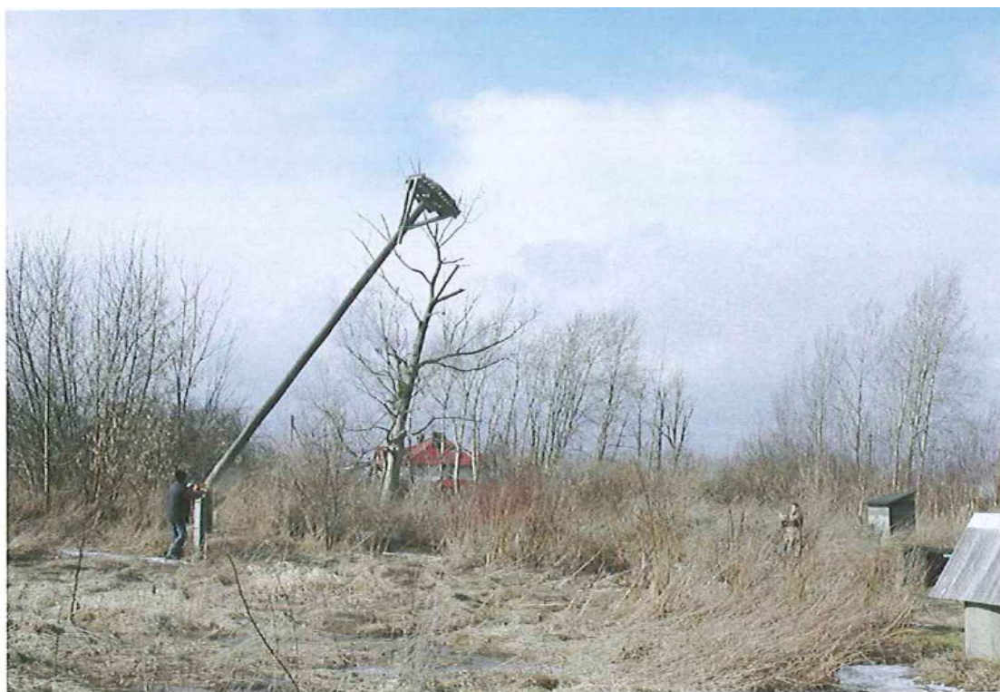
Fot. 18. Koszajec, gmina Brwinów – demontaż słupa z platformą gniazdową dla bociana białego
