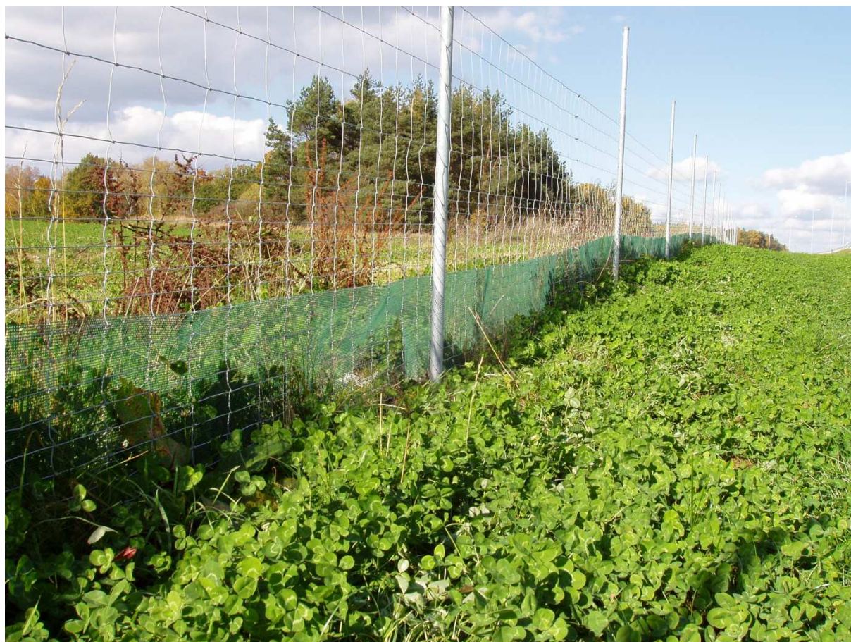
Fot. 1. Siatka z tworzywa sztucznego w okolicy przepustu dla małych zwierząt i płazów na odcinku autostrady A4 (źródło – materiał firma BETAFENCE).
