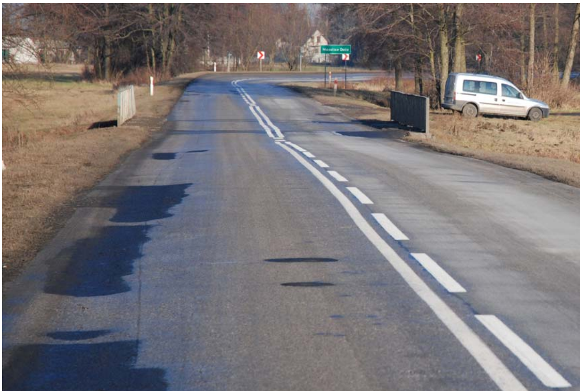
Fot. nr 1 Widok obiektu od strony m. Kozenice.
