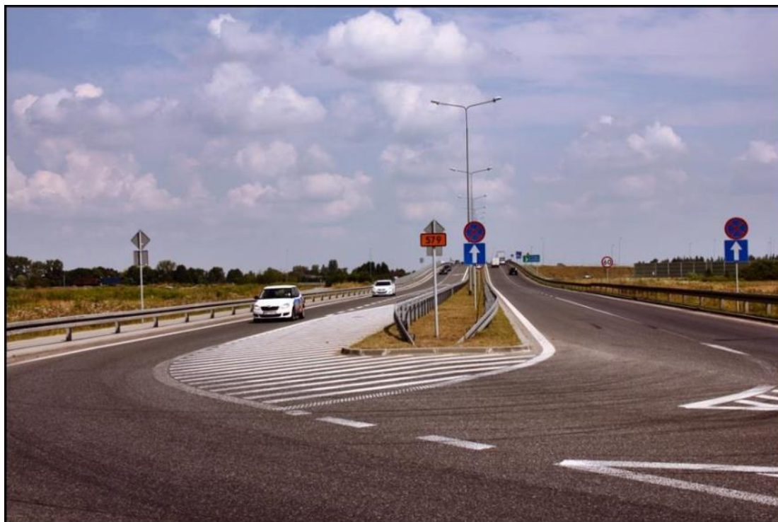
Fot. 1 Węzeł autostradowy „Tłuste” w początkowym odcinku planowanej inwestycji
