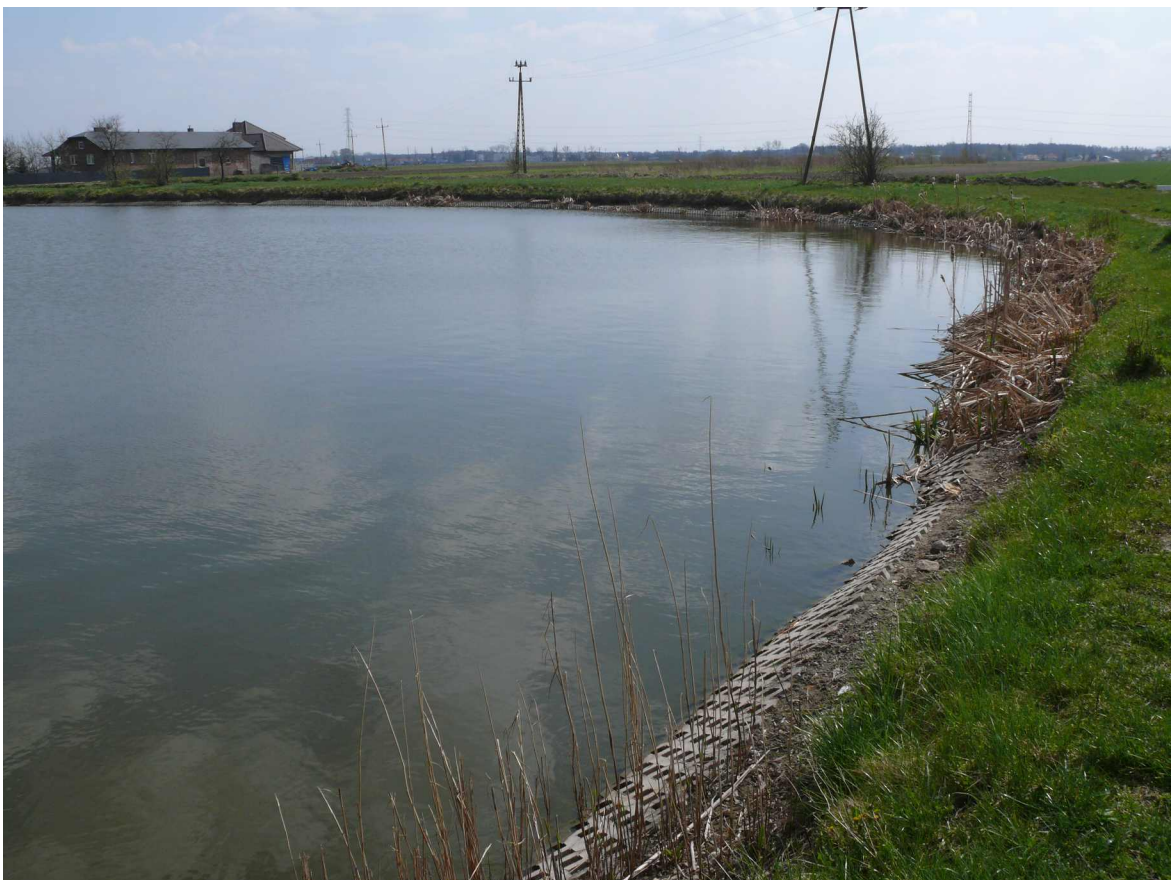
Fot. 10. Zbiornik 9 - widok od strony północnej
