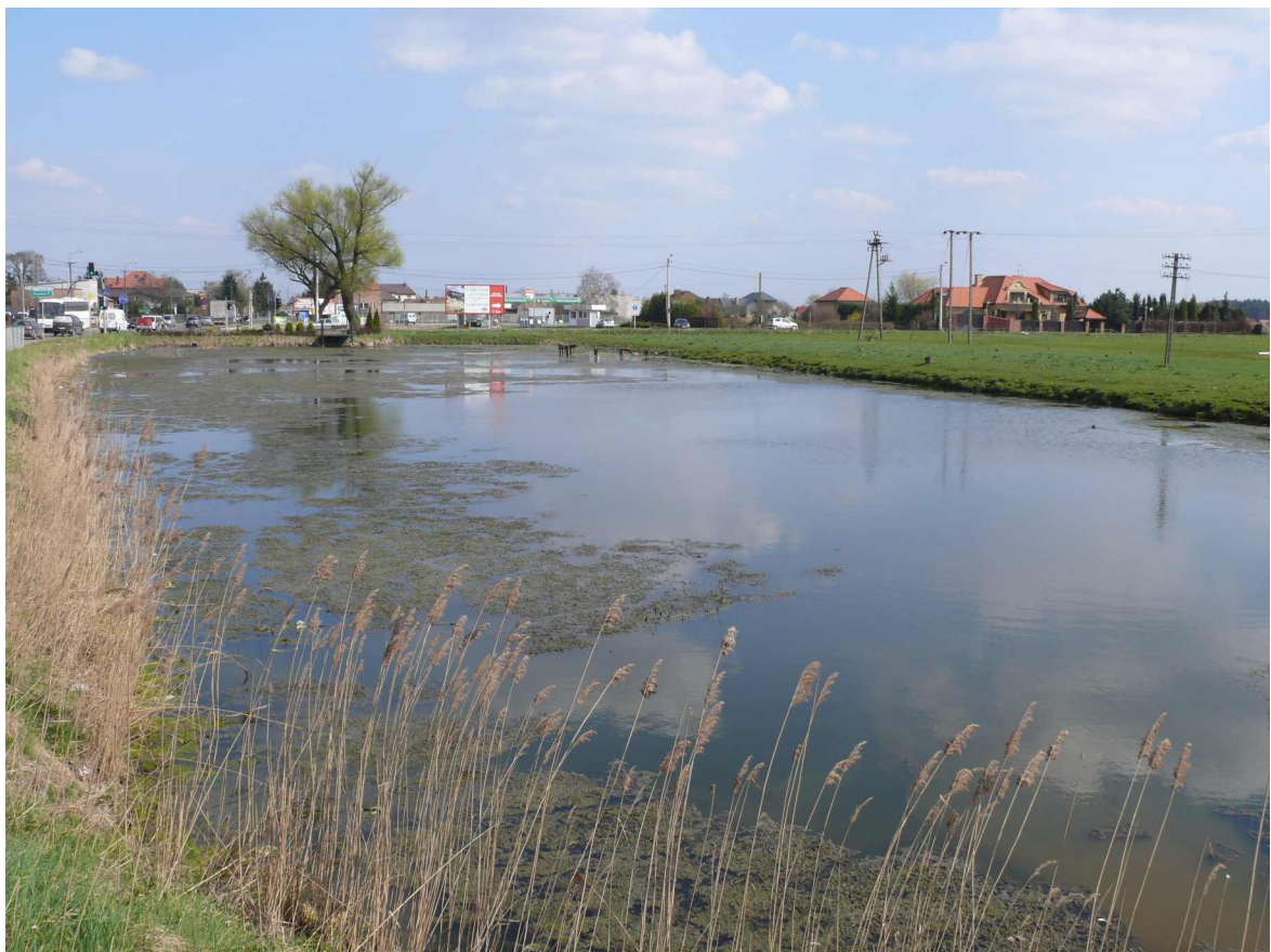
Fot. 12. Zbiornik 11 - widok od strony zachodniej
