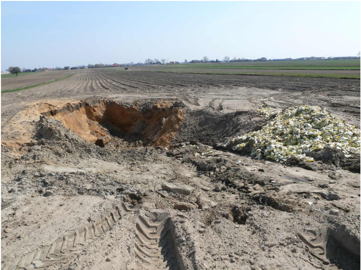
Fot. 1. Zbiornik 1 - widok od strony zachodniej
