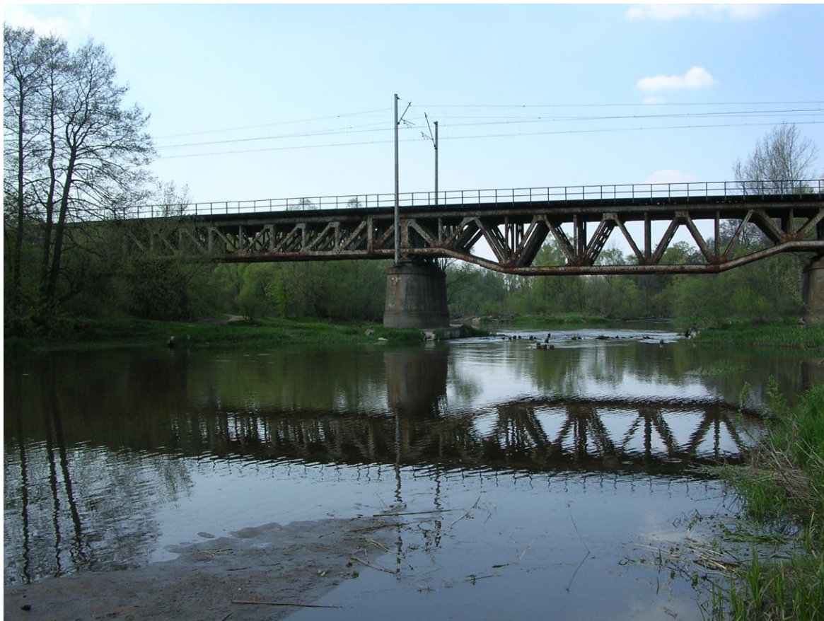
Fot. Most na rzece Liwiec – km 54.179
