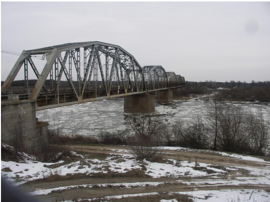
Fot. Most na rzece Bug – km 84.556
