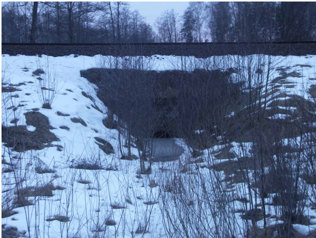
Fot. Przepust w km 93.946
