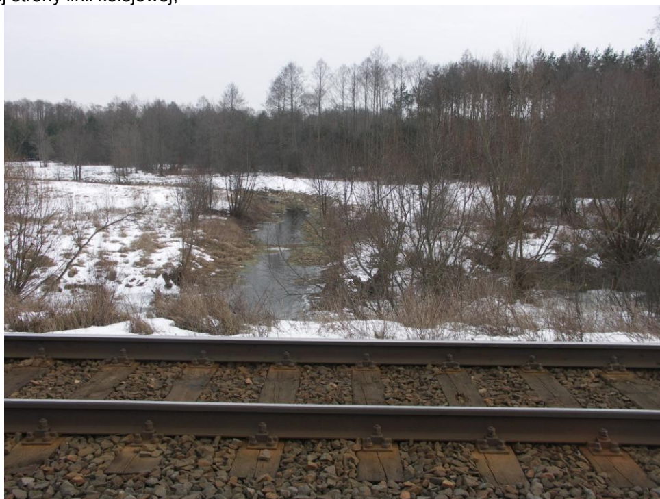
Fot. Przepust w km 78.830
