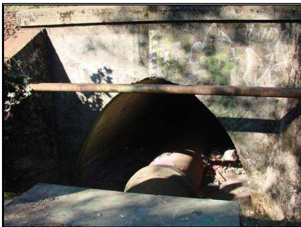
Fot. 5.8 Istniejący przepust w km 22+274, widok od strony południowej – studnia kanalizacyjna
