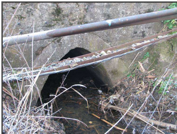
Fot. 3.8 Istniejący przepust w km 24+552, widok od strony południowej – wlot przepustu
