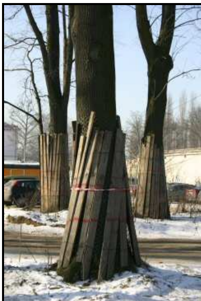
Fot. 5.5 Przykładowy sposób ochrony pnia drzewa przed uszkodzeniami związanymi z pracami wykonywanymi w jego pobliżu
