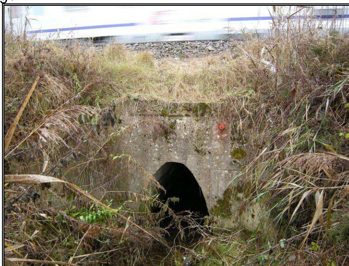
Fot. 3.3 Istniejący przepust w km 20+535, widok od strony północnej
