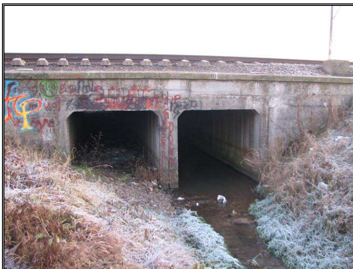
Fot. 3.6 Istniejący przepust w km 23+290, widok od strony północnej – wylot przepustu
