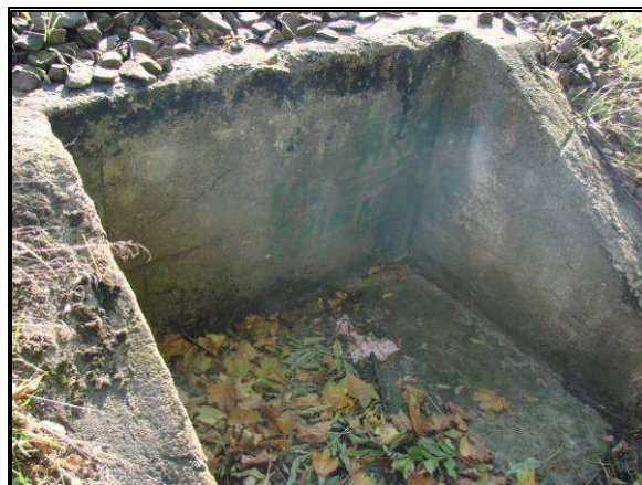
Fot. 5.9 Istniejący przepust w km 22+274, widok od strony północnej – komora kolektora kanalizacyjnego
