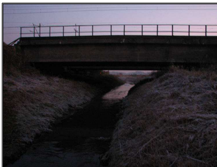
Fot. 3.2 Istniejący most w km 19+989, widok od strony południowej
