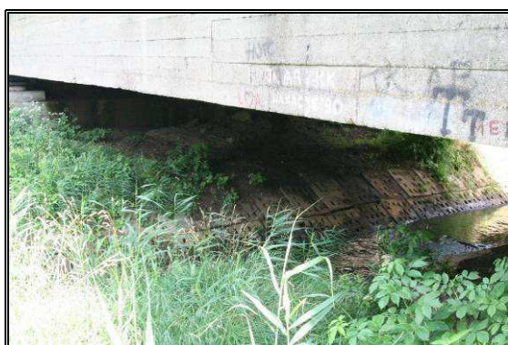
Fot. 5.6 Most nad rzeką Zimna Woda w stanie istniejącym
