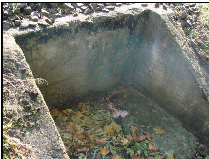
Fot. 3.5 Istniejący przepust w km 22+274, widok od strony północnej – komora kolektora kanalizacyjnego
