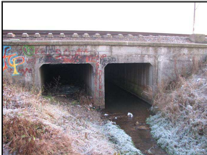
Fot. 5.10 Istniejący przepust w km 23+290, widok od strony północnej
