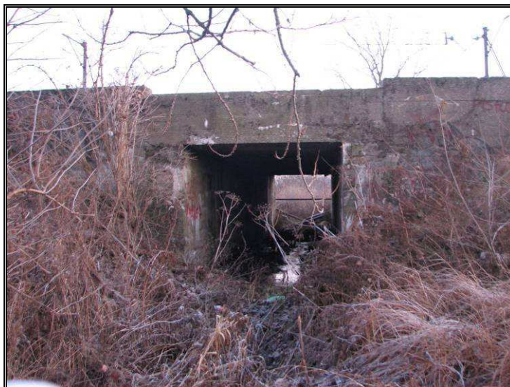
Rys. 5.11 istniejący most w km 23+527 – widok od strony północnej
