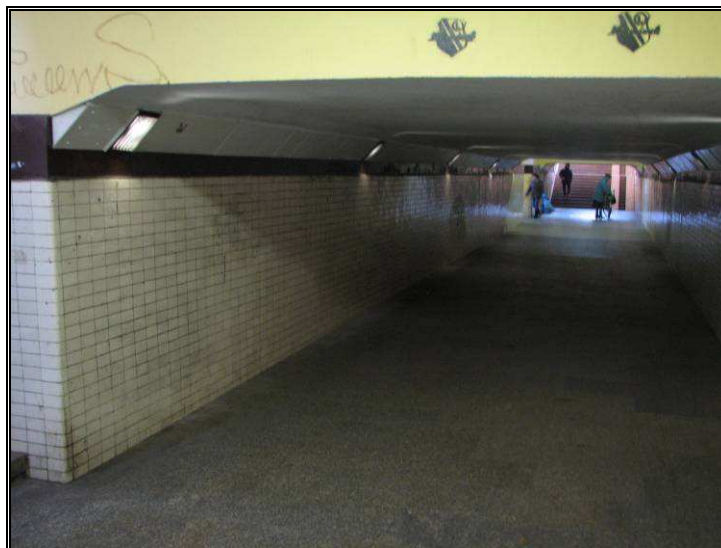
Fot. 3.9 przejście pod torami dla pieszych w km 26+080
