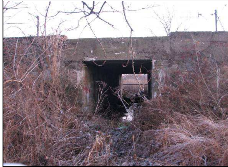
Fot. 5.3 Rów RS-11/9 w km 23+527
