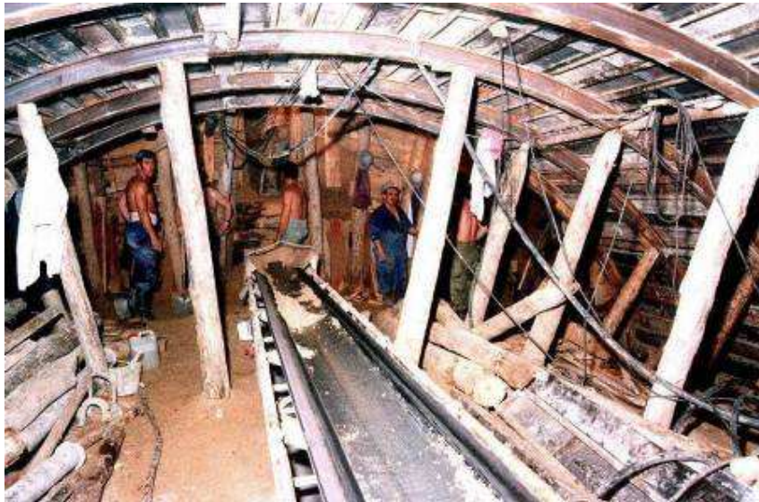
Rysunek 2. 18 Przykładowa budowa tunelu metoda belgijską: powiększanie tunelu oraz wykonanie sklepienia
