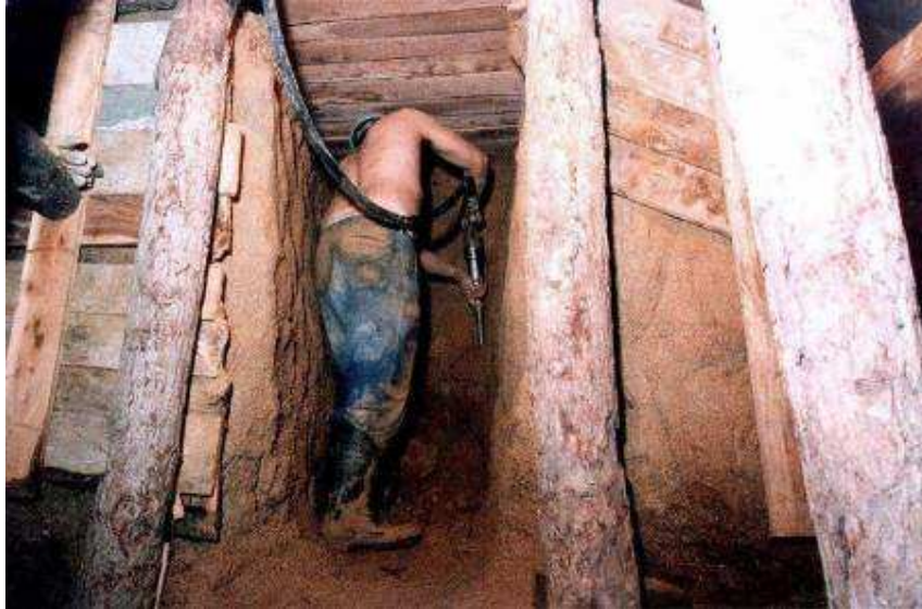
Rysunek 2. 17 Przykładowa budowa tunelu metoda belgijską: powiększanie tunelu
