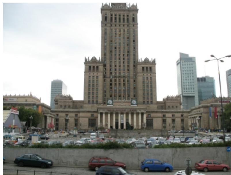
Fot. 40 Ul. Marszałkowska - widok na główne wejście do PKiN.
