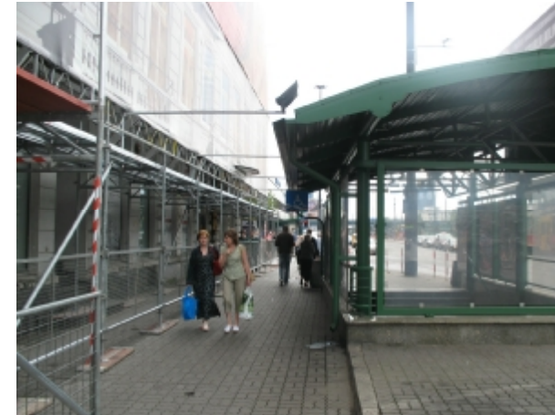
Fot. 35 Al. Jerozolimskie (strona południowa) - wejście do przejścia podziemnego pod ul. E. Plater.
