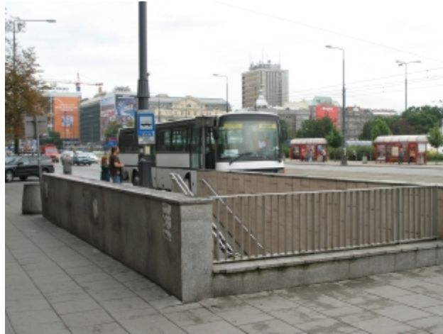
Fot. 25 Ul. Marszałkowska (strona wschodnia) - wejście do przejścia podziemnego.
