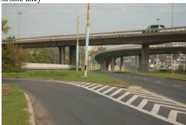
Fot. 2.3 Węzeł drogowy Puławska – Rzymowskiego. Widok w kierunku pętli tramwajowej Wyścigi
