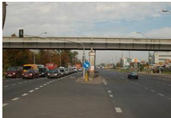
Fot. 2.14 Widok na wiadukt kolejowy w rejonie ul. Żoły – widoczna kolizja trasy tramwaju z podporą wiaduktu
