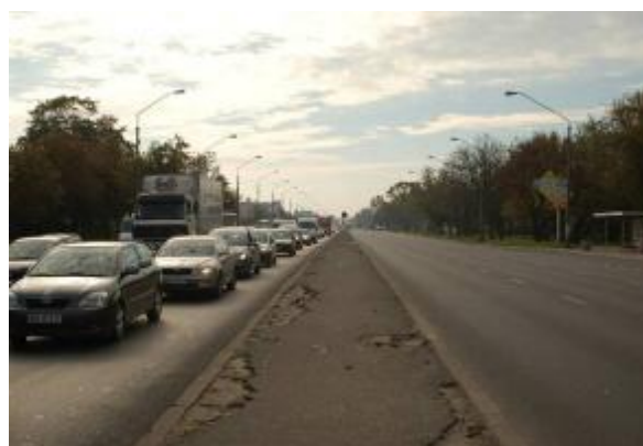
Fot. 2.10 Skrzyżowanie z ul. Mysikrólika - widok ul. Puławskiej (i pasa dzielącego jezdnie) w kierunku Piaseczna.
