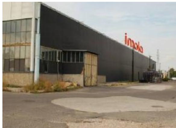
Fot. 7.2 Dawna zajezdnia trolejbusowa w Piasecznie
