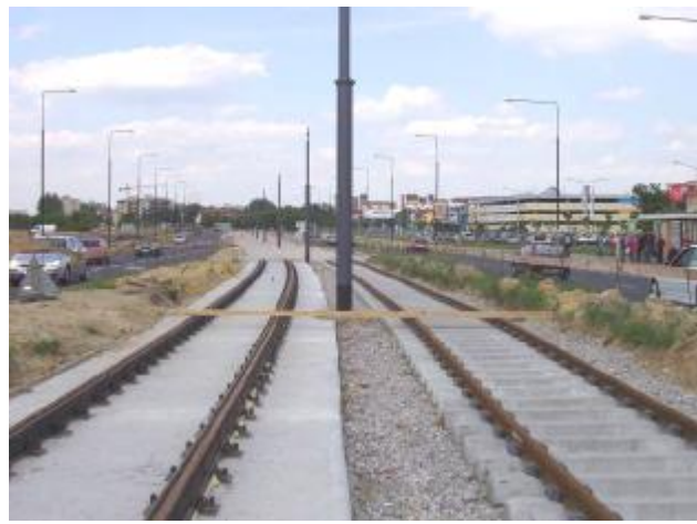
Fot. 4.2 Przykład torowiska tramwajowego przygotowanego pod zabudowę nawierzchnią trawiastą
