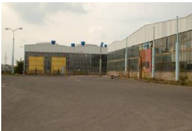
Fot. 7.1 Dawna zajezdnia trolejbusowa w Piasecznie
