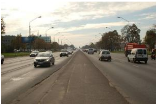
Fot. 2.13 Rejon usytuowania zespołu przystankowego Żoły
