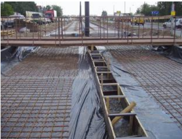
Fot. 4.1 Przykład koryta trasy tramwajowej wyłożonego matą podtorową i przygotowanego pod układanie podkładów betonowych
