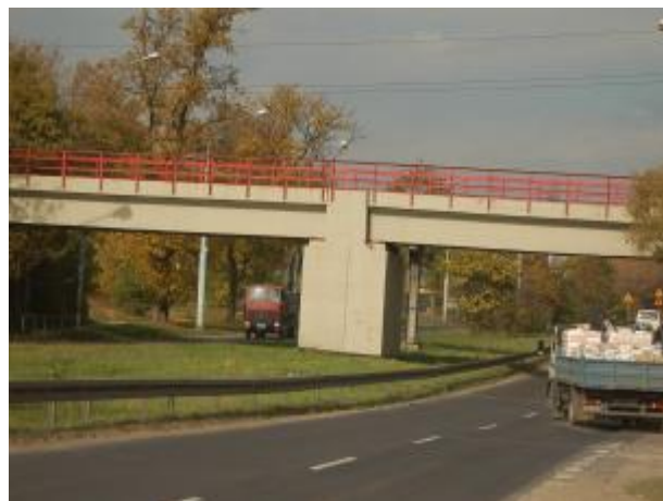
Fot. 2.30 Wiadukt kolejowy bocznicą kolejowej do terenów Thompson-Polkolor – widoczna podpora wiaduktu w pasie dzielącym ul. Puławskiej.
