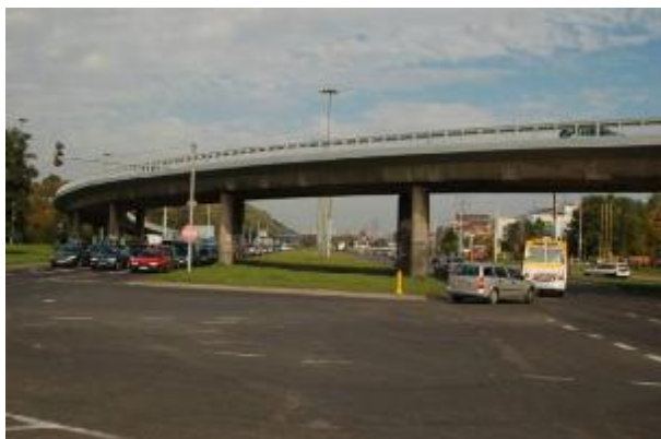
Fot. 2.7 Węzeł Puławska/Poleczki/Pileckiego - usytuowanie podpór estakady w pasie dzielącym ul. Puławskiej i widoczna rezerwa terenu pod trasę tramwajową
