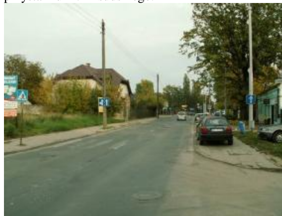
Fot. 2.50 Ulica Chyliczkowska jednokierunkowa – możliwość wykorzystania jednego pasa ruchu na torowisko tramwajowe
