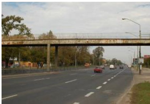
Fot. 2.20 Widok na kładkę dla pieszych przez ul. Puławską – widoczna kolizja trasy tramwaju z podporami kładki
