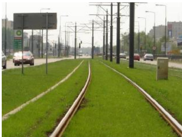
Fot. 4.4 Trasa tramwajowa z Bemowa na Bielany – przykład odcinka szlakowego z torowiskiem zabudowanym nawierzchnią trawiastą
