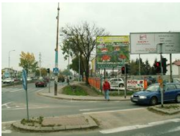
Fot. 2.25 Kolizja z Autokomiselem w rejonie skrzyżowania z ul. Łabędzią
