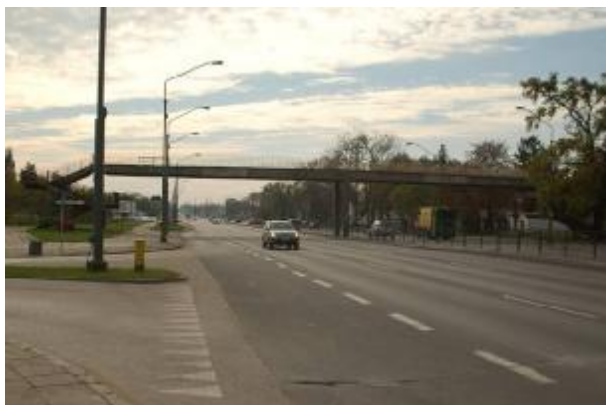
Fot. 2.19 Rejon usytuowania zespołu przystankowego tramwajowego Kapeli .
