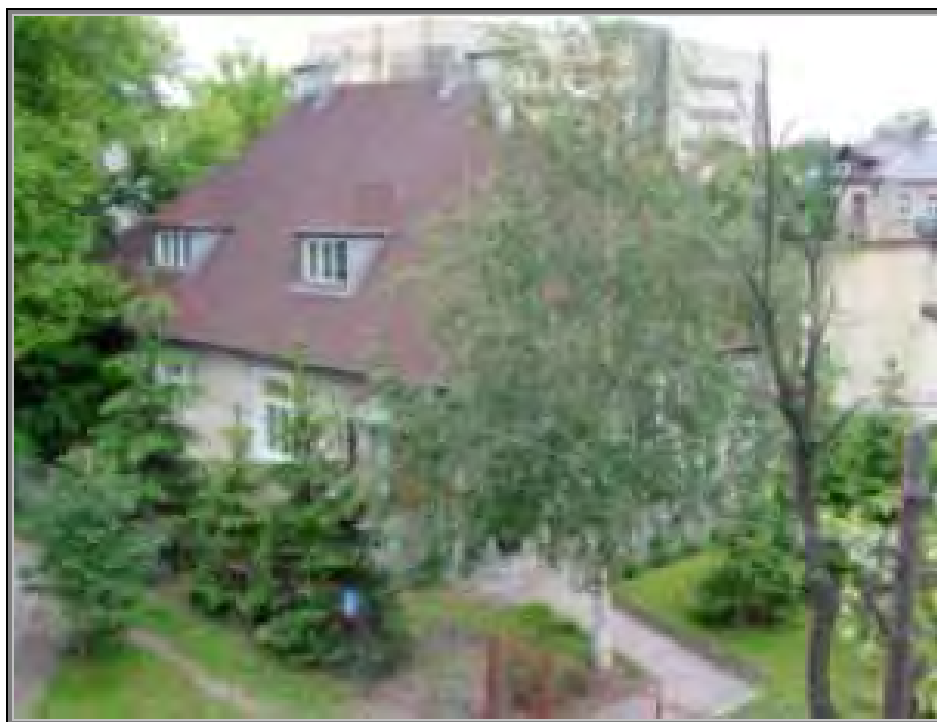
Fot. 11 Budynek przy ul. Marsa 23
