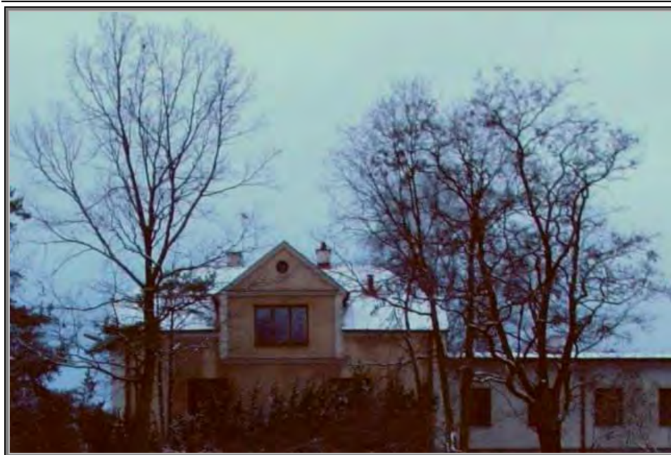
Fot. 12 Budynek przy ul. Marsa 61
