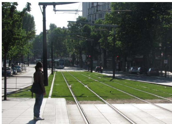
Ilustracja 38. Stosowanie torowisk linii tramwajowych z zabudową trawiastą
