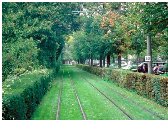
Ilustracja 37. Zastosowanie żywopłotów, krzewów do wydzielenia i zabezpieczenia torowiska tramwajowego
