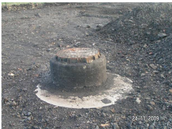
Rys. 7.3.2 Przykład zabezpieczenia studzienek w fazie budowy
