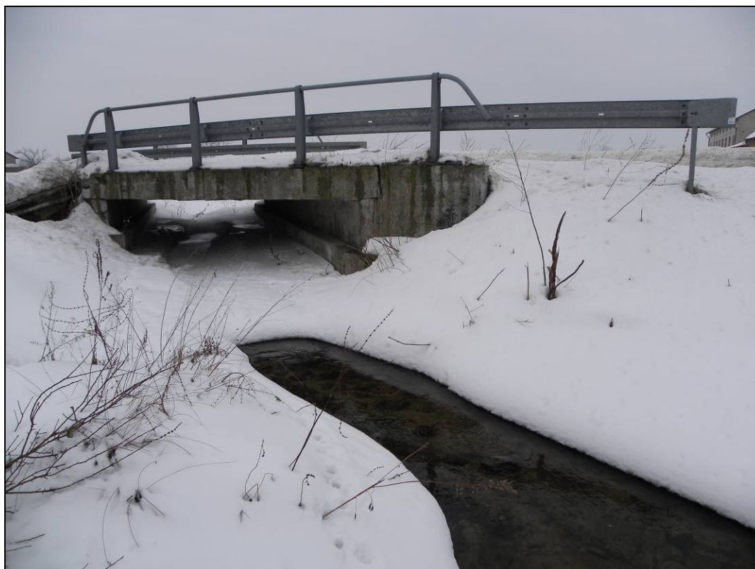
Rys. 5.7.8. Widok mostu od strony górnej wody
