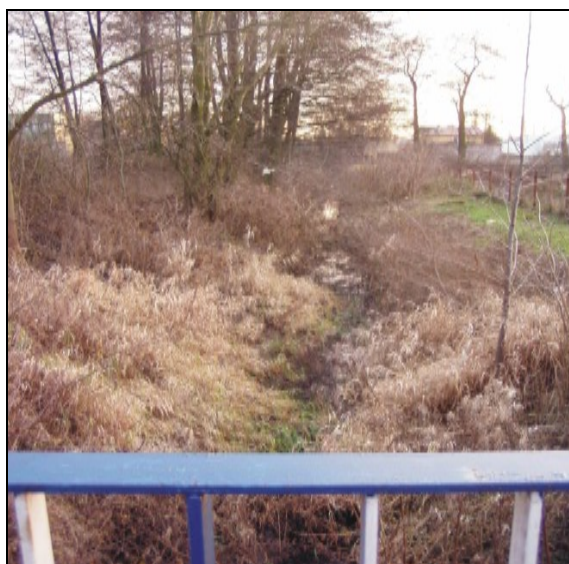
Fot. 5.3.12. Koryto Rowu Laktoza w Łyszkowicach
