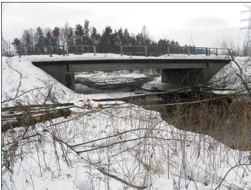
Rys. 5.7.7. Widok mostu od strony dolnej wody
