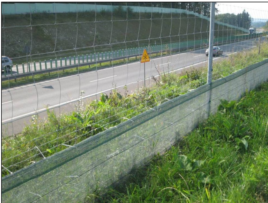
Rys. 7.4.38. Przykładowe zastosowanie ogrodzeń naprowadzających (fot. własna)
