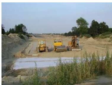
fot. Piotr Sereczyński Faza realizacji inwestycji.
