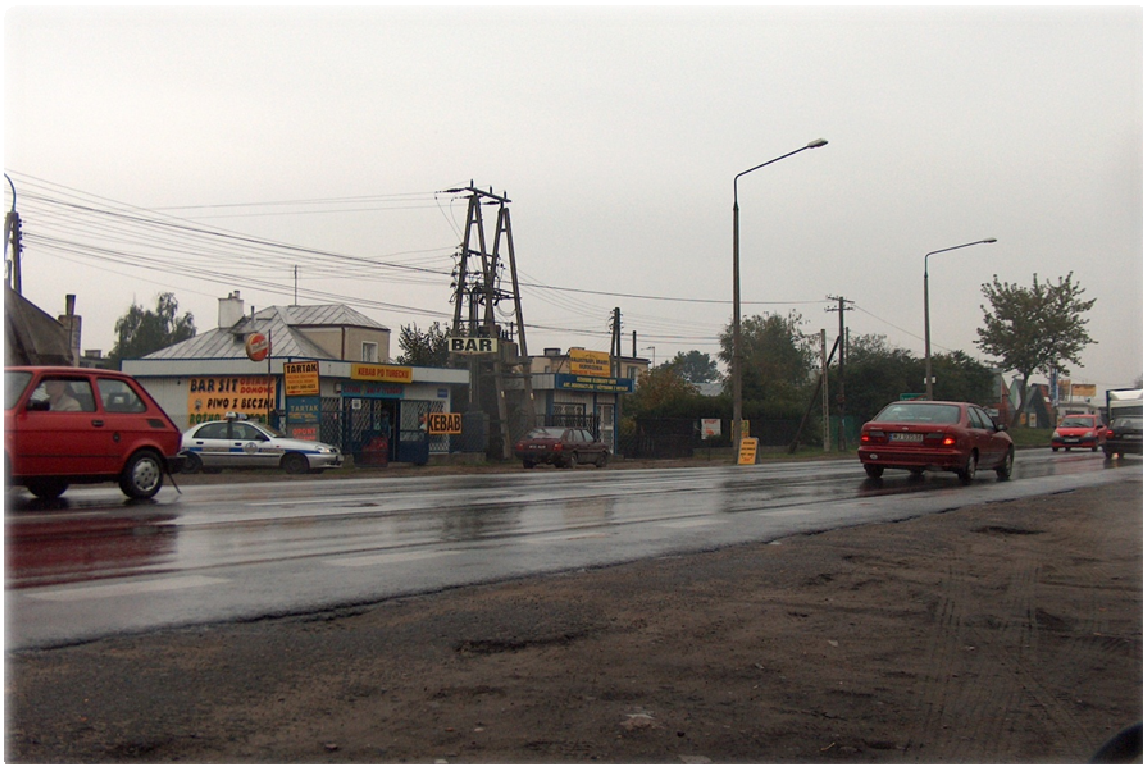
Zabudowa usługowa oraz linie elektroenergetyczne – krajobraz kulturowy zdegradowany – ul. Warszawska początek projektowanego odcinka-strona prawa
