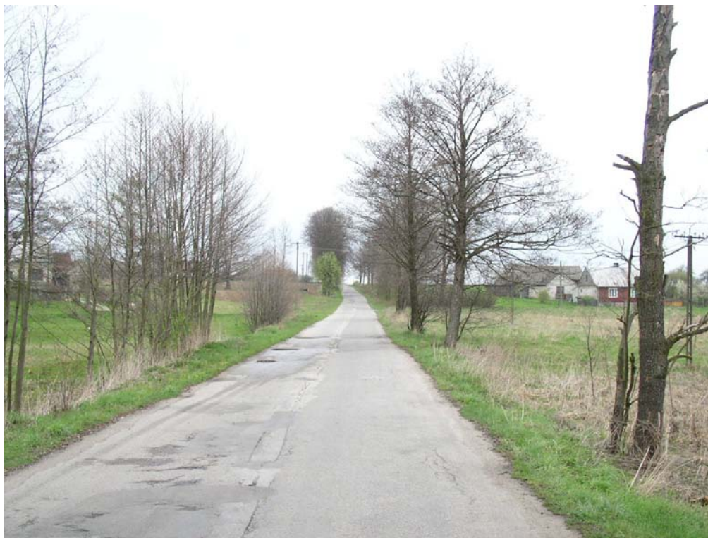
Fot. 20. Stan środowiska w kwietniu 2005 r.: km 4+050, droga gminna Białka – Iłża w Kolonii Seredzice, na pierwszym planie dolina Iłżanki, w głębi w poprzek miejsce projektowanej obwodnicy
