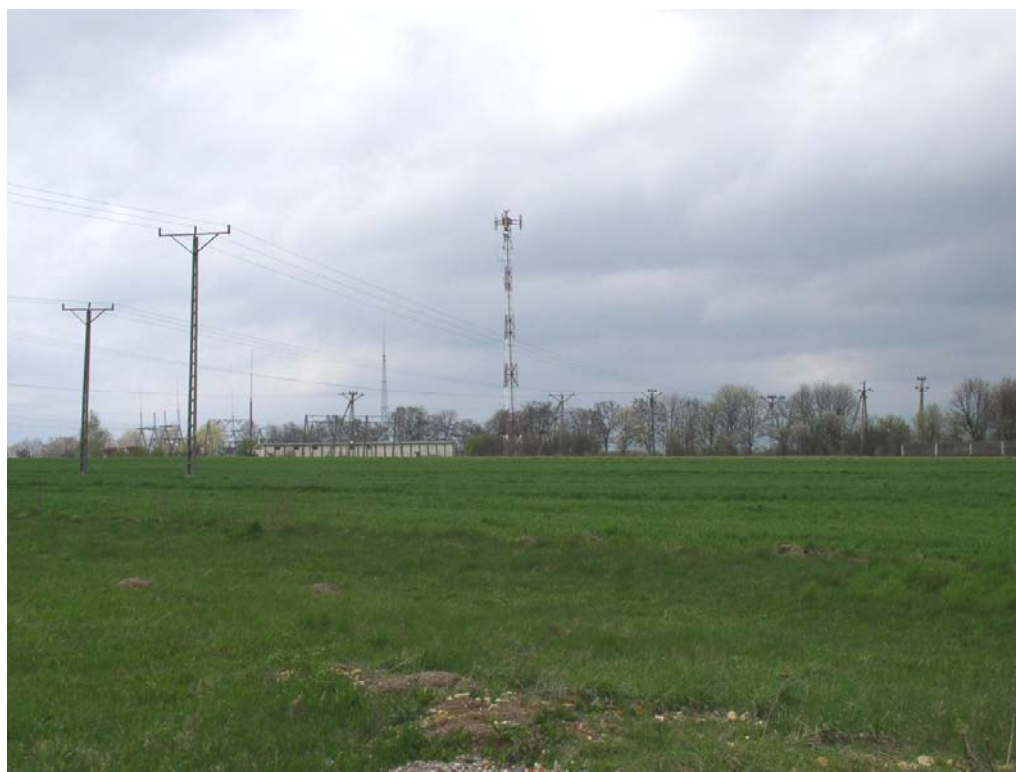
Fot. 11. Stan środowiska w kwietniu 2005 r.: km 1+650, pola w Iłży-Zuchowcu, w głębi podstacja elektryczna GPZ i miejsce projektowanego węzła „Iłża-Północ”
