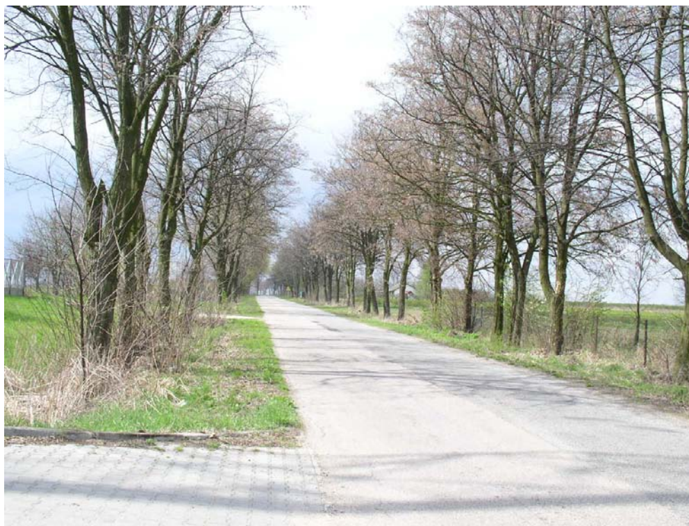
Fot. 6. Stan środowiska w kwietniu 2005 r.: km 1+440, droga powiatowa do Pakosławia, miejsce projektowanego węzła „Ilża-Północ”, z lewej zjazdu do podstacji elektrycznej GPZ
