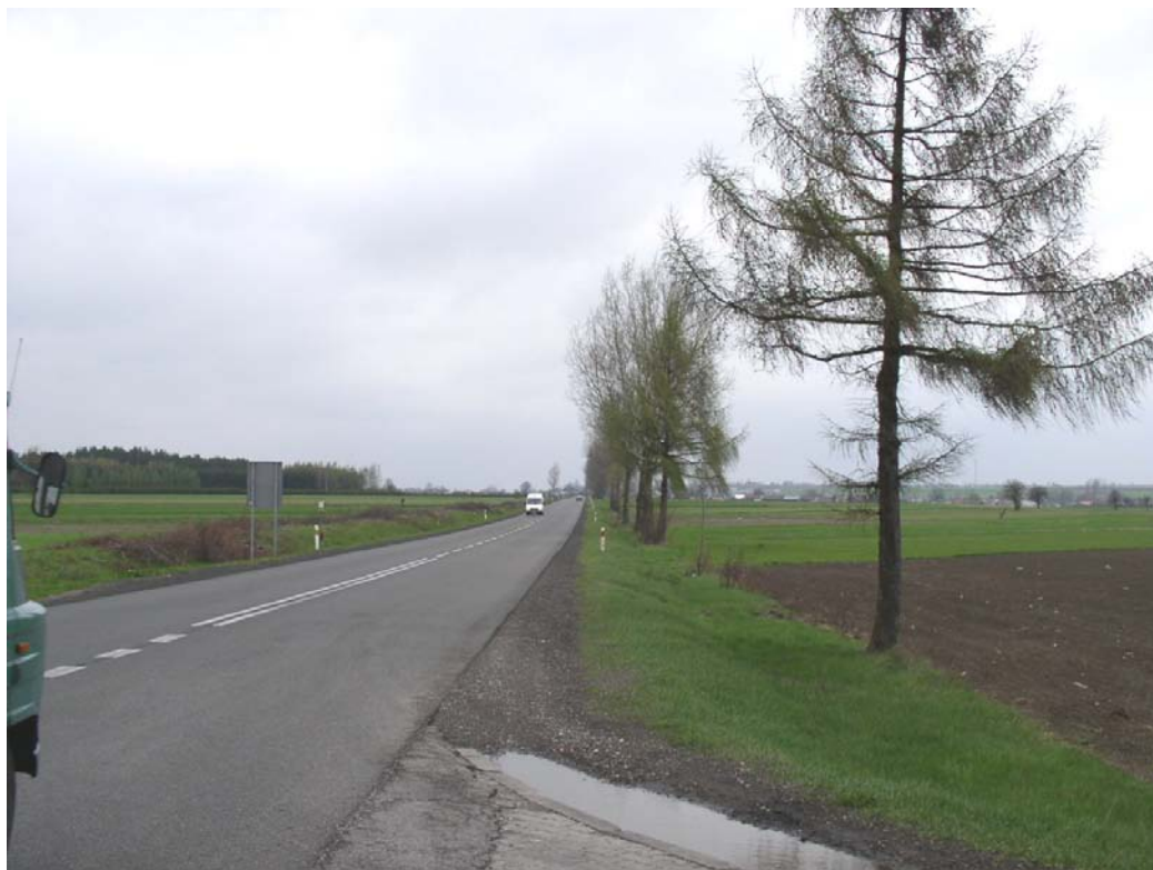
Fot. 30. Stan środowiska w lipcu 2005 r.: km 6+460, droga nr 9 w Błazinach Dolnych, po lewej miejsce wyłączenia projektowanej obwodnicy z istniejącej drogi, po prawej miejsce projektowanego zbiornika retencyjnego ZR-5
