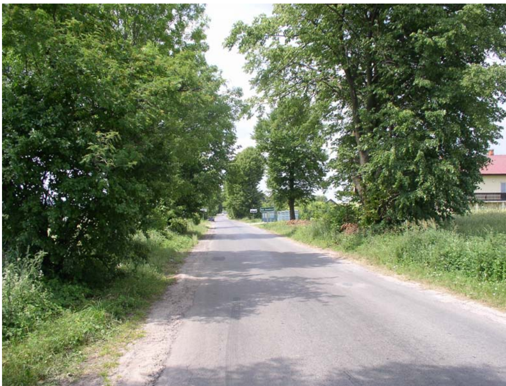
Fot. 18. Stan środowiska w lipcu 2005 r.: km 3+170, zabudowa Kolonii Seredzice przy drodze powiatowej do Seredzic, na pierwszym planie w poprzek miejsce projektowanej obwodnicy
