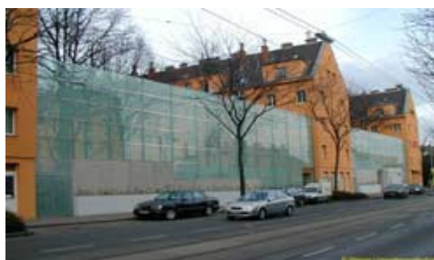
Fot. 9. Przykład zastosowania pasów poziomych na przezroczystych ekranach akustycznych w Wiedniu (Źródło: www.windowcollisions.info )
