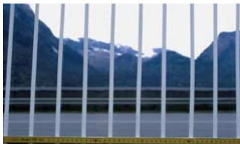
Fot. 8. Przykłady zalecanych nadruków ekranów przezroczystych w postaci pionowych pasów (20 mm/100 mm oraz 10 mm/50 mm), widzialnych dla ptaków (Źródło: www.windowcollisions.info )
