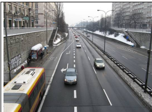
Fot: 23: Widok w kierunku ul. Kinowej. Panuje płynny ruch.
