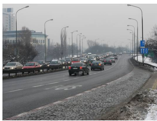
Fot: 20: Widok w kierunku ul. Kinowej.
