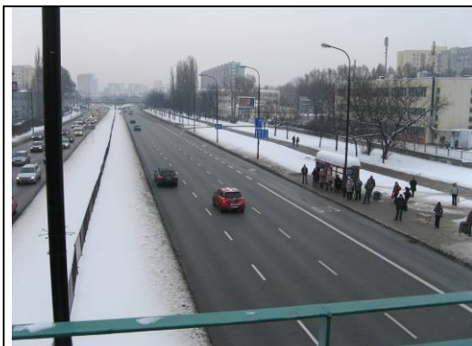
Fot: 5: Widok z wiaduktu wzdłuż ul. Saskiej w kierunku ul. Ostrobramskiej.
