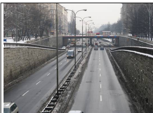
Fot: 25: Widok w kierunku ul. Kinowej.
