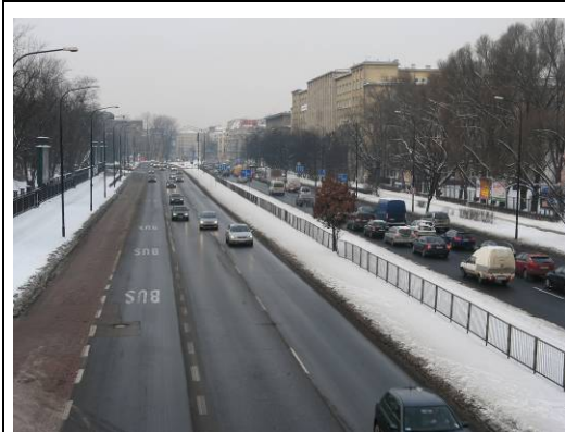
Fot: 31: Widok w kierunku ul. Grójeckiej.
