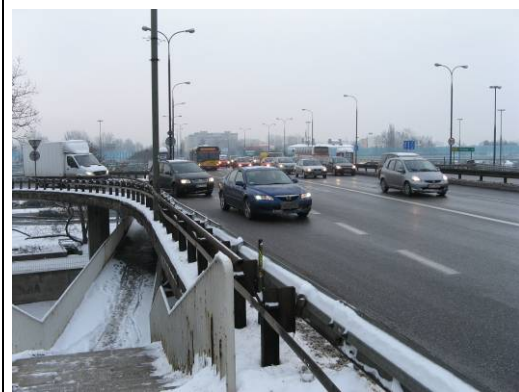
Fot: 13: Wjazd z ul. Wał Miedzeszyński od Mostu Poniatowskiego. Kierowcy samochodów osobowych włączają się na buspas opóźniając przejazd autobusów.
