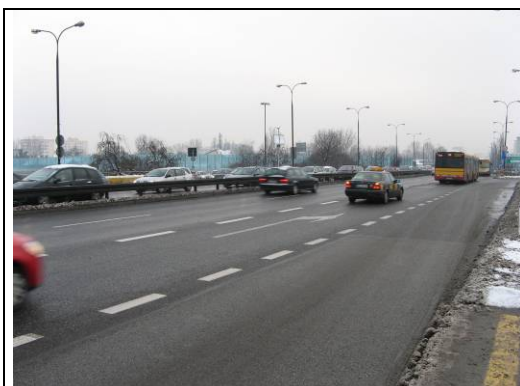
Fot: 9: Widok w kierunku ul. Kinowej.
