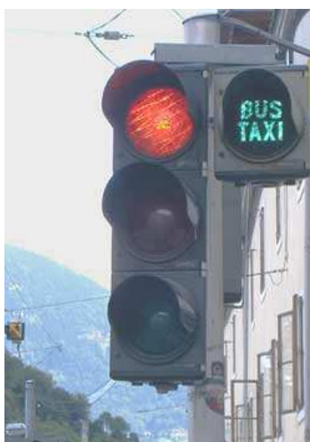
Rys. 21. Przykład sygnalizatora z oddzielnym sygnałem dla uprzywilejowanych pojazdów, który to wyświetla sygnał zielony o kilka sekund wcześniej w odniesieniu do sygnału zielonego dla pozostałych pojazdów
