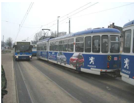
Fot. 84. Kraków. Wspólny pas tramwajowo – autobusowy wydzielony w rejonie skrzyżowania. Korzyści wynikają z redukcji strat czasu autobusów w punkcie kolizji i ułatwienia przesiadania się pasażerów.
