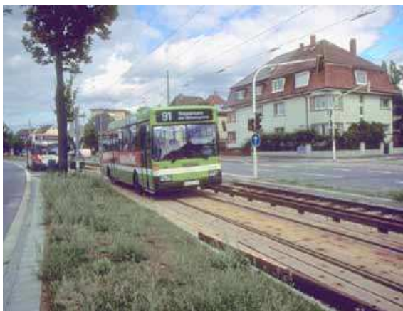
Fot. 81. Niemcy, Mannheim. Przykład przystosowanie torowiska tramwajowego do prowadzenia ruchu autobusowego.
