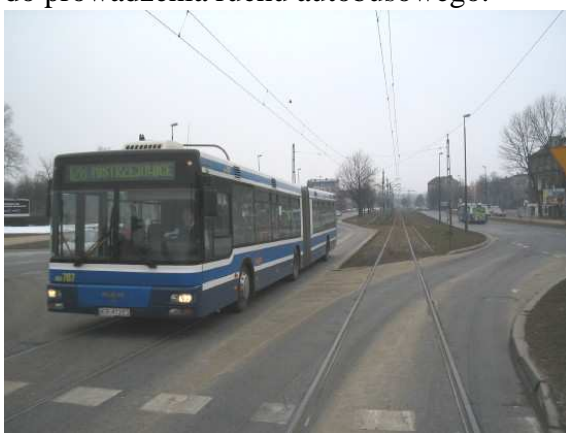
Fot. 83. Kraków. Wjazd i wyjazd autobusu na torowisko tramwajowe przystosowane do ruchu autobusów.
