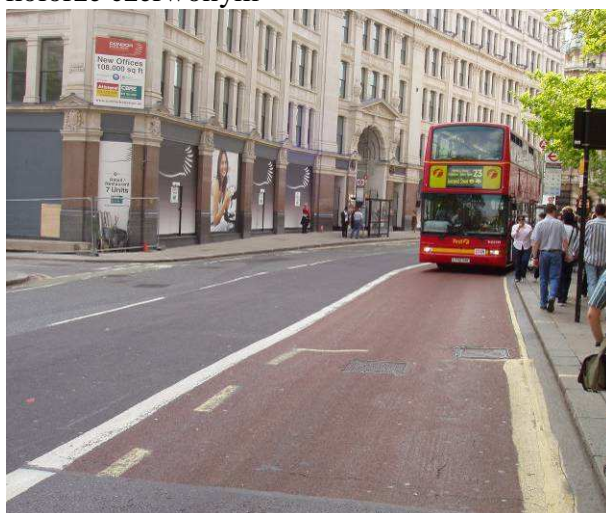
Fot. 57. Londyn, pas autobusowy wyznaczony za pomocą oznakowania poziomego z zastosowaniem nawierzchni w kolorze czerwonym
