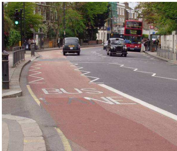
Fot. 56. Londyn, pas autobusowy wyznaczony za pomocą oznakowania poziomego z zastosowaniem nawierzchni w kolorze czerwonym
