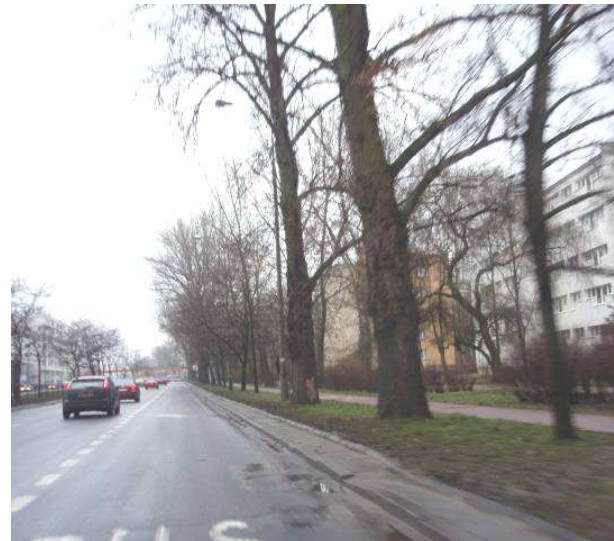
Fot. 8. Pas autobusowy na odcinku pomiędzy ul. Grottgera a ul. Dolną.
