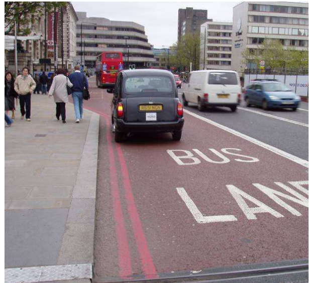
Fot. 54. Londyn, pas autobusowy wyznaczony za pomocą oznakowania poziomego z zastosowaniem nawierzchni w kolorze czerwonym – dopuszczony ruch taksówek.
