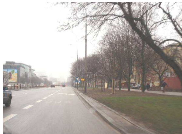
Fot. 32. Pas autobusowy, na odcinku od ul. Bryłowskiej do ul. Towarowej.
