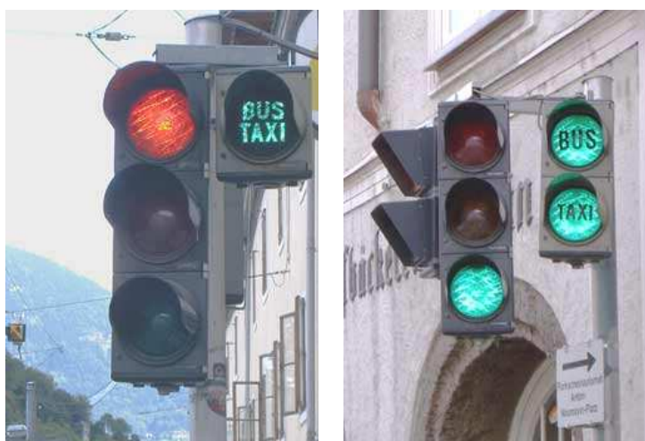
Fot. 93, fot. 94. Salzburg, Austria. Przykład prostego sposobu uprzywilejowania ruchu autobusów, poprzez wyświetlanie wcześniejszego (o kilka sekund) sygnału zielonego w stosunku do pozostałych pojazdów.
