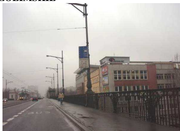
Fot. 12. Pas autobusowy, na odcinku pomiędzy wiaduktem Poniatowskiego a ul. Nowy Świat.
