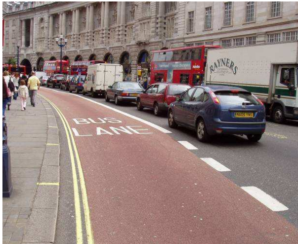
Fot. 51. Londyn, pas autobusowy wyznaczony za pomocą oznakowania poziomego z zastosowaniem nawierzchni w kolorze czerwonym – korzystny wpływ na dyscyplinę kierowców.
