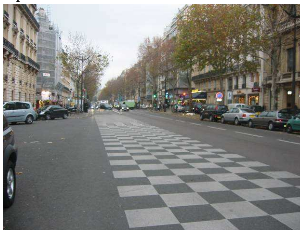
Fot. 49. Paryż, pas autobusowy – widoczne oznakowanie pasa na skrzyżowaniu – oznaczenie powierzchni potencjalnych kolizji autobusów z ruchem samochodowym
