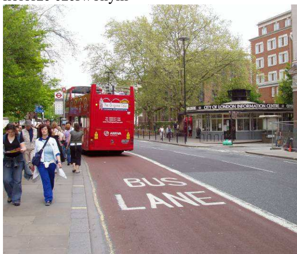
Fot. 58. Londyn, pas autobusowy wyznaczony za pomocą oznakowania poziomego z zastosowaniem nawierzchni w kolorze czerwonym
