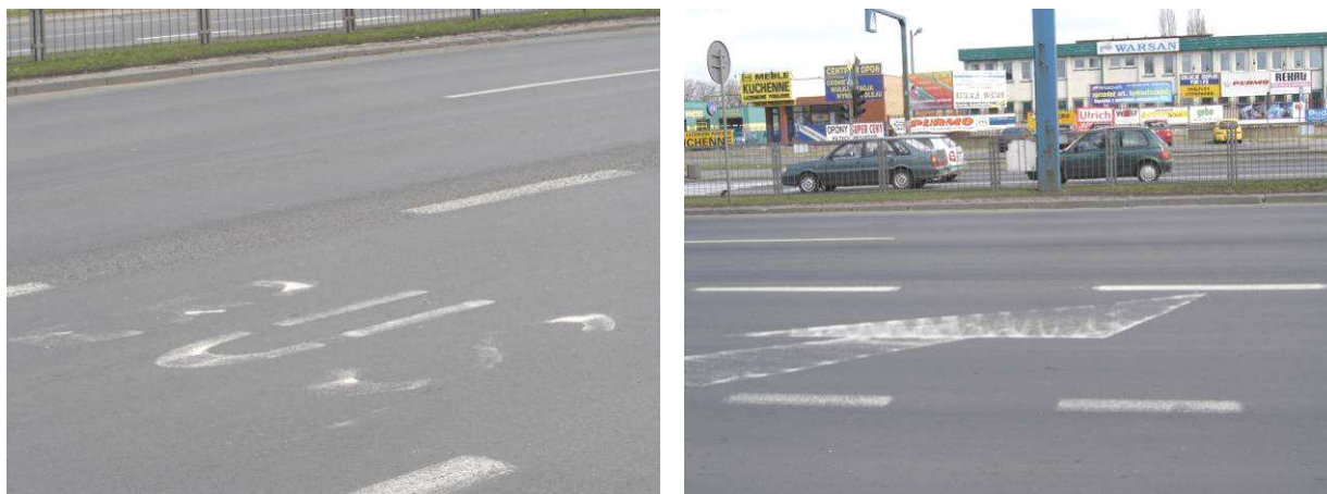
Fot. 39, fot. 40. Ul. Modlińska – widoczne nieczytelne i wymagające poprawy oznakowanie poziome pasa autobusowego.
