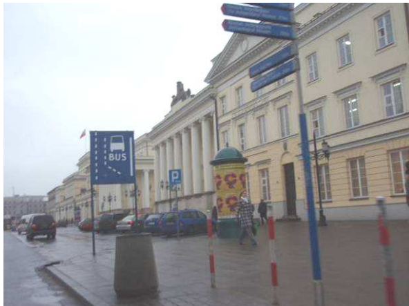
Fot. 29. Początek pasa autobusowego na Pl. Bankowym – dojazd do przystanku autobusowego Pl. Bankowy
