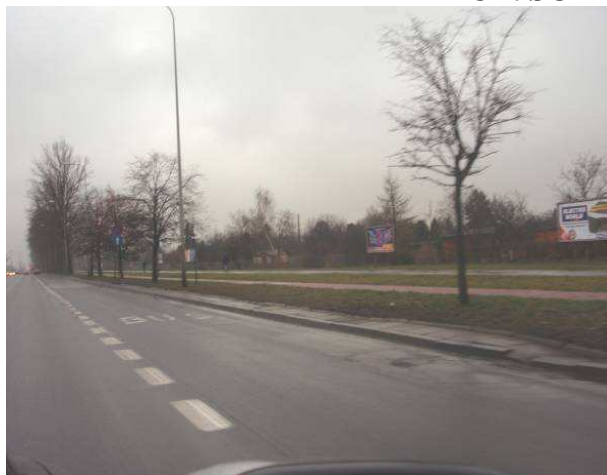
Fot. 1. Pas autobusowy, na odcinku pomiędzy ul. Gierymskiego a ul. Idzikowskiego.
