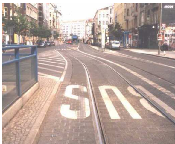
Fot. 79. Berlin - wspólne torowisko tramwajowo – autobusowe.
