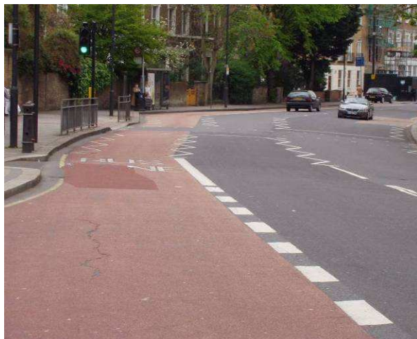
Fot. 55. Londyn, pas autobusowy wyznaczony za pomocą oznakowania poziomego z zastosowaniem nawierzchni w kolorze czerwonym
