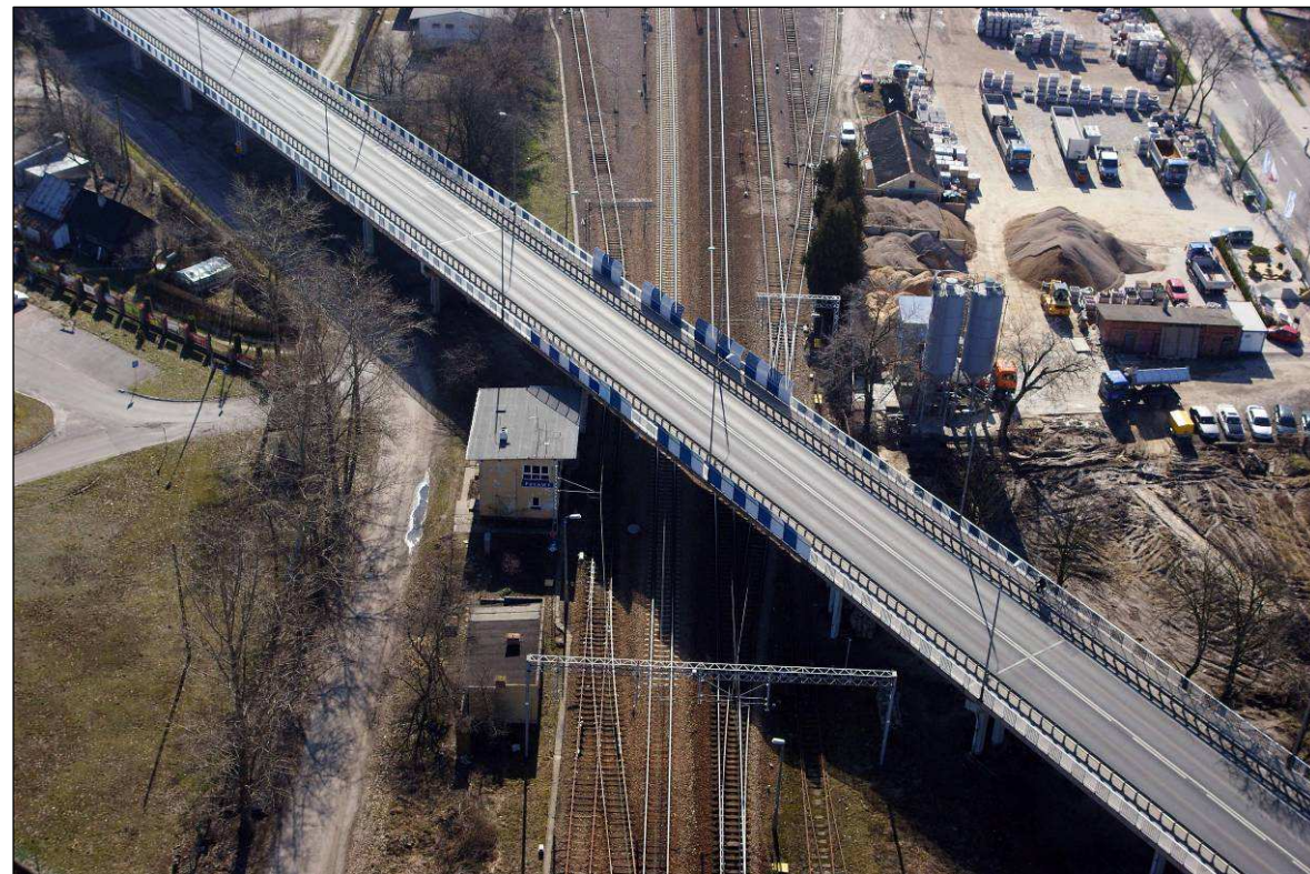
Fot. 3- 27 Wiadukt nad linią kolejową - skrzyżowanie z drogą wojewódzką nr 824 (km 124+188)
