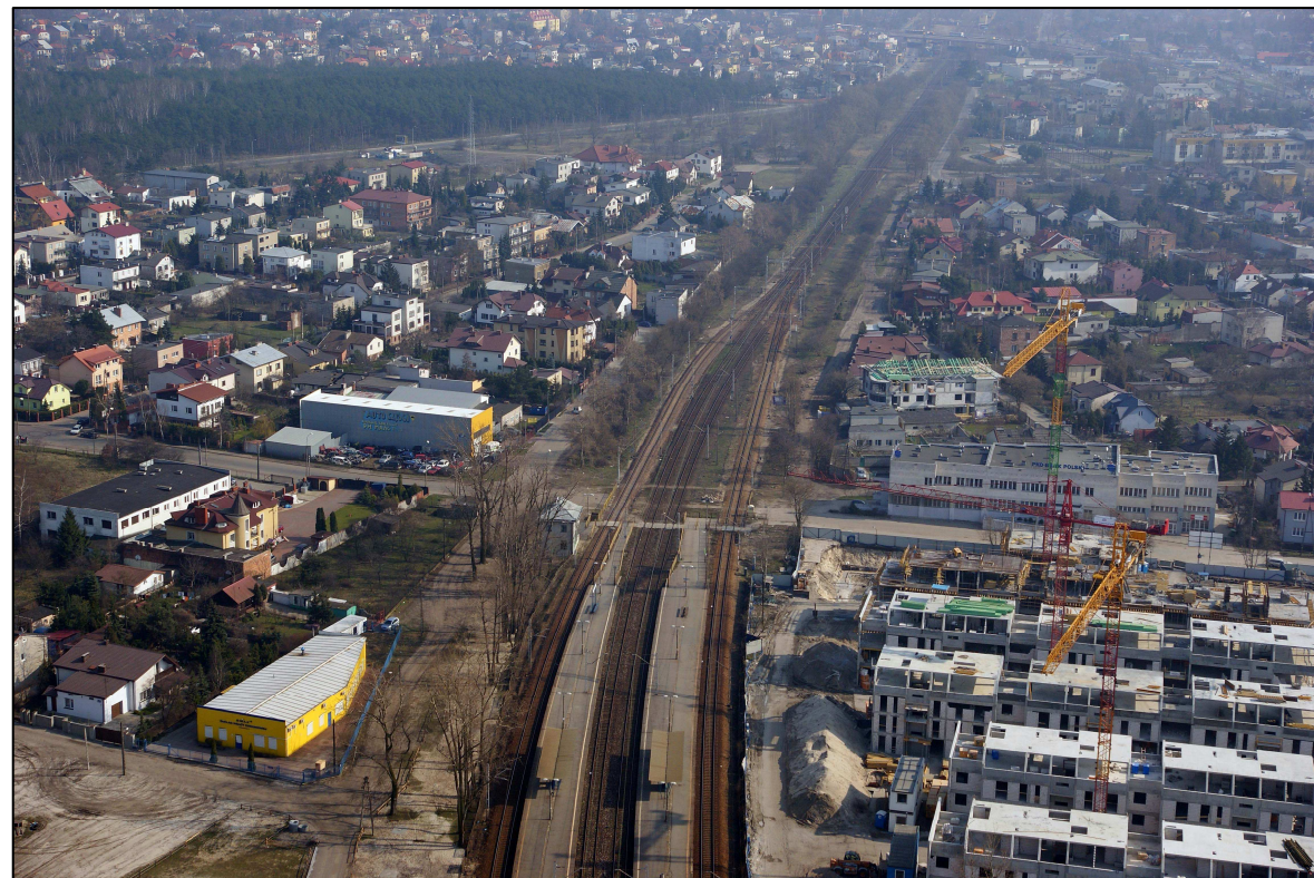
Fot. 3- 23 Marysin Wawerski – istniejąca i powstająca zabudowa mieszkaniowa (ok. km 11+000)
