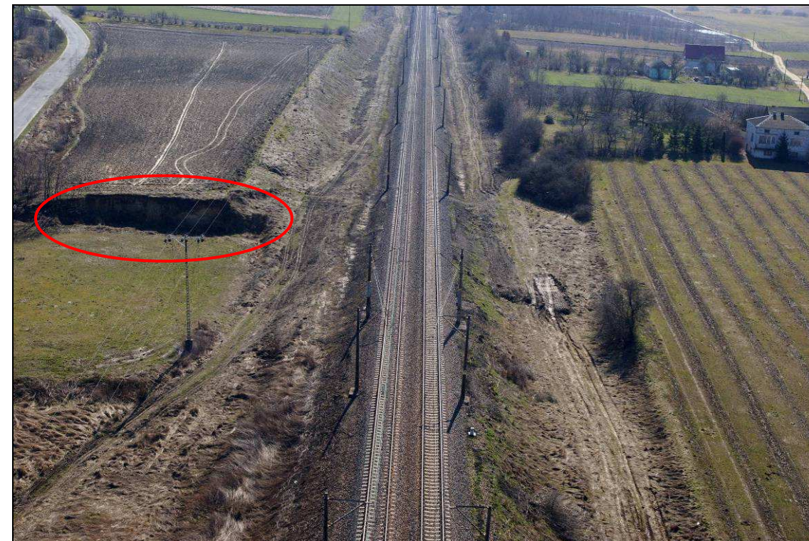
Fot. 11-4 Lokalizacja kolonii brzegówek - km 155+250
