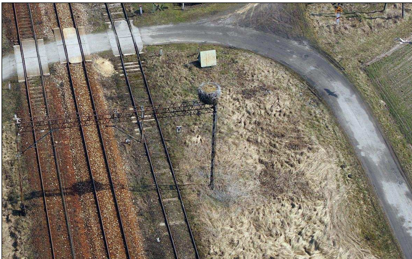
Fot. 3-13 Gniazdo bociana na trakcji km 262+550
