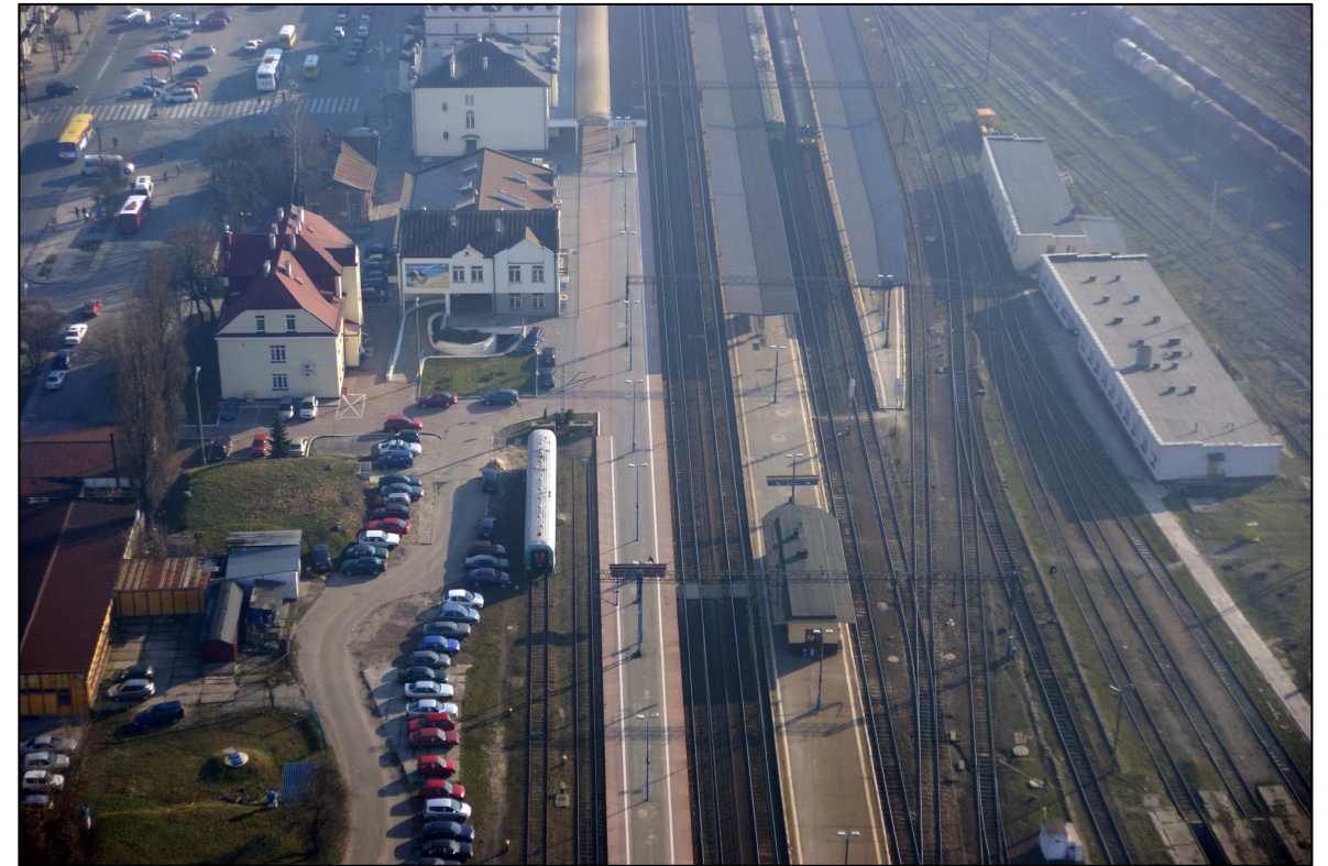
Fot. 3- 29 Miasto Lublin – stacja kolejowa (ok. km 175+000)
