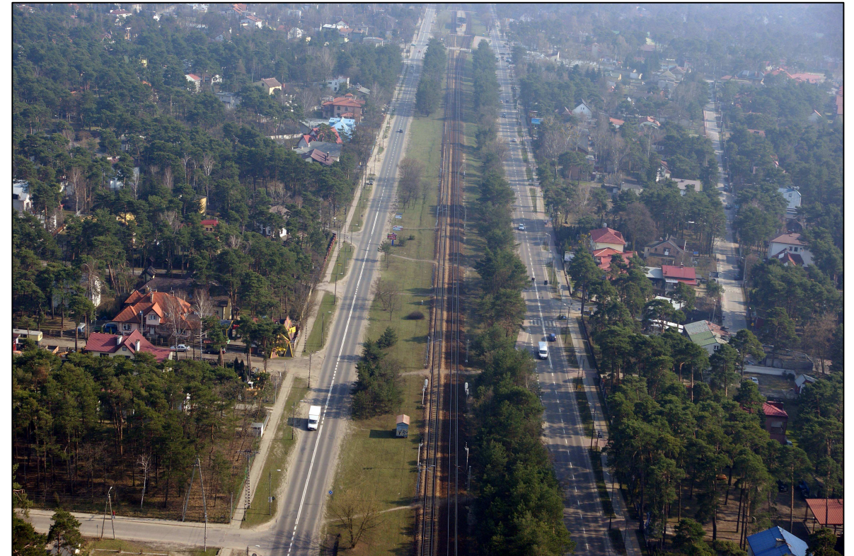
Fot. 3- 24 Miasto Otwock – przyległa do ciągów komunikacyjnych zabudowa jednorodzinna (km ok. 22+000)
