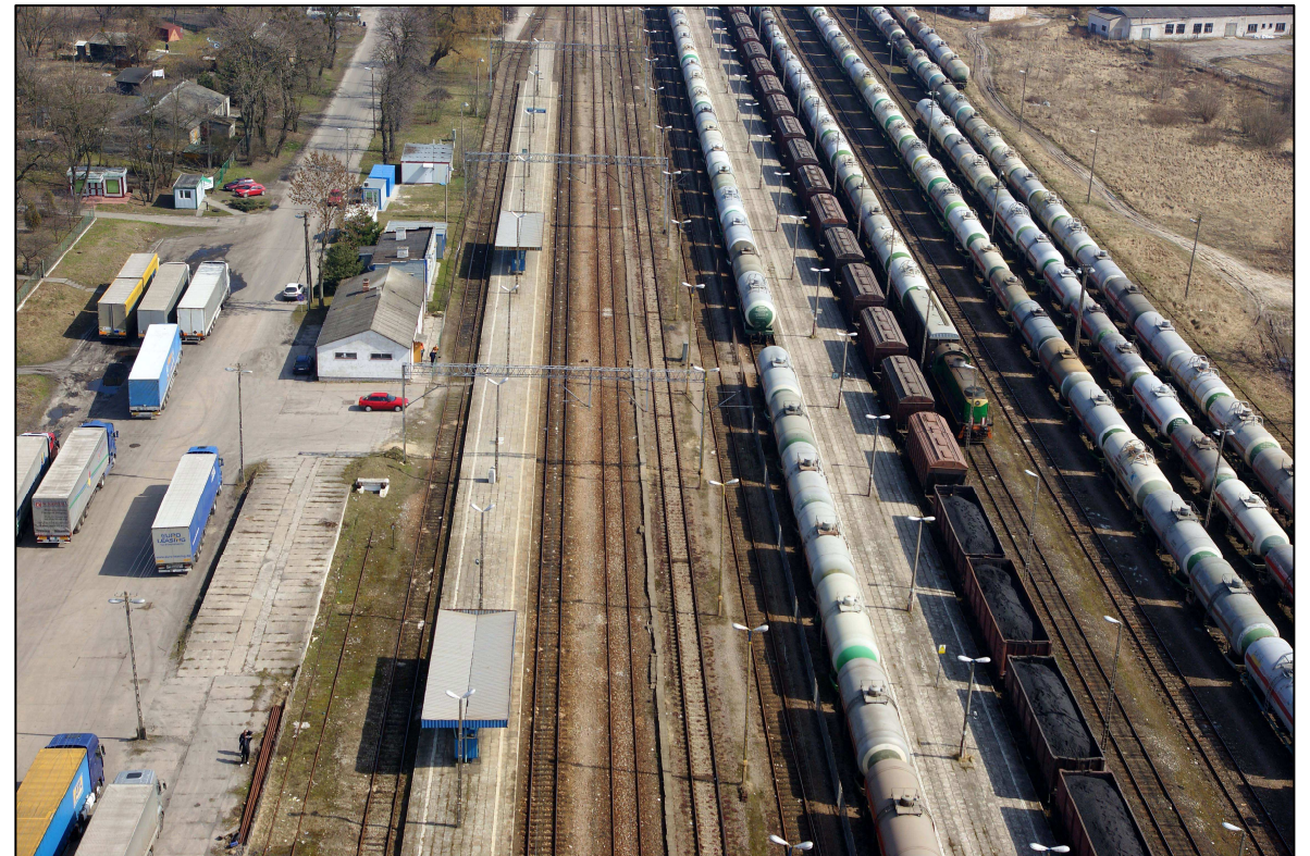
Fot. 3- 33 Stacja Dorohusk (ok. km 269+000)
