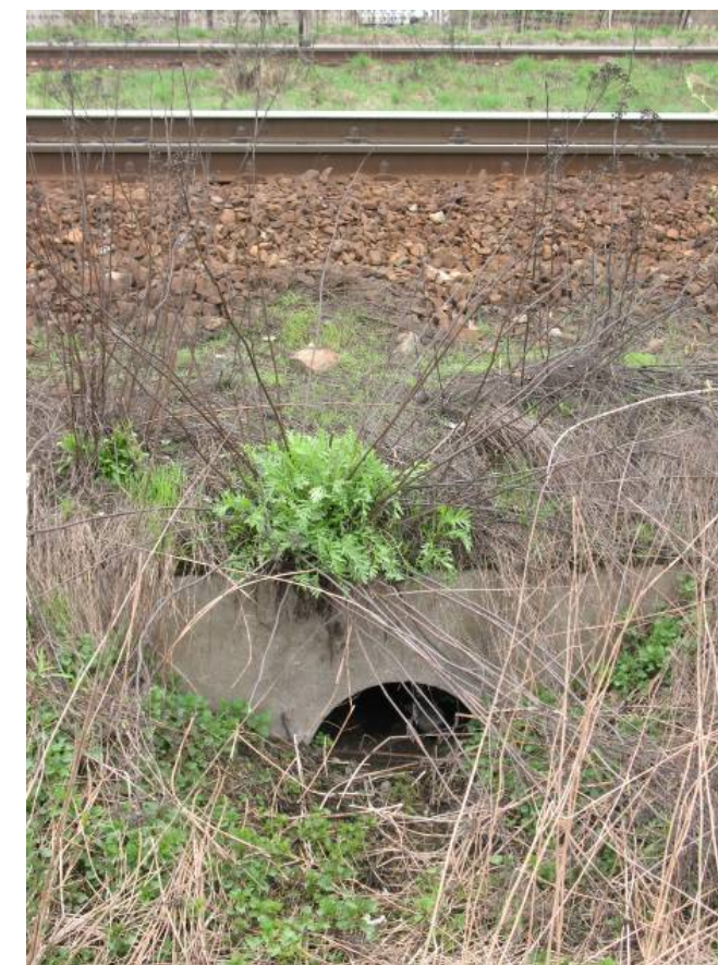
Fotografia 5 - 39 Przepust w km 8+210, linia nr 447
