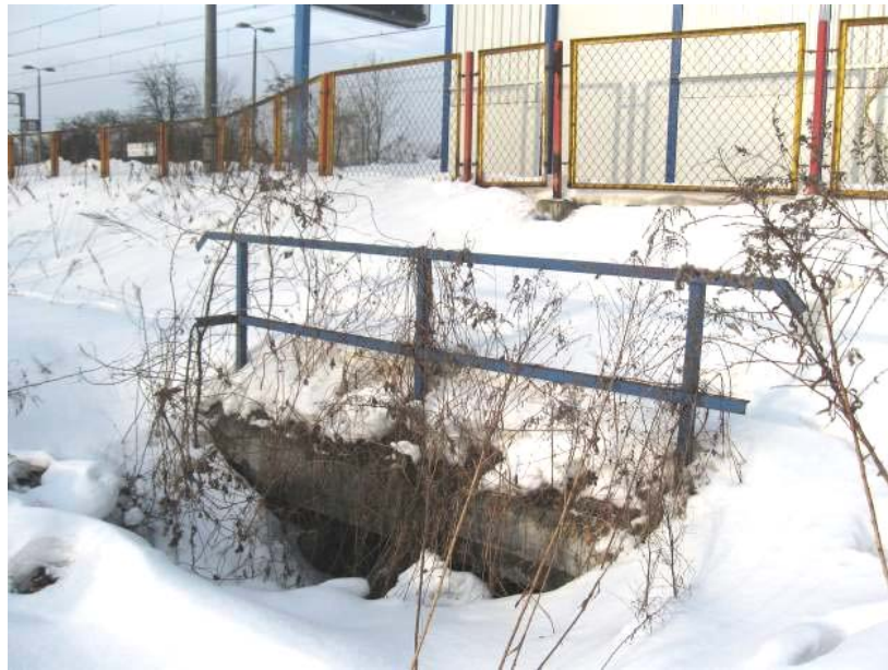
Fotografia 5 - 40 Przepust w km 21+725 na linii nr 2
