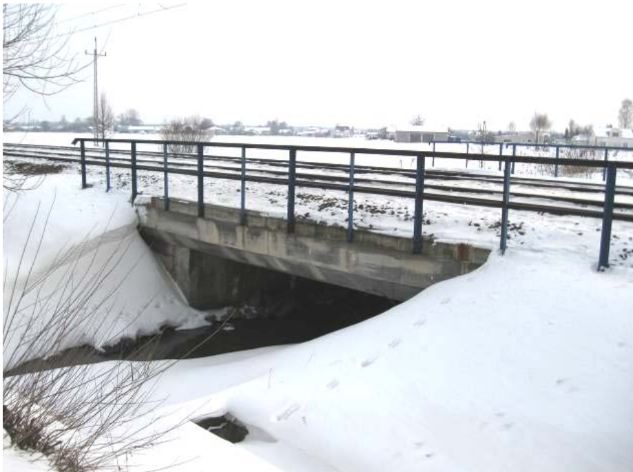
Fotografia 5 - 25 Most w km 31+801 linia nr 2
