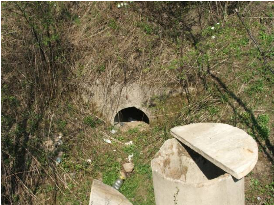
Fotografia 5 - 26 Przepust w km 9+608 linia nr 3
