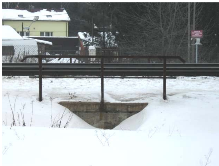
Fotografia 5 - 22 Przepust w km 19+100 linia nr 2
