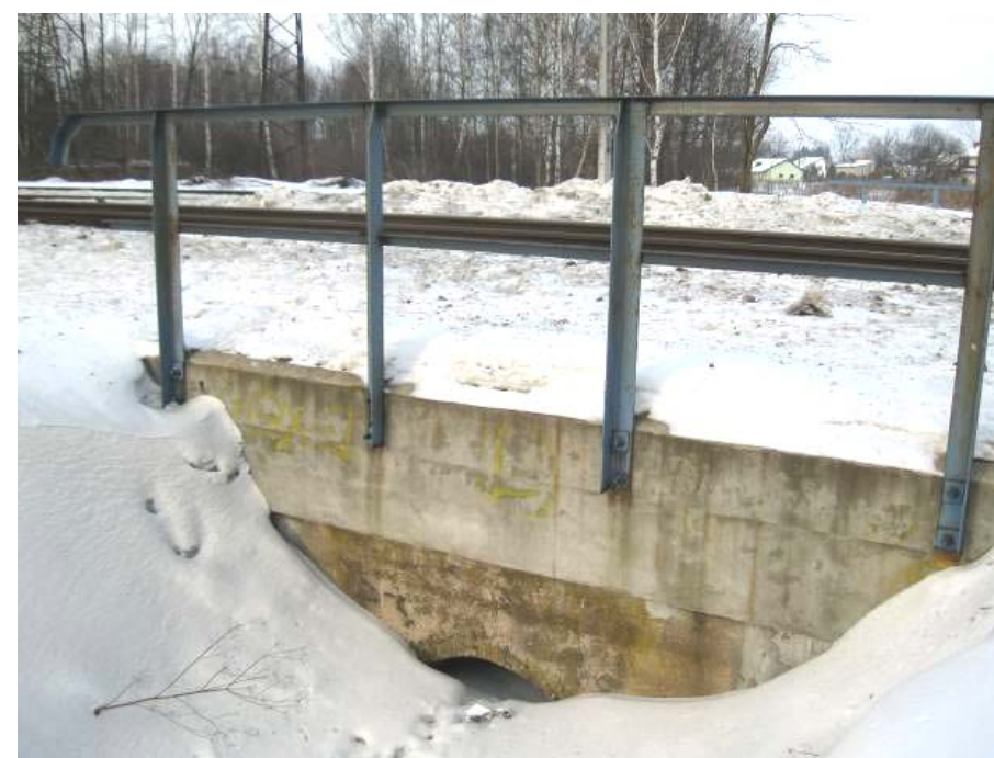
Fotografia 5 - 24 Przepust w km 22+430 linia nr 2
