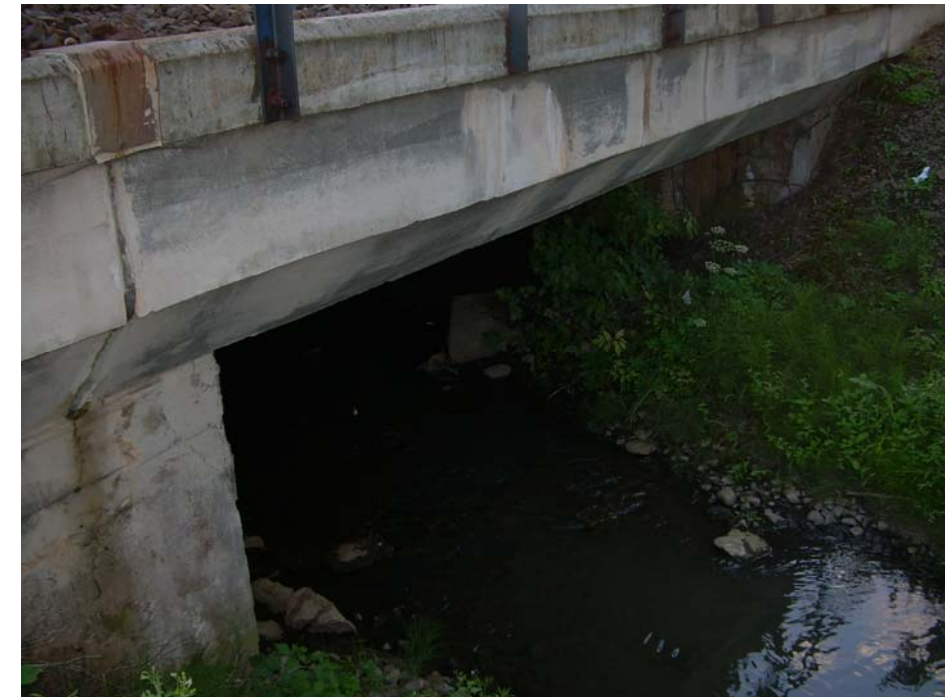
Fotografia 5 - 42 Most w km 31+801 na linii nr 2
