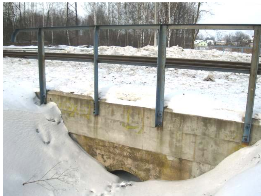
Fotografia 5 - 38 Przepust w km 22+430 na linii nr 2
