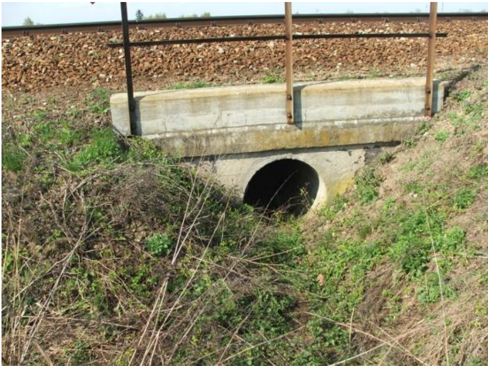
Fotografia 5 - 29 Przepust w km 22+460 linia nr 3
