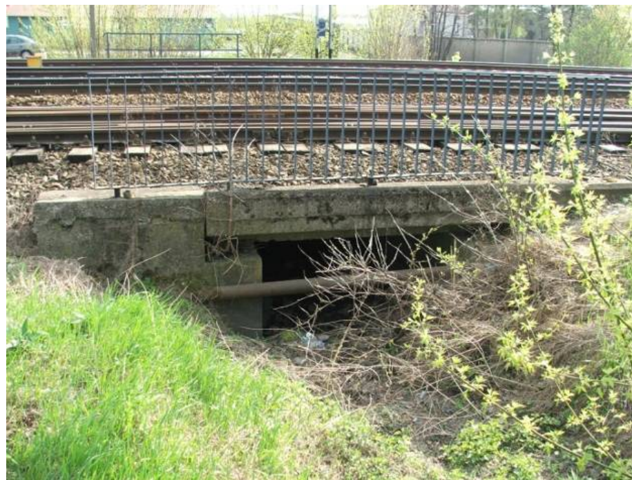
Fotografia 5 - 45 Przepust w km 14+672 linia nr 3
