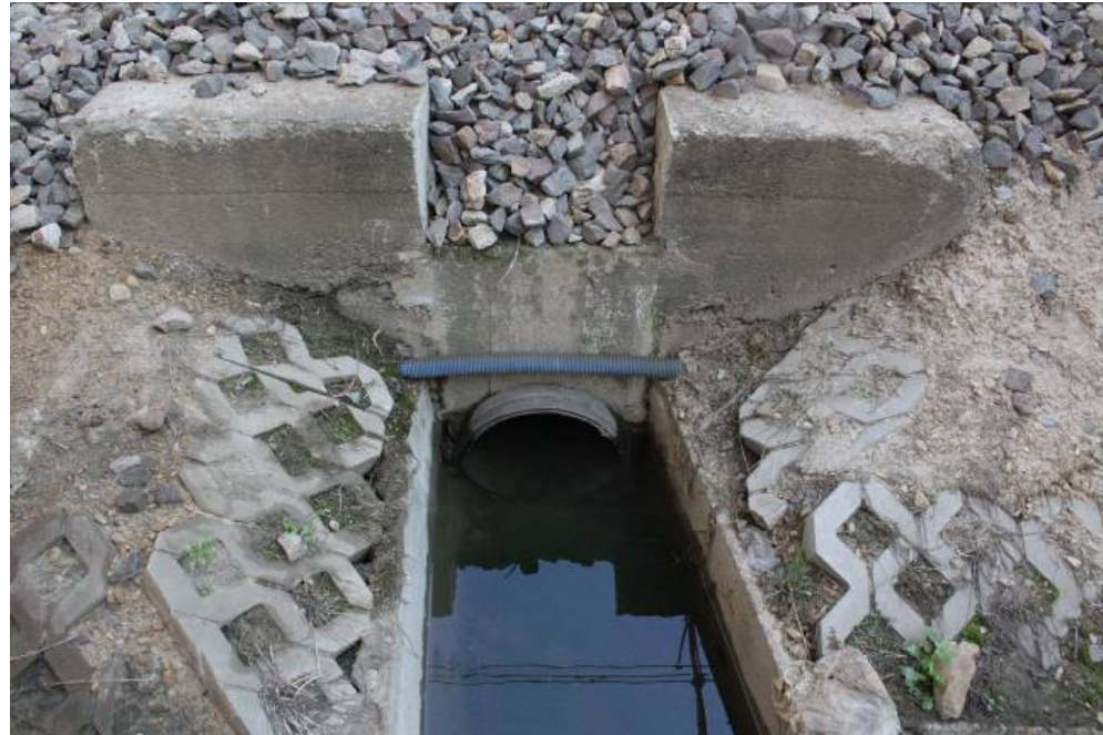
Fotografia 5 - 30 Przepust w km 6+792 linia nr 8
