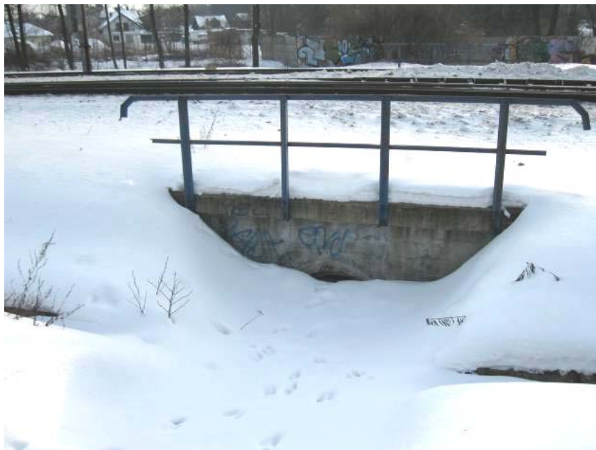
Fotografia 5 - 41 Przepust w km 22+430 na linii nr 2
