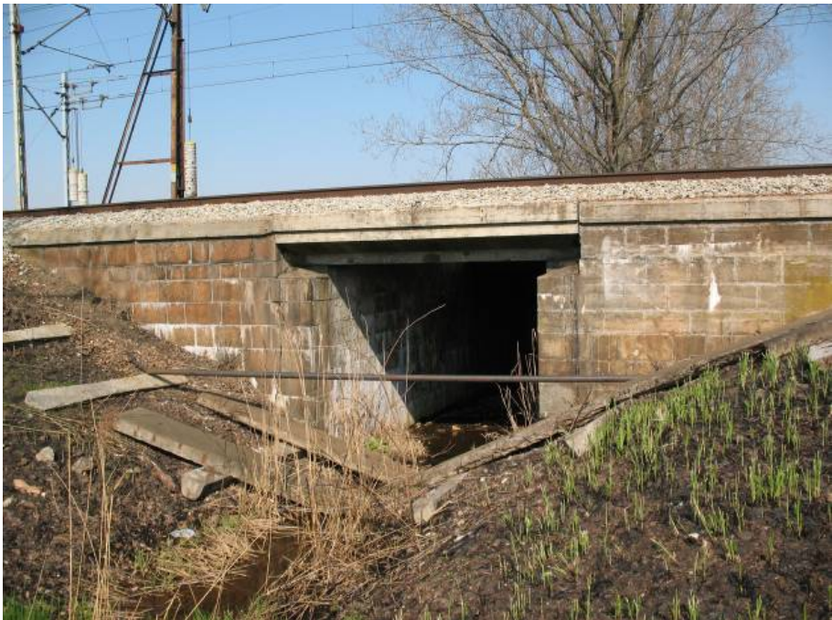
Fotografia 5 - 20 Most w km 23+527 linia nr 447
