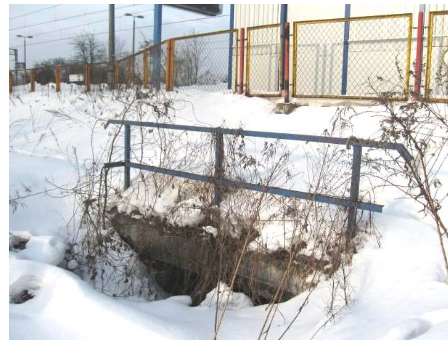
Fotografia 5 - 23 Przepust w km 21+725 linia nr 2
