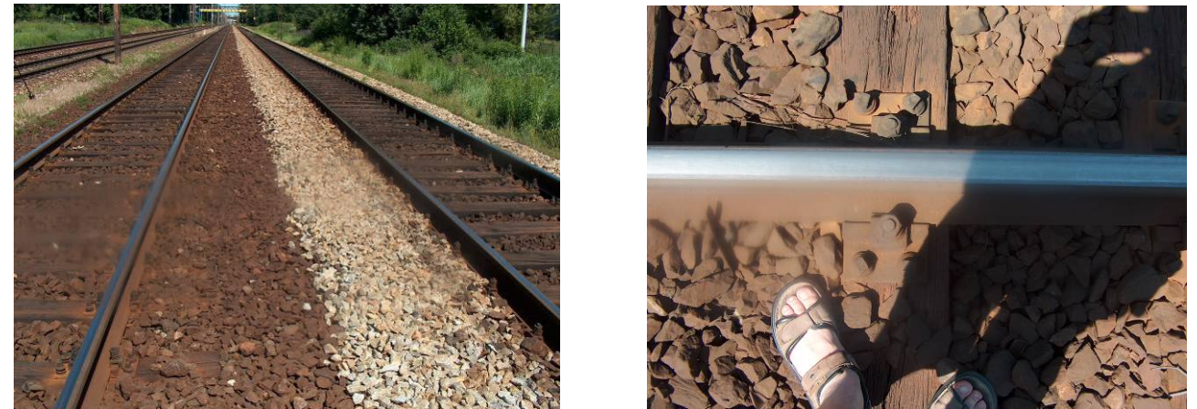
Fotografia 5 - 1 Miejsce wykonania pomiarów akustycznych wraz z zabudową wymagającą ochrony akustycznej (Milanówek ul. Bliska)
