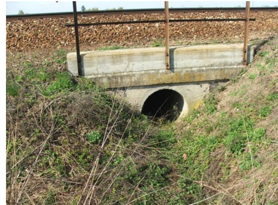
Fotografia 5 - 46 Przepust w km 22+460 na linii nr 3
