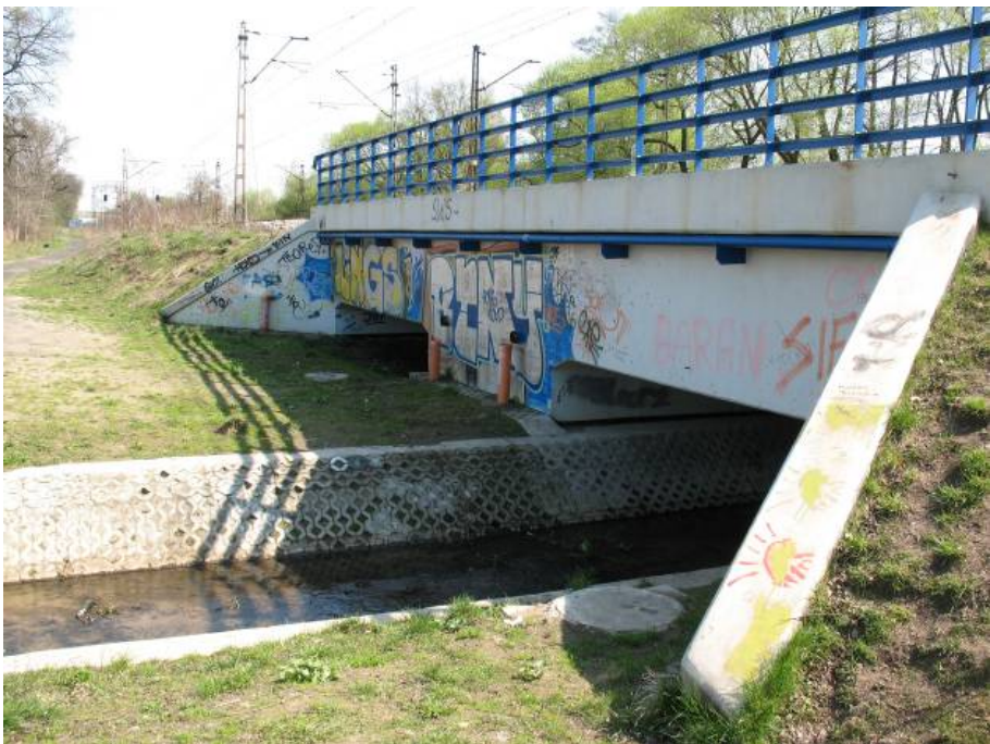
Fotografia 5 - 21 Most w km 27+168 linia nr 447
