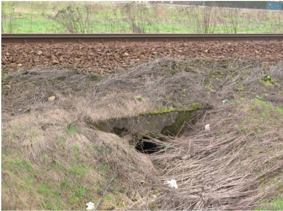
Fotografia 5 - 19 Przepust w km 8+210 linia nr 447
