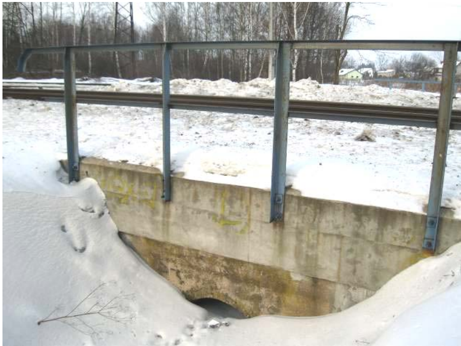
Fotografia 3- 3 Tropy kuny leśnej na trasie cieków – przepust na linii nr 2 km 22,430
