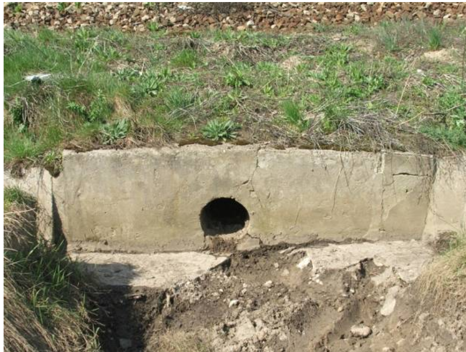
Fotografia 5 - 44 Przepust w km 10+227 na linii nr 3
