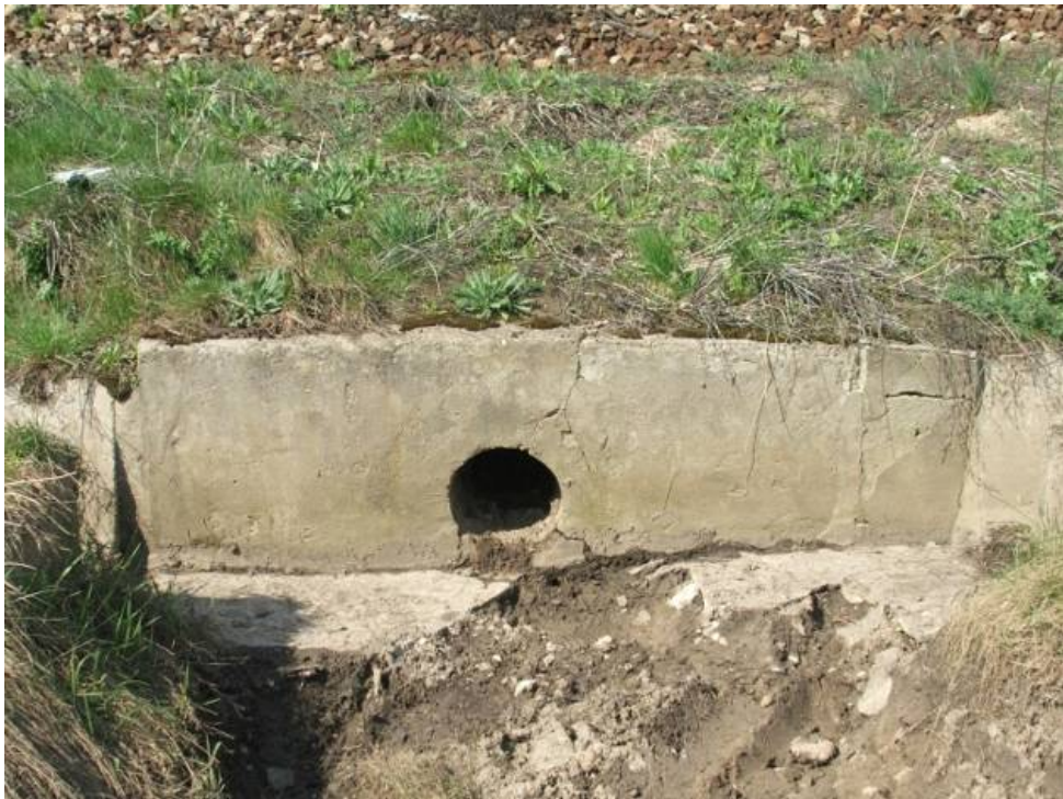
Fotografia 5 - 27 Przepust w km 10+227 linia nr 3
