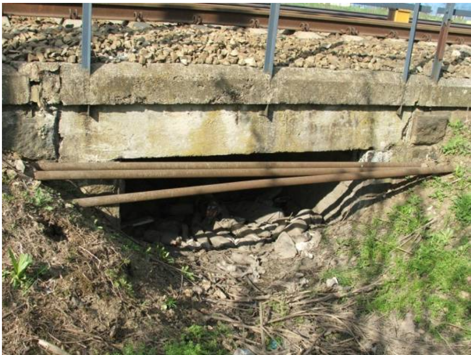
Fotografia 5 - 28 Przepust w km 14+672 linia nr 3
