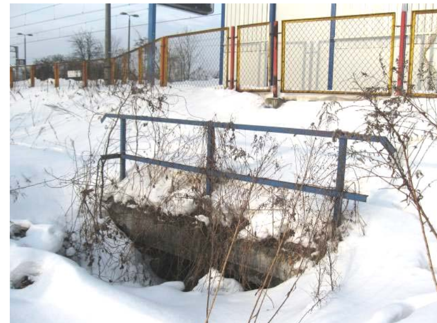
Fotografia 5 - 37 Przepust w km 21+725 na linii nr 2
