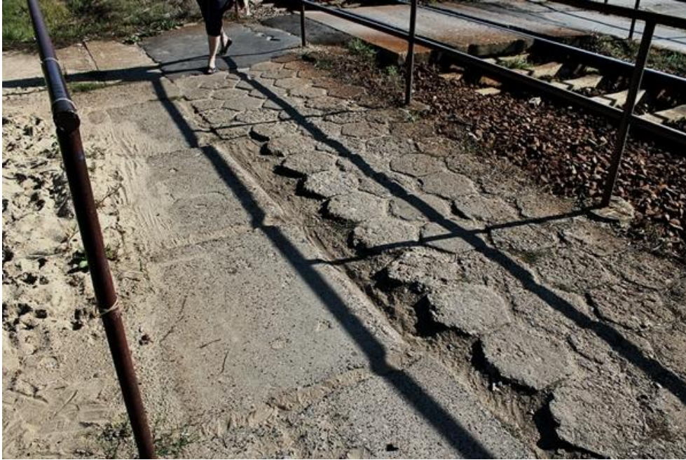
Zdjęcie 15 PKP Anin. Dziurawe przejście przez tory posiada 4 rodzaje nawierzchni
