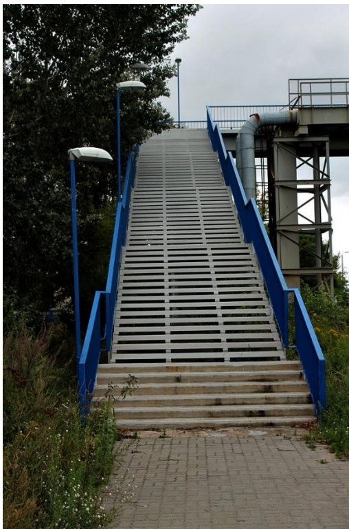
Zdjęcie 10PKP Praga. Niedawno wyremontowana kładka nie posiada żadnych ułatwień w dostępie. Oprócz niej na stację można dostać się także przejściem podziemnym.
