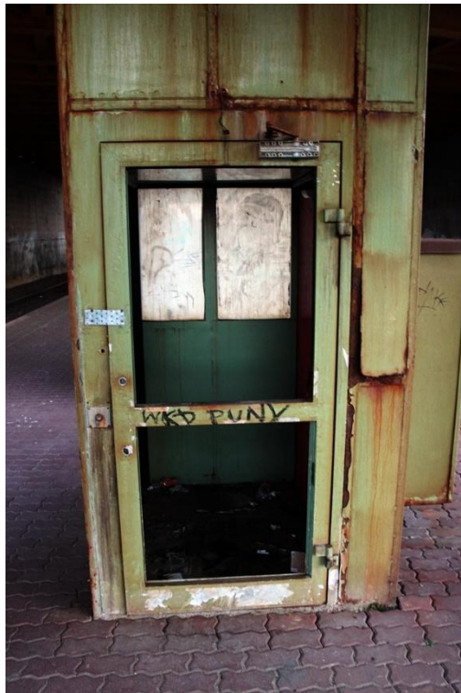
Zdjęcie 14 WKD Aleje Jerozolimskie. Zardzewiała kabina dźwigu, zaspawane drzwi i wybite szyby wskazują, że winda już od dawna jest niesprawna.
