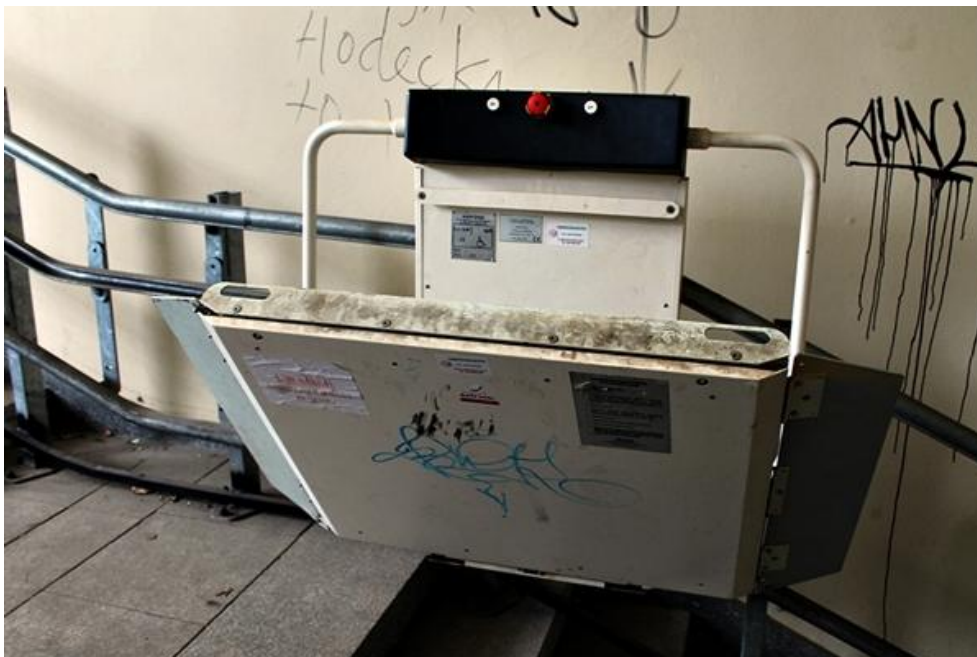
Zdjęcie 11 PKP Praga. Niesprawna platforma przyschodowa w przejściu podziemnym prowadzącym na peron
