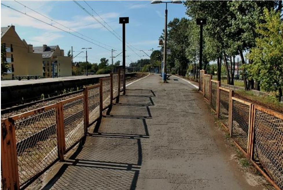
Zdjęcie 16 PKP Gołławek. Podjazd na peron jest w złym stanie technicznym, jego nachylenie jest zbyt strome, ponadto nie posiada odpowiednich poręczy.
