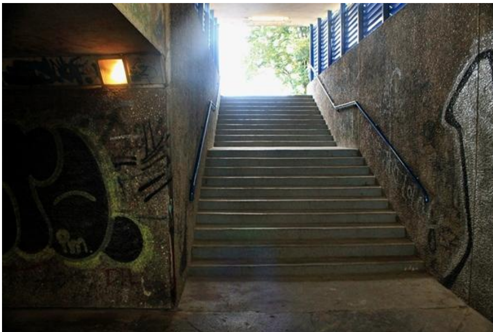
Zdjęcie 8 PKP Ursus. Przejścia podziemne przy przystanku kolejowym nie są w pełni dostępne z powodu schodów przy niektórych zejściach bez alternatywnych sposobów dostępu.
