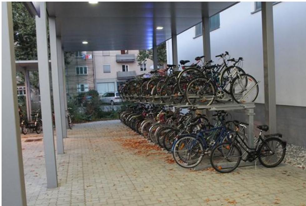
Zdjęcie 40 Graz. Prosty w budowie, dwupoziomowy parking rowerowy. Posiada zadaszenie oraz monitoring.
