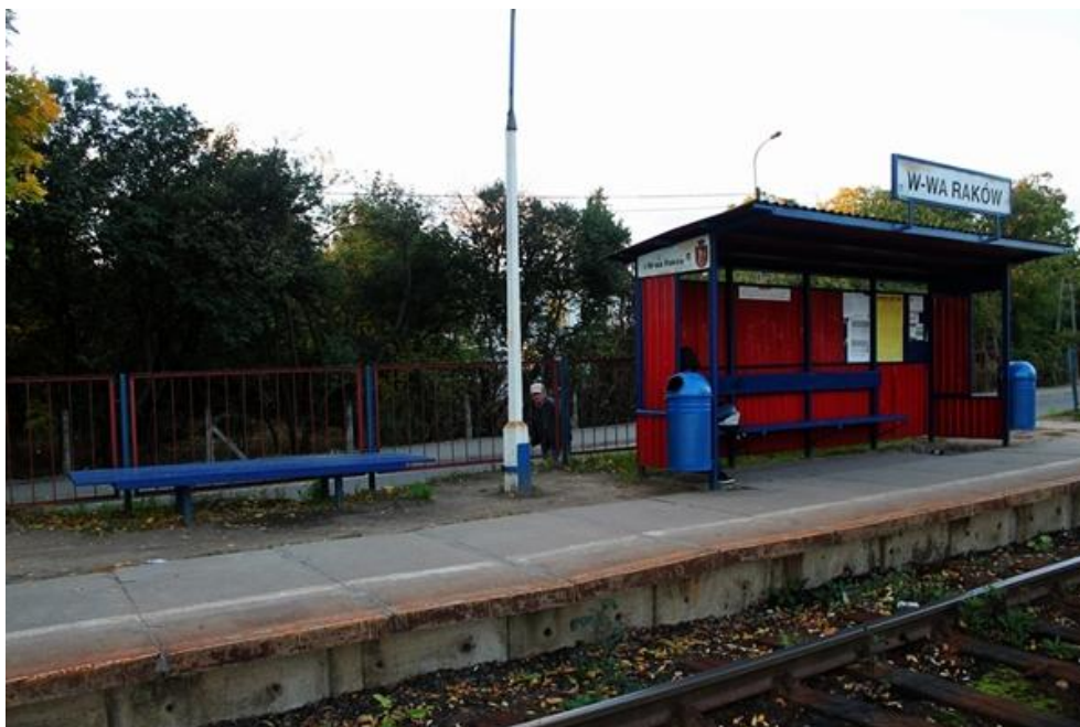
Zdjęcie 25 WKD Raków. Perony posiadają utwardzoną nawierzchnię jedynie w od strony krawędzi peronowej, poza tym mają nawierzchnię z ziemi.
