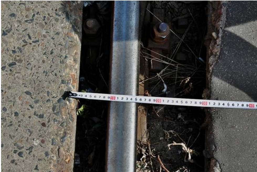
Zdjęcie 6 PKP Goławek. Dziura na wschodnim przejściu przez tory ma ponad 15 cm szerokości
