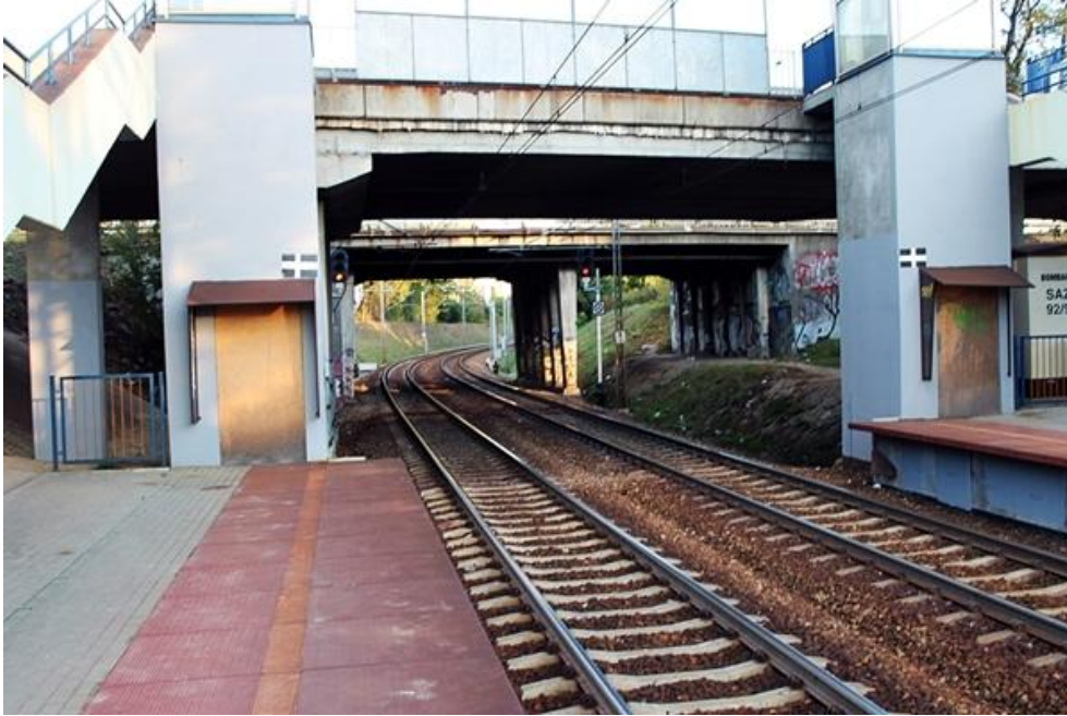
Zdjęcie 13 PKP Żwirki i Wigury. Wejścia do szybów windowych są zasłonięte dyktą
