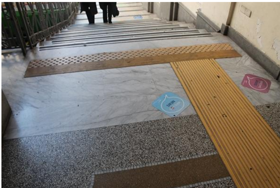
Zdjęcie 43 Przylepne ścieżki prowadzące są dobrze widoczne i tańsze w wykonaniu niż inne rozwiązania
