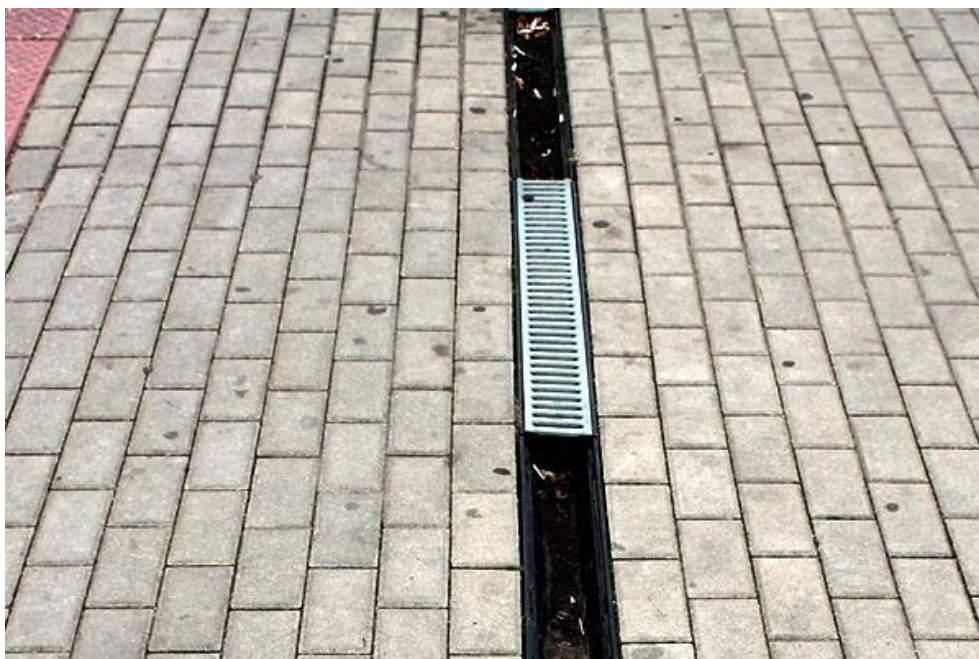
Zdjęcie 26 PKP Zoo. Brakuje kraterk zabezpieczających odpływ wody z peronu
