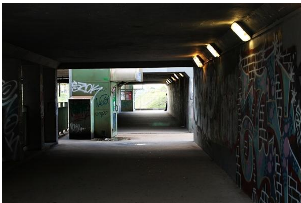
Zdjęcie 9 PKP Rakowiec. Nieprzyjemne przejście podziemne pod Aleją Krakowską.
