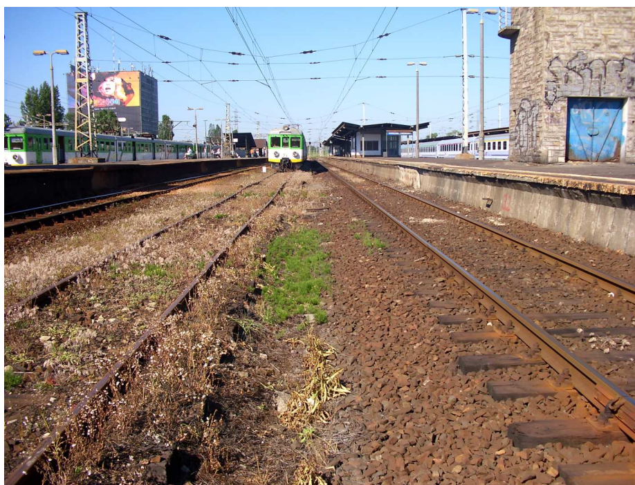
Fot. 2 Warszawa Zachodnia – stacja kolejowa
