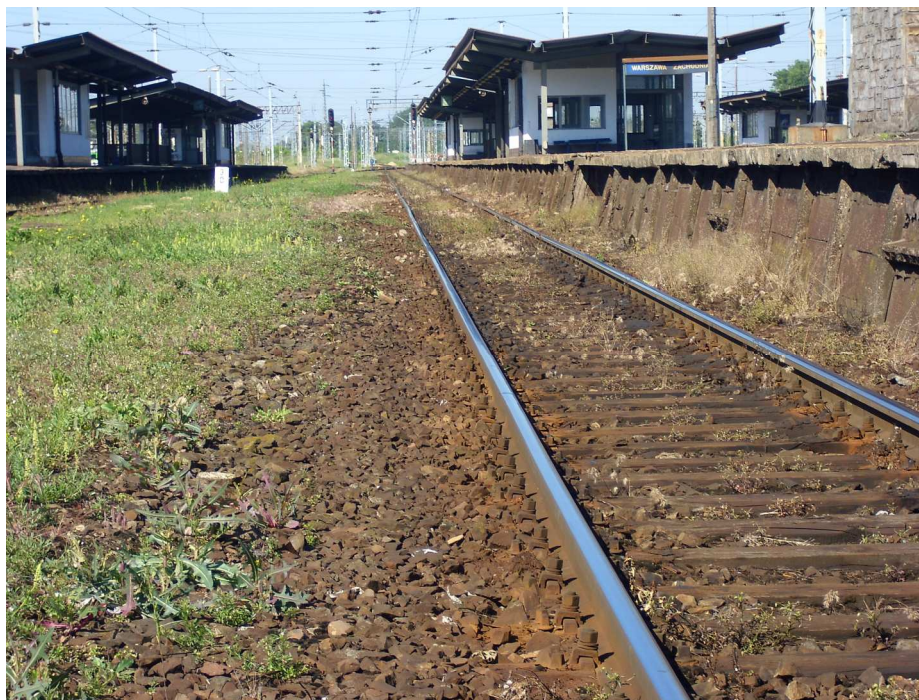
Fot 3. Warszawa Zachodnia – stacja kolejowa
