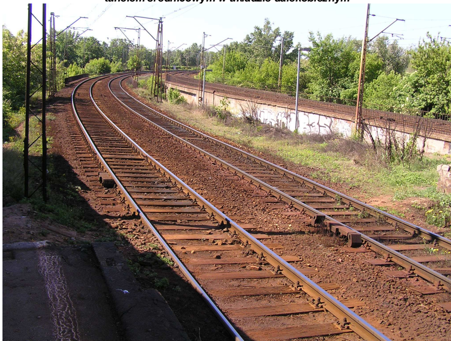
Fot. 11 Warszawa Stadion – linia kolejowa
