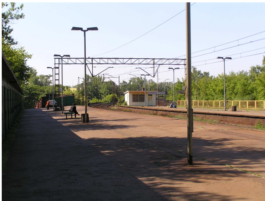
Fot. 10 Warszawa Stadion – stacja kolejowa
