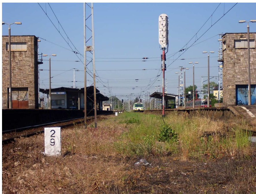
Fot. 4 Warszawa Zachodnia – stacja kolejowa
