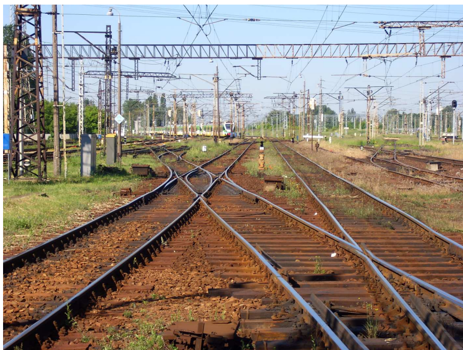
Fot. 1 Warszawa Zachodnia – początek opracowania
