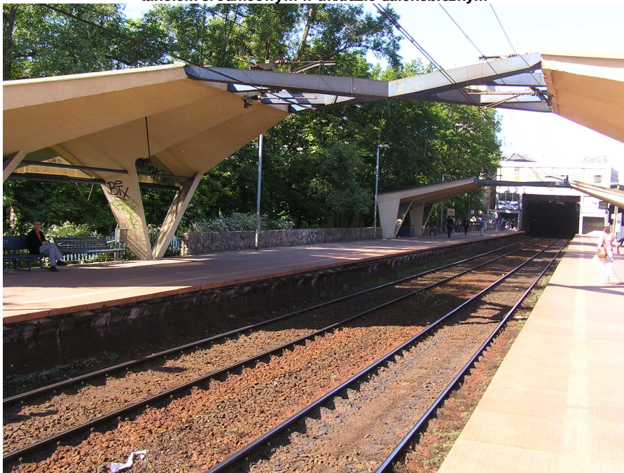
Fot. 7 Warszawa Powiśle – stacja kolejowa
