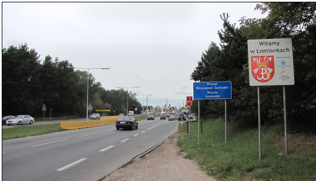
Rys. 26 – ul. Kolejowa, widok od strony południowej, w kierunku Łomianek (na wysokości granicy administracyjnej).
