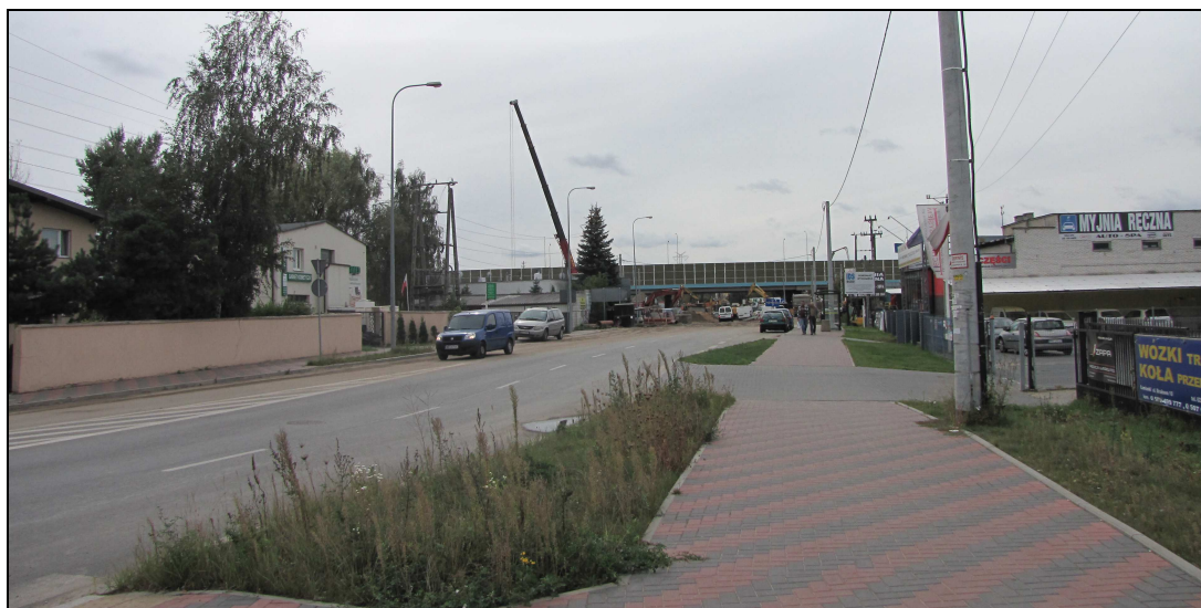
Rys. 30 – ul. Brukowa, widok od strony północnej, widok na estakadę (ul. Kolejową).
