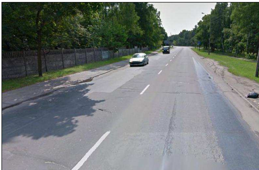
Rys. 13 – ul. Wóycickiego, widok od strony wschodniej.
