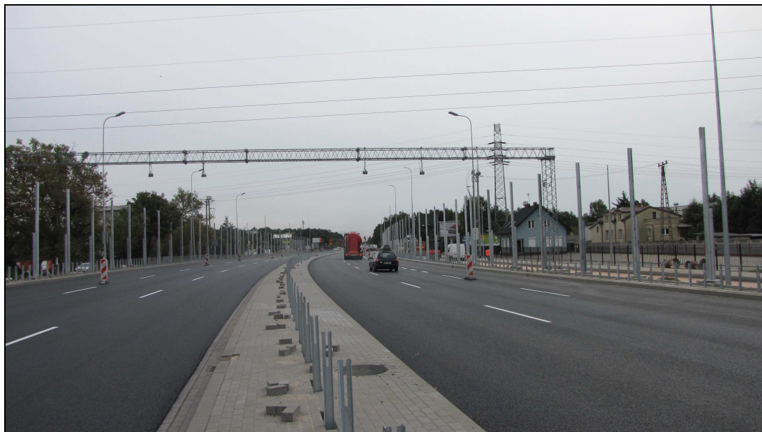
Rys. 29 – ul. Kolejowa, widok od strony zachodniej, w kierunku Warszawy.
