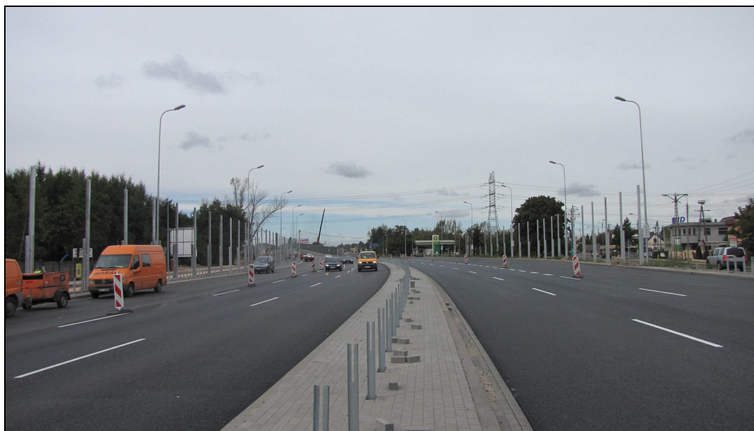
Rys. 28 – ul. Kolejowa, widok od strony wschodniej, widok na nowo wybudowaną estakadę.
