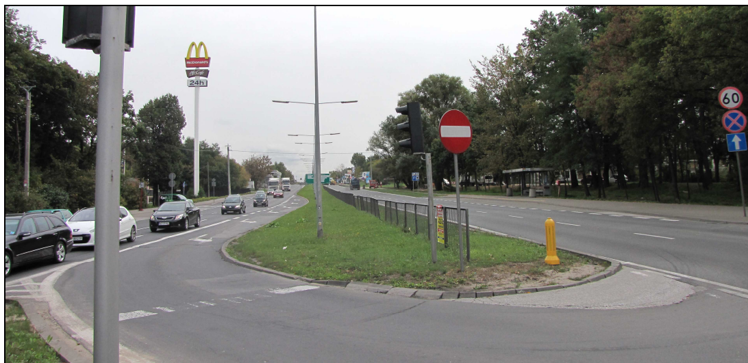
Rys. 5 – ul. Pułkowa, widok od strony południowo - wschodniej, na wysokości skrzyżowania ulic Pułkowa – Dzierżoniewskiego.
