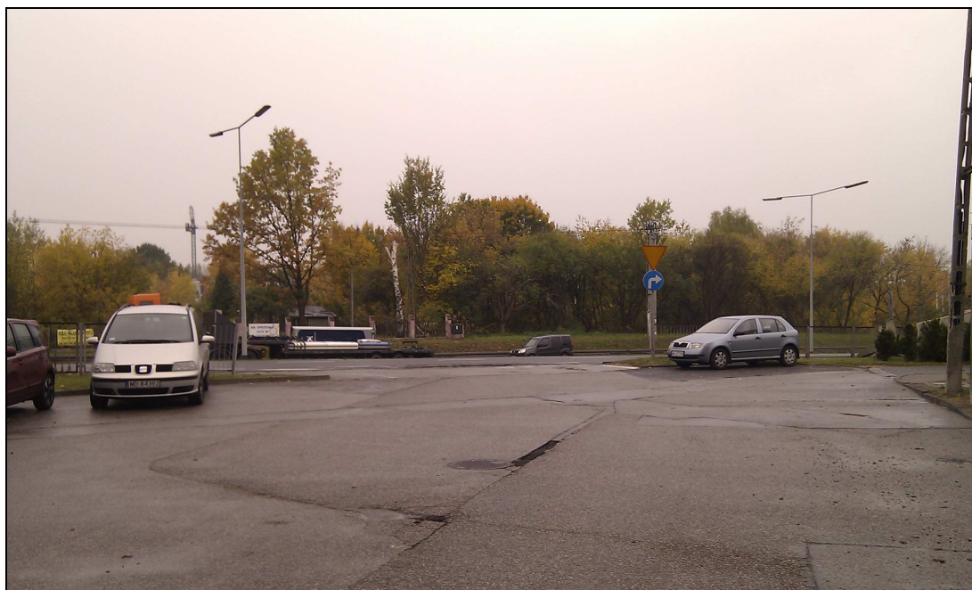
Rys. 19 – ul. Farysa, widok od strony wschodniej, na ul. Pułkową.
