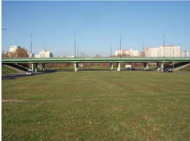
Fot. 8 Al. KEN okolice wiaduktu Dolina Służewieckiej.
