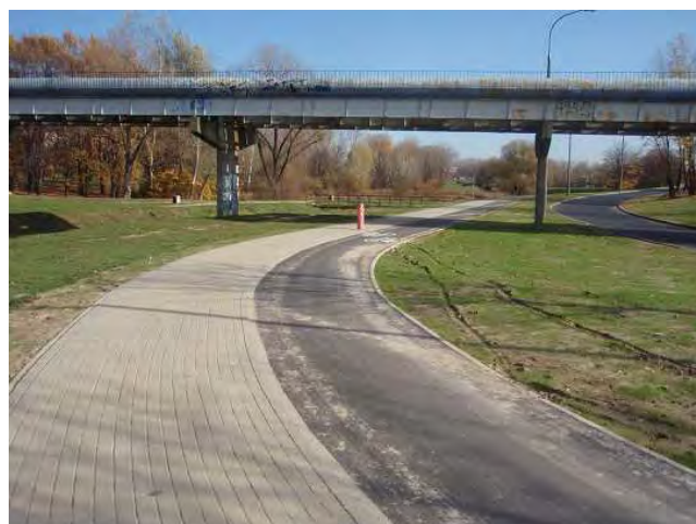
Fot. 5 Ścieżka rowerowa o nawierzchni bitumicznej w Parku Dolina Służewska.
