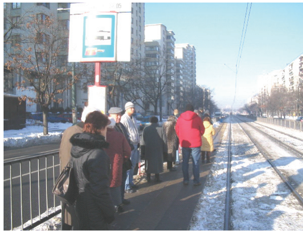
Fot. 23. Przystanek Anielewicz 05 – szerokość (2,3m). Widoczna wąska platforma przystankowa bez wiaty.
