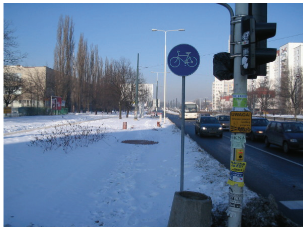
Fot. 29. Jezdnia zachodnia Al. Jana Pawła II na wysokości przystanku Anielewicza 05 . Widoczny przebieg tras uzbrojenia podziemnego, uniemożliwiającego poszerzenie jezdni.
