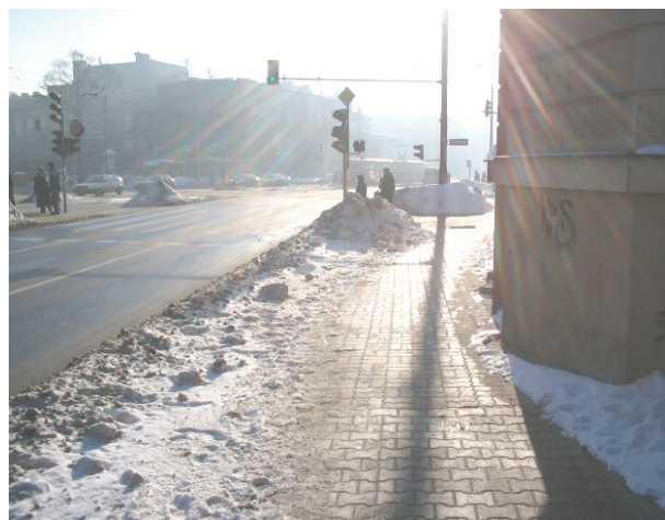
Fot. 14. Ul. Chałubińskiego, wlot od strony północnej na skrzyżowaniu z ul. Koszykową. Widoczne najwęższe miejsce pomiędzy krawędzią jezdni a budynkiem.
