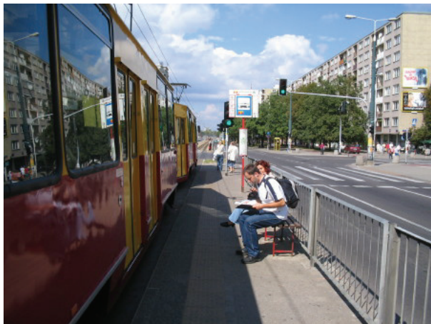
Fot. 22. Przystanek Anielewicz 06 – szerokość (2,4m). Widoczna wąska platforma przystankowa bez wiaty.
