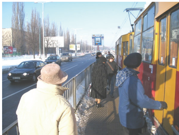
Fot. 27. Przystanek Stawki 05 – platforma przystankowa o szerokości 2,3m i bez wiaty.
