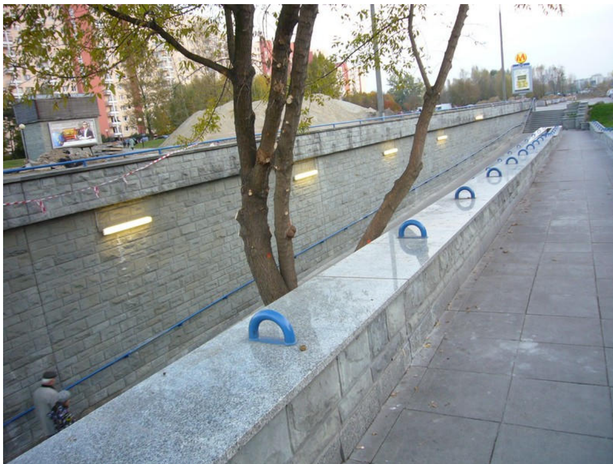
Fot. 1. Pochylnia dla niepełnosprawnych.
