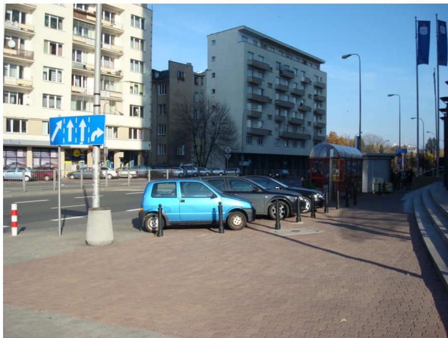
Fot. 8. Węzeł Pl. Unii Lubelskiej – miejsca parkingowe utrudniające poruszanie się po obszarze węzła.
