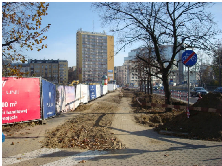
Fot. 1. Węzeł Pl. Unii Lubelskiej - widok wzdłuż ulicy Puławskiej (od strony zachodniej).
