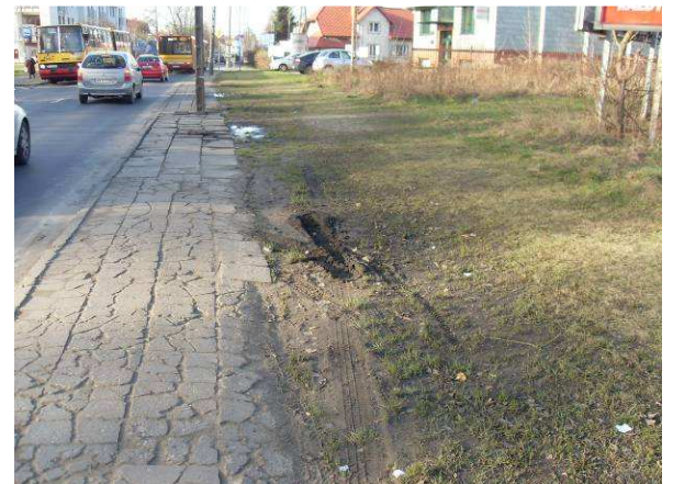
Istniejący stan chodników i poboczy
