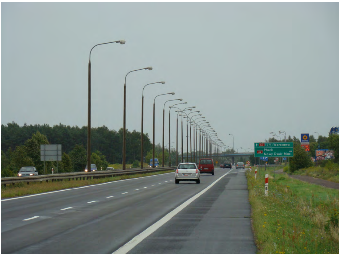
Fot. 16 Latarnie przy drodze istniejącej
