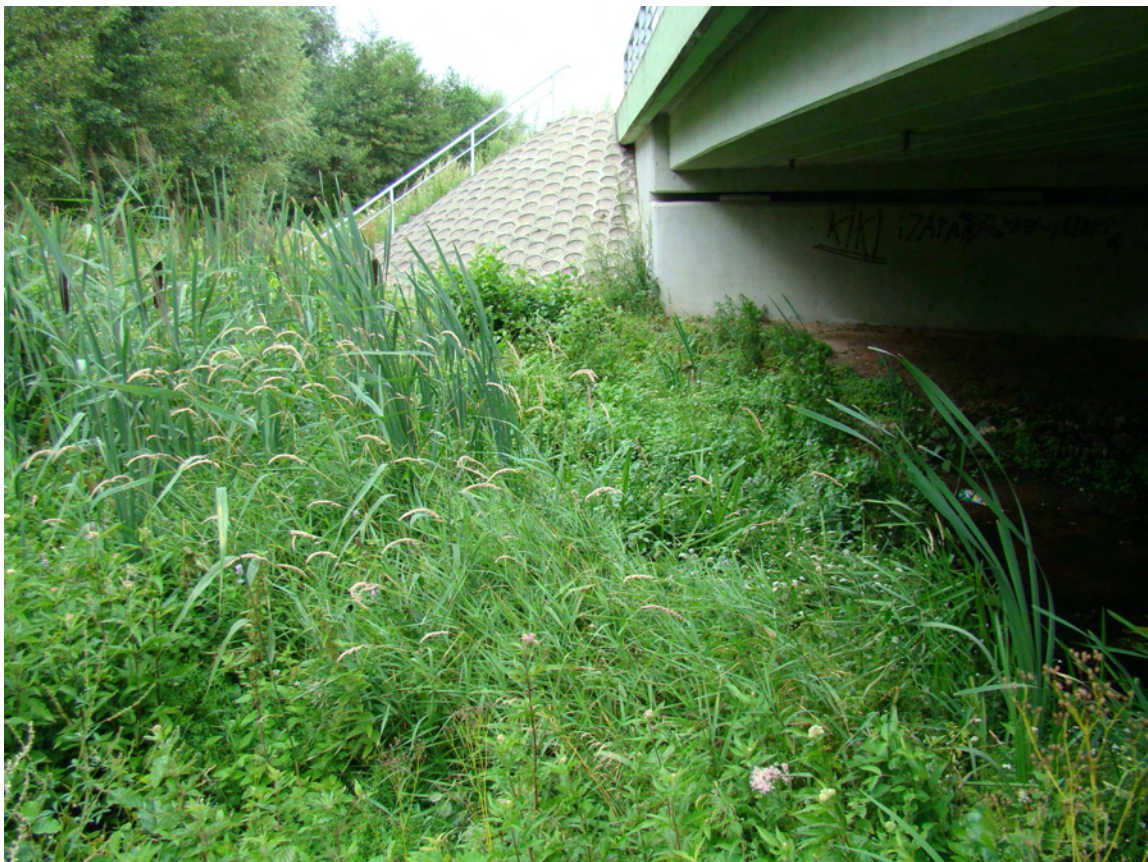
Fot. 5, 6 Most na Naruszewce
