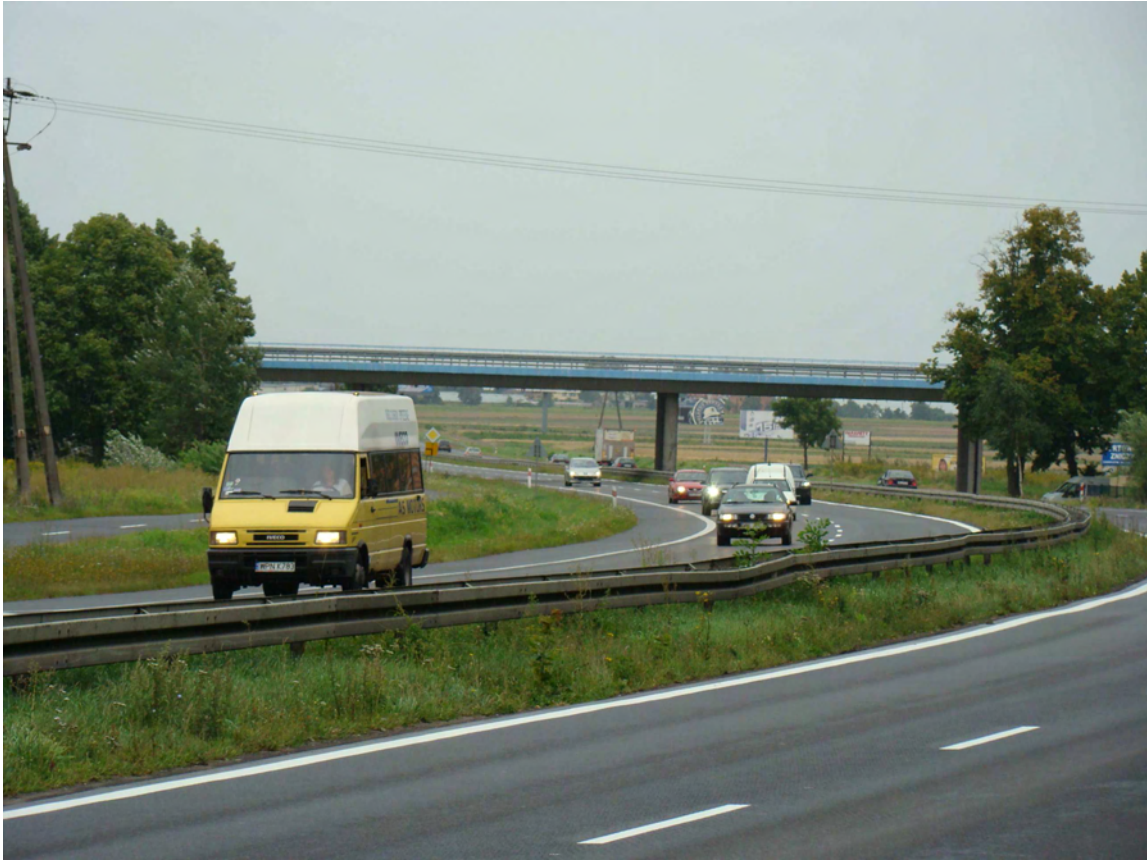
Fot. 15 Wiadukt w Ostrzykowie
