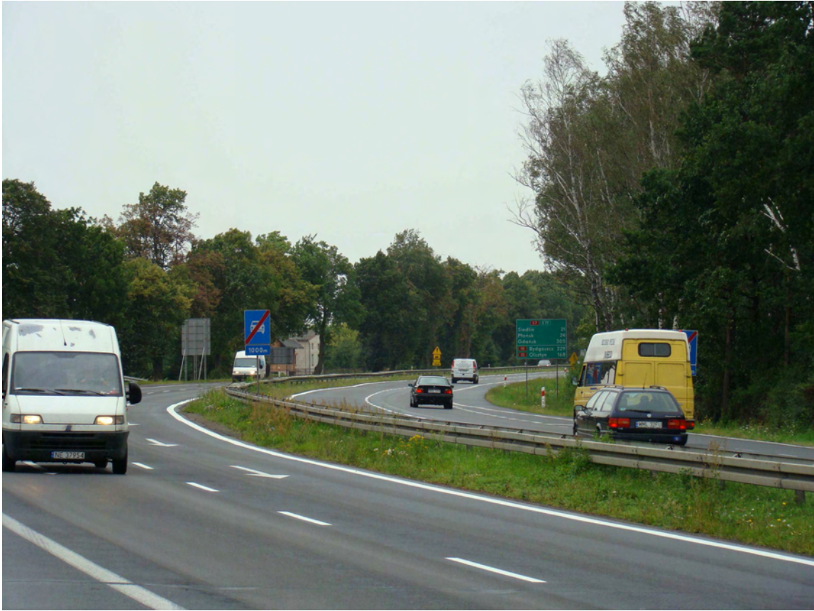
Fot. 21 Koniec istniejącej drogi ekspresowej w kierunku Płońska
