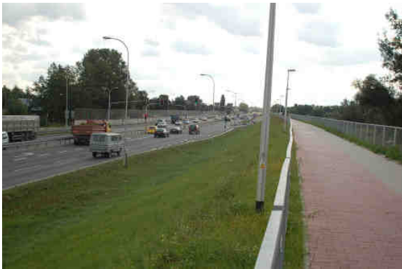
Fot. 5.11 Ul. Wał Miedzeszyński w rejonie węzła z trasą Na Zaporze
