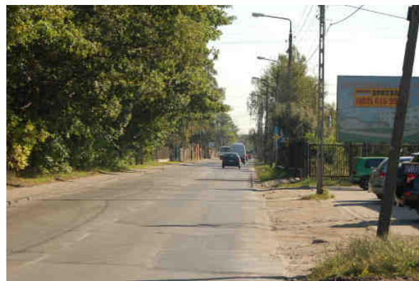
Fot. 4.4 Ulica Zwoleńska – widoczny stan techniczny nawierzchni
