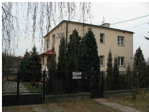
Fot.6.26 Kolizje z zabudową mieszkaniową – obiekt przy ul. Zwoleńskiej 106 (WI)
