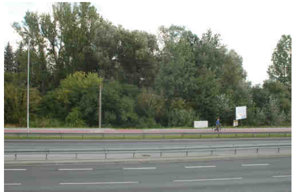
Fot. 5.12 Widok wzdłuż Trasy Na Zaporze w kierunku Wschodnim (przejście nad Wałem Miedzeszyńskim)
