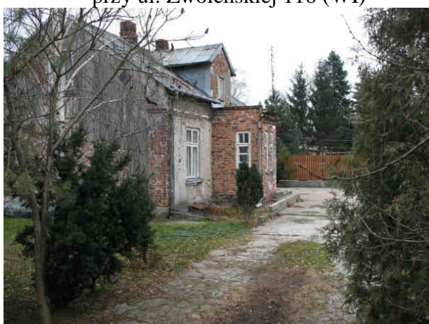
Fot.6.33 Kolizje z zabudową mieszkaniową – obiekt przy ul. Mrówcza 171 (WI)
