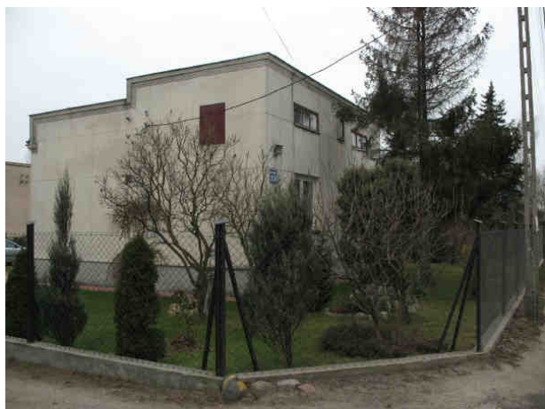
Fot.6.25 Kolizje z zabudową mieszkaniową – obiekt przy ul. Zwoleńskiej 104 (WI)
