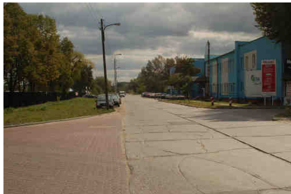
Fot. 4.2 Ulica Zawodzie – widoczny zły stan techniczny nawierzchni
