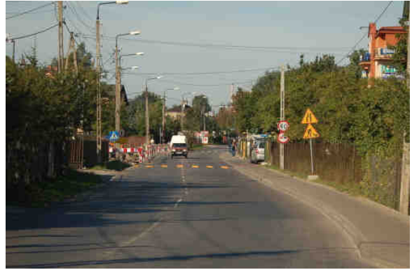
Fot. 5.20 Ul. Zwoleńska w rejonie ul. Mrówczej widok w kierunku zachodnim
