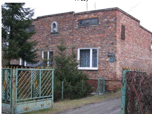
Fot.6.7 Kolizja z zabudową mieszkaniową – obiekt przy ul. Panoramy 58 (WI, WII)
