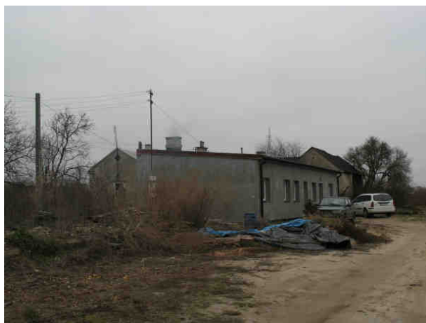
Fot.6.6 Kolizja z zabudową mieszkaniową i gospodarczą – obiekt przy ul. Panoramy 56a (WI, WII)
