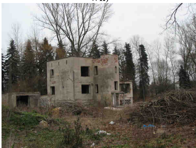
Fot.6.14 Kolizja z zabudową – obiekt tymczasowy przy ul. Wał Miedzeszyński 376 (WI, WII)
