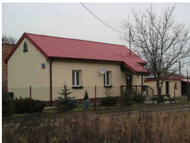
Fot.6.5 Kolizja z zabudową mieszkaniową i gospodarczą – obiekt przy ul. Panoramy 56 (WI, WII)
