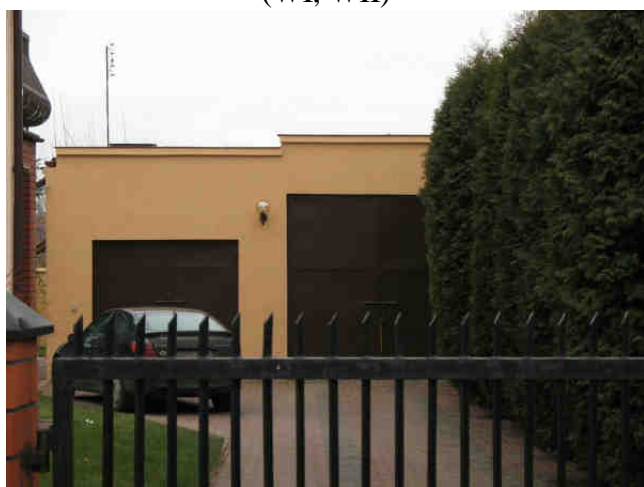
Fot.6.20 Kolizja z garażem – obiekt przy ul. Zwoleńskiej 92b (WI)
