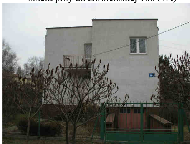
Fot.6.28 Kolizje z zabudową mieszkaniową – obiekt przy ul. Zwoleńskiej 108 (WI)
