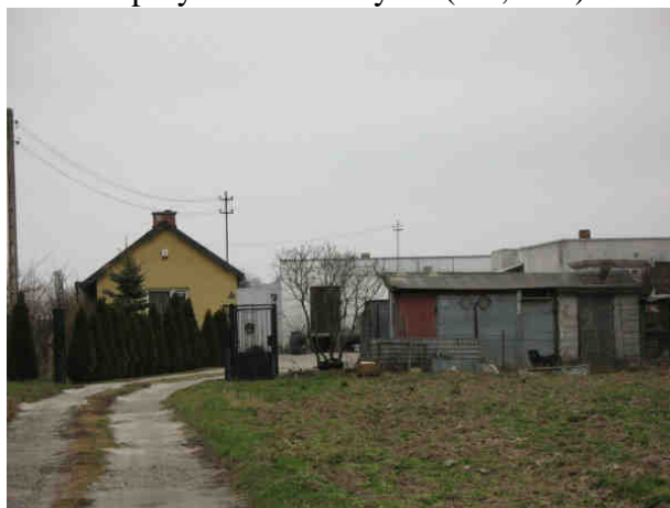
Fot.6.10 Kolizja z zabudową mieszkaniową i gospodarczą – obiekt przy ul. Panoramy 62a (WI, WII)
