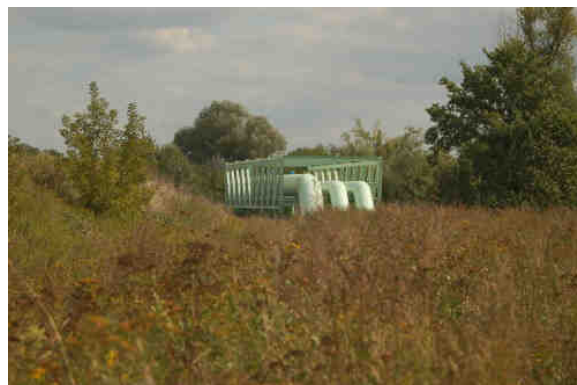
Fot. 5.4 Widok na przejście sanitarnych przewodów tłocznych nad rzeką Wilanówką
