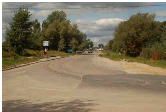
Fot. 5.2 Widok ul. Zawodzie ze skrzyżowania z ul. Łuczniczą w kierunku zachodnim
