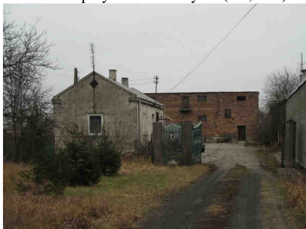
Fot.6.9 Kolizja z zabudową mieszkaniową i gospodarczą – obiekt przy ul. Panoramy 58a (WI, WII)
