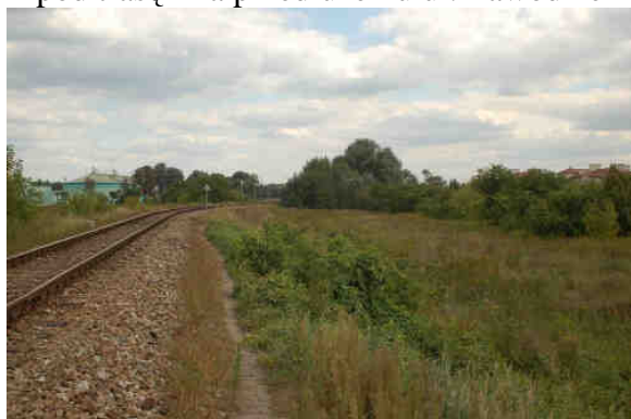
Fot. 5.5 Widok na pas terenu przeznaczony pod trasę wzdłuż łącznicy kolejowej do EC Siekierki
