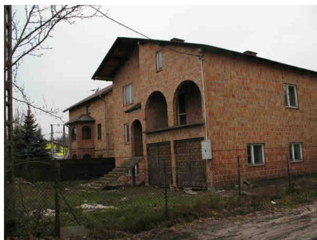
Fot.6.32 Kolizje z zabudową mieszkaniową – obiekt przy ul. Zwoleńskiej 120 (WI)
