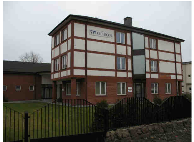
Fot.6.22 Kolizje z zabudową usługowo – biurową – obiekt przy ul. Zwoleńskiej 94a (WI)
