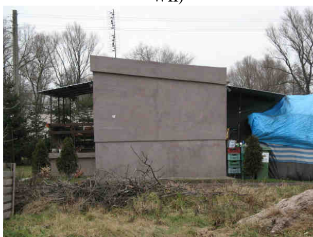
Fot.6.8 Kolizje z zabudową gospodarczą – obiekt przy ul. Panoramy 58 (WI, WII)
