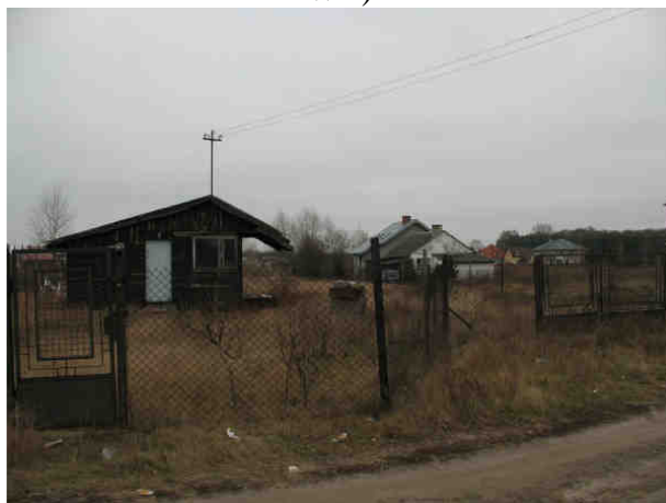
Fot.6.19 Kolizja z zabudową tymczasowa (letniskowa) – obiekt przy ul. Zwoleńskiej 50 (WI, WII)
