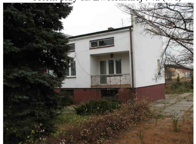
Fot.6.24 Kolizje z zabudową mieszkaniową – obiekt przy ul. Zwoleńskiej 102 (WI)
