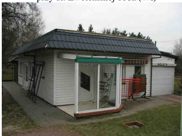
Fot.6.29 Kolizje z zabudową usługową – obiekt przy ul. Zwoleńskiej 114a (WI)
