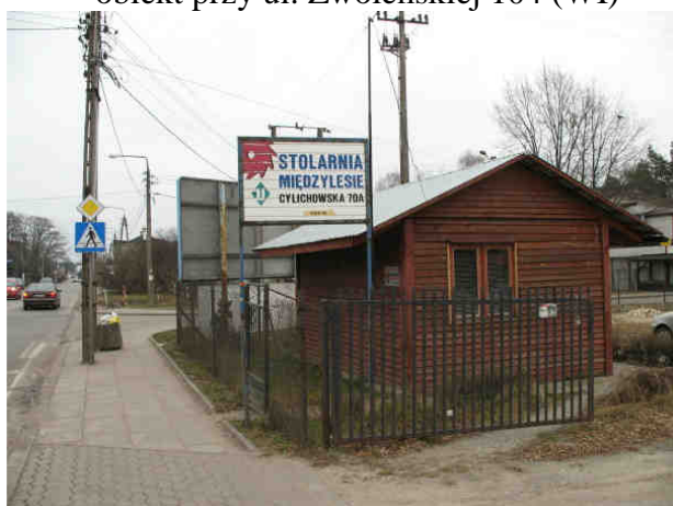
Fot.6.27 Kolizje z zabudową usługową – obiekt przy ul. Zwoleńskiej 106a (WI)
