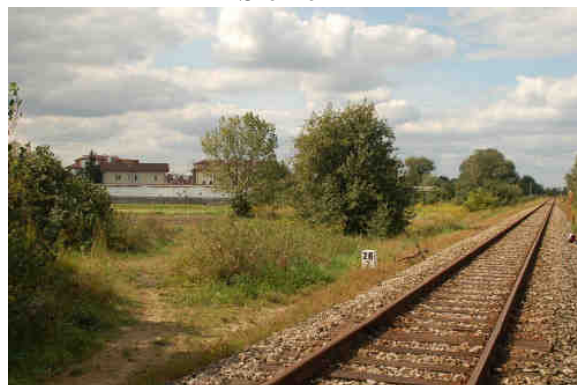
Fot. 5.8 Rejon przejścia trasy nad łącznicą kolejową - widok w kierunku zachodnim
