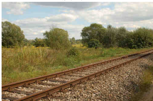
Fot. 5.7 Rejon przejścia trasy nad łącznicą kolejową - widok w kierunku wschodnim
