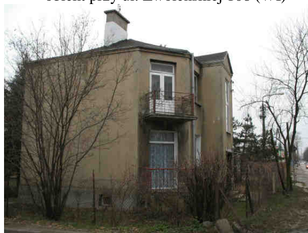
Fot.6.30 Kolizje z zabudową mieszkaniową – obiekt przy ul. Zwoleńskiej 114 (WI)
