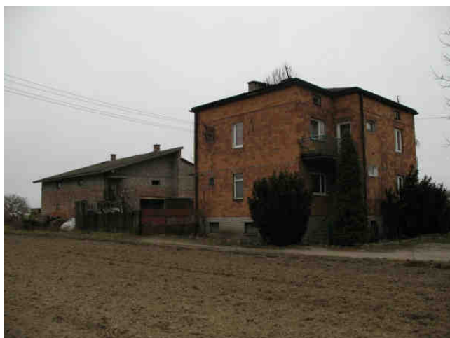
Fot.6.12 Kolizja z zabudową mieszkaniową i gospodarczą – obiekt przy ul. Panoramy 60 (WI, WII)
