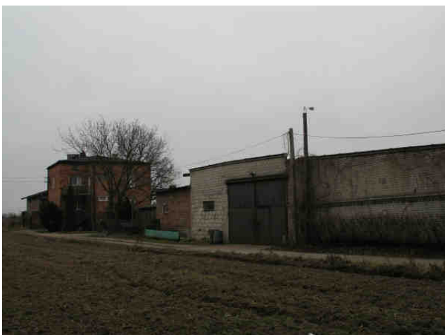
Fot.6.11 Kolizja z zabudową mieszkaniową i gospodarczą – obiekt przy ul. Panoramy 60 (WI, WII)
