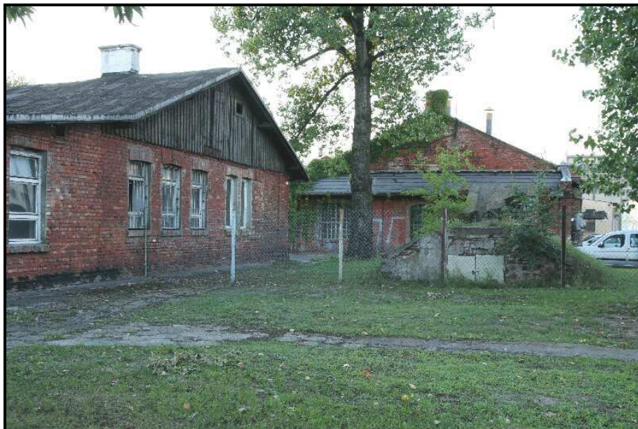
Fot. 17 Hale dawnej Fabryki Aparatów Elektrycznych K. Szpotański i S-ka Widok od strony południowej
