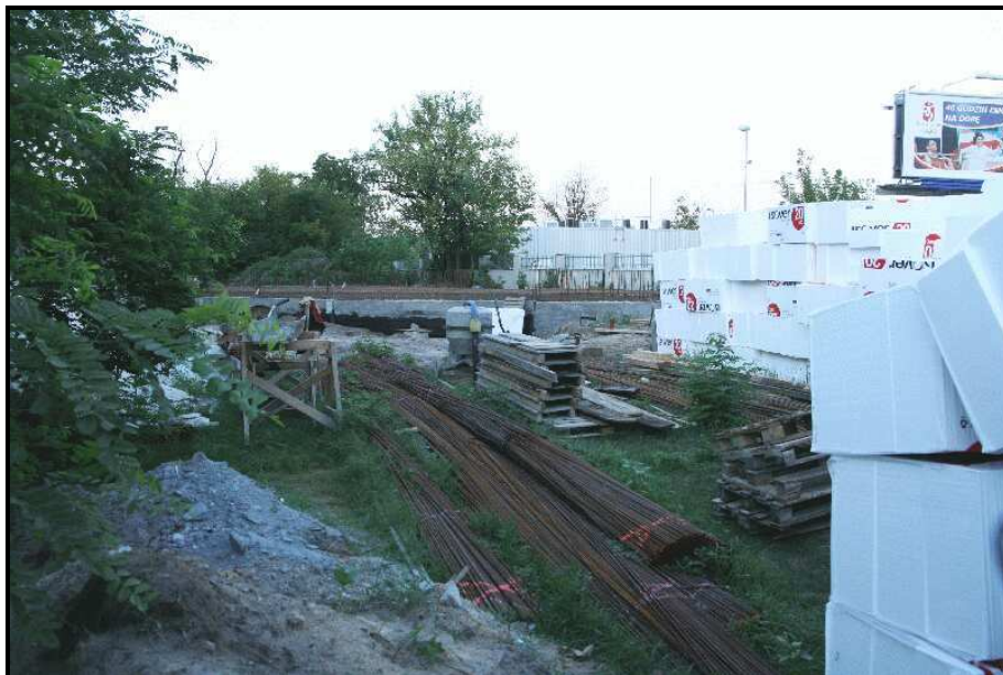
Fot.13 Obiekt w budowie, kolidujący z zachodnim wjazdem do tunelu
