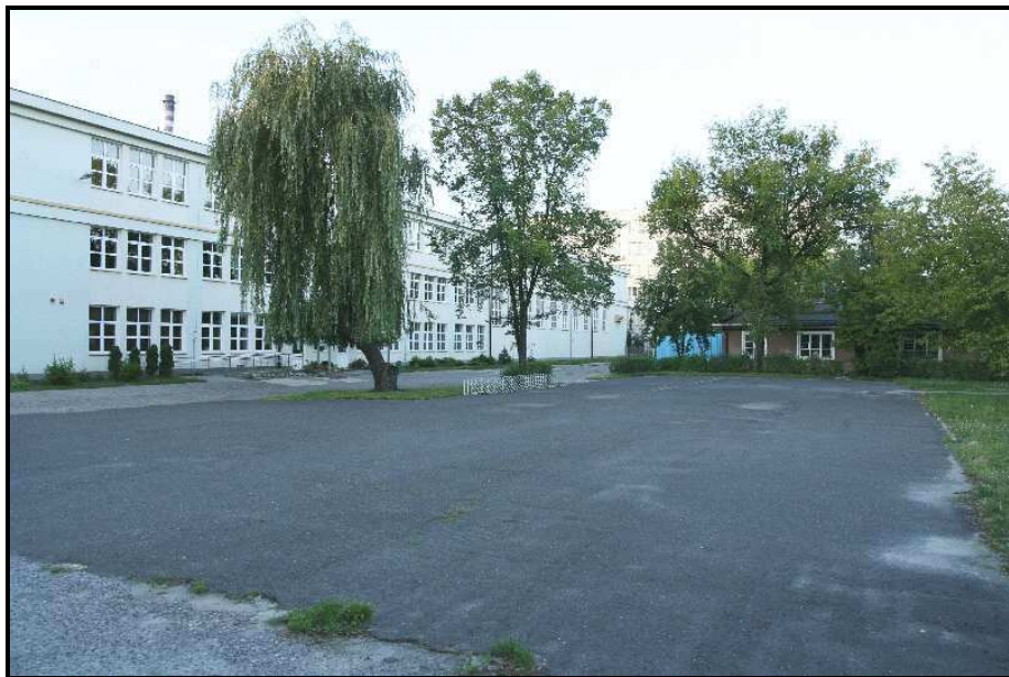
Fot. 6 Budynek gimnazjum
