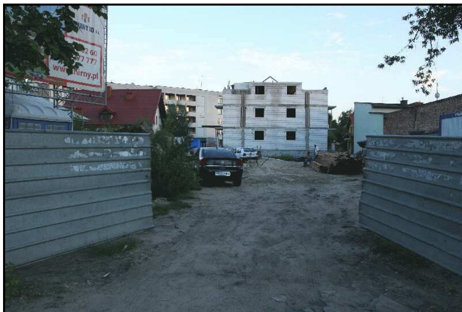
Fot. 7 Budynek wielorodzinny (w budowie) – rejon ul. Dworcowej
