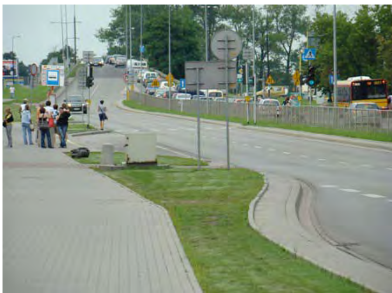
Fot. 11 Koniec przewidywanego do przebudowy odcinka drogi
