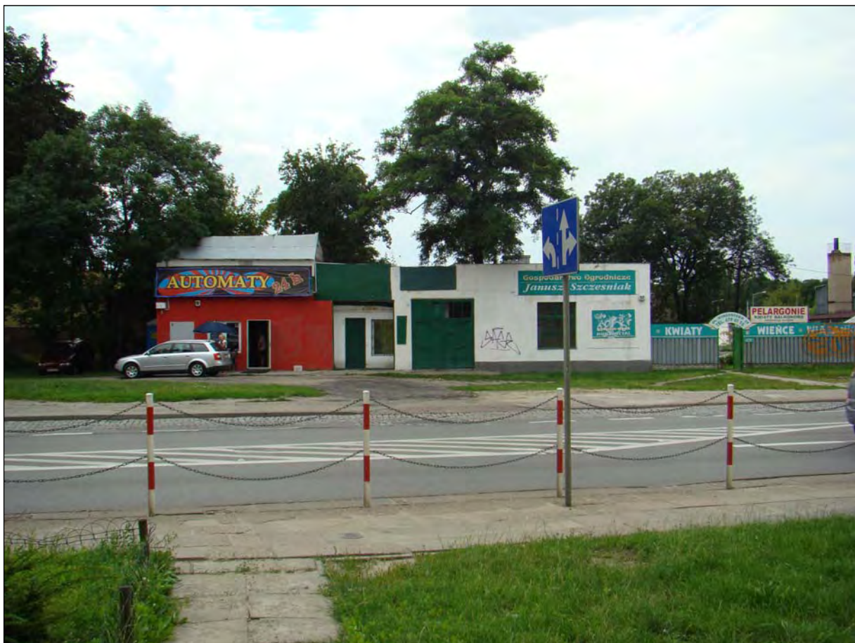
Fot. 11 Budynki usługowe przy ul. Św. Wincentego 55 i 57 przewidziane do rozbiórki
