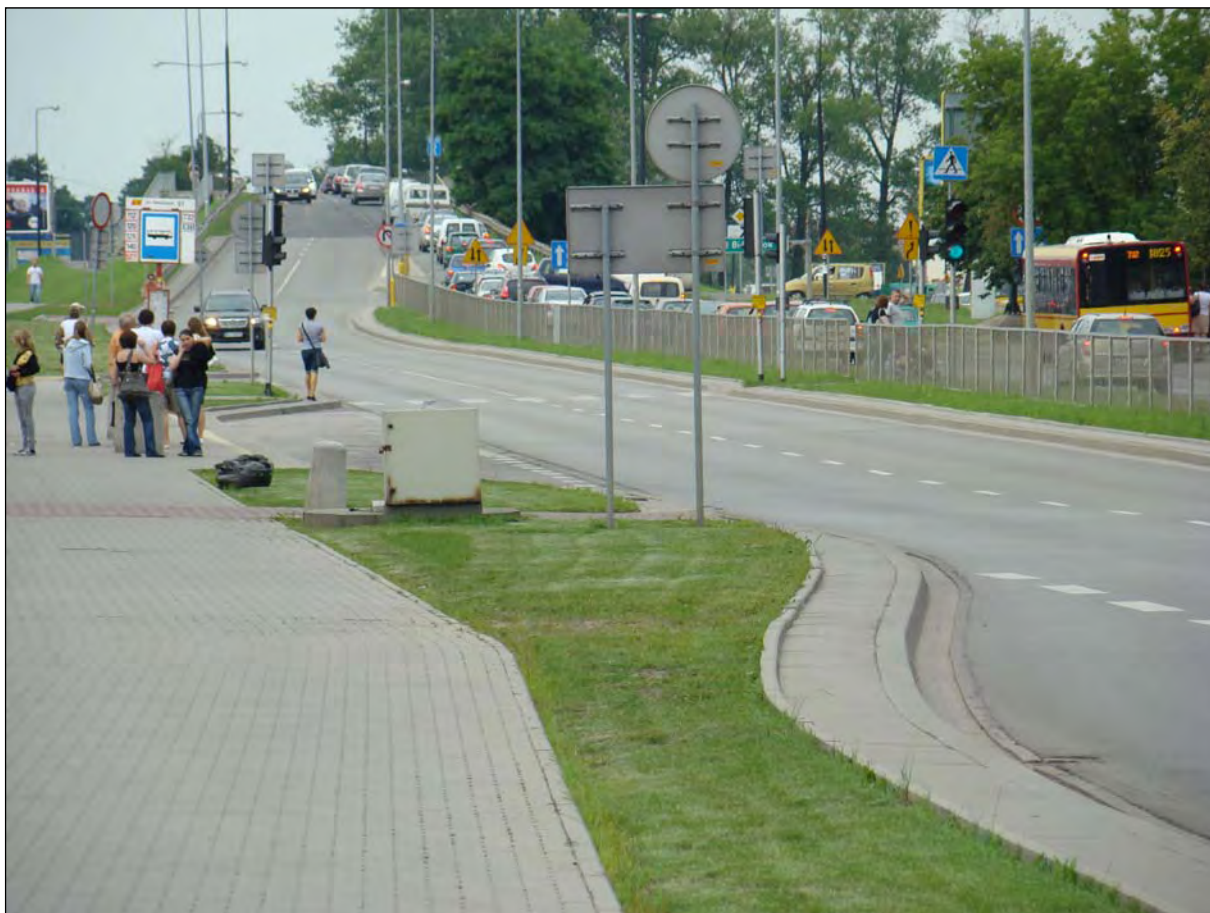
Fot. 37 Koniec przewidywanego do przebudowy odcinka drogi – planowane dowiązanie do węzła ul. Głębockiej z Trasą Toruńską (ronda) realizowanego przez Transprojekt-Warszawa Sp. z o.o.
