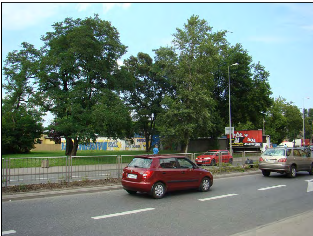
Fot. 4 Budynki usługowe przy ul. Św. Wincentego 19 przewidziane do wyburzenia
