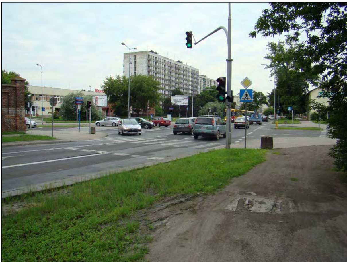
Fot. 21 Skrzyżowanie ul. Św. Wincentego, ul. Budowlanej i ul. Gilarskiej – miejsce proponowanego wiaduktu
