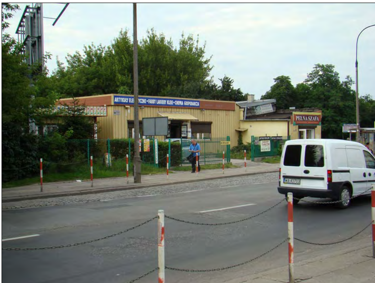
Fot. 6 Budynki usługowe przy ul. Św. Wincentego 25 i 25A przewidziane do wyburzenia
