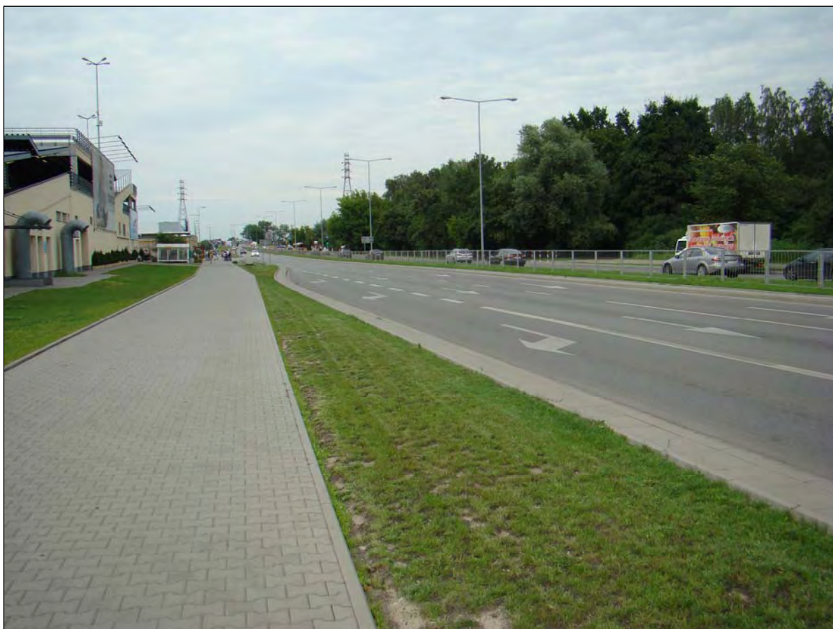
Fot. 36 Widok na ul. Głębocką od wjazdu do CH Targówek w kierunku Trasy Toruńskiej
