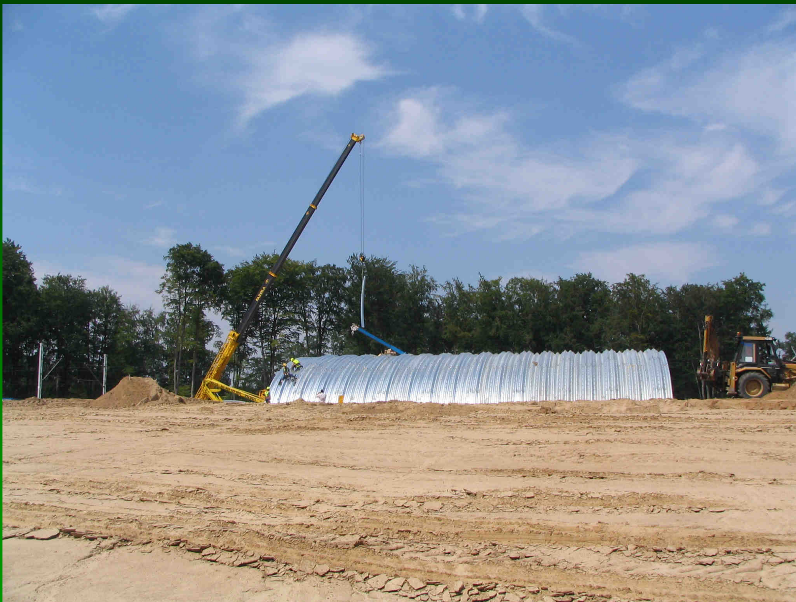
Linia kolejowa E20 w km 466+778 – budowa przejścia dla zwierząt (fot. K. Czechowski)
