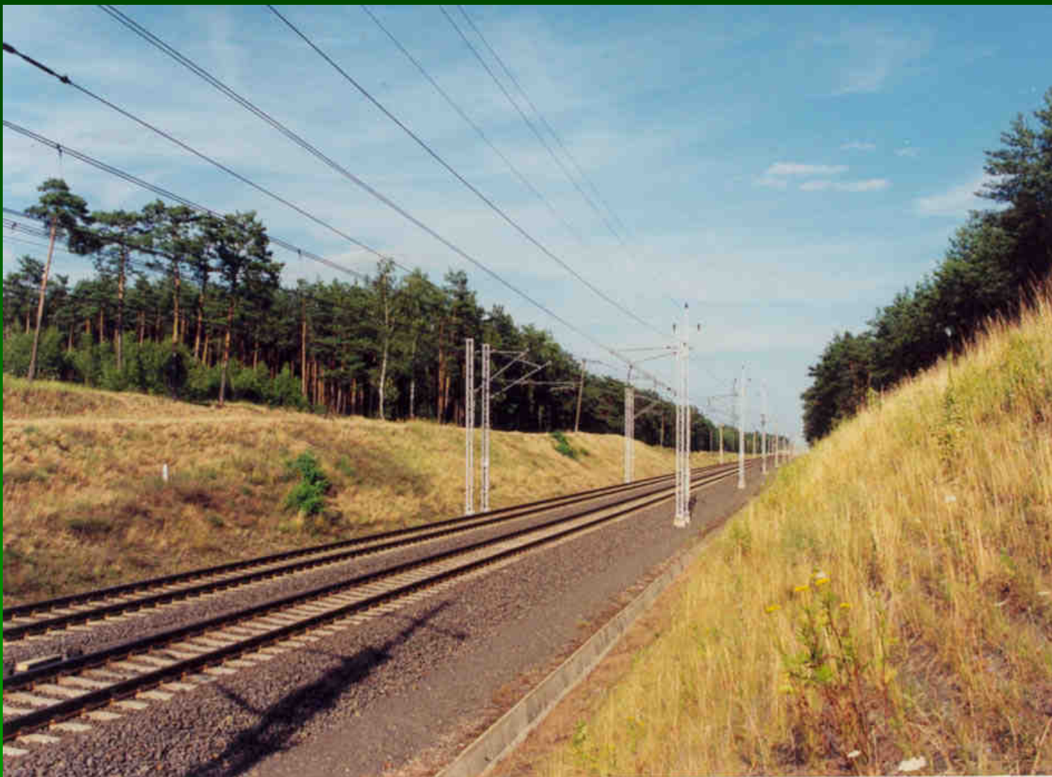
Linia kolejowa E20 w km 466+778 (fot. R. Kurek)
