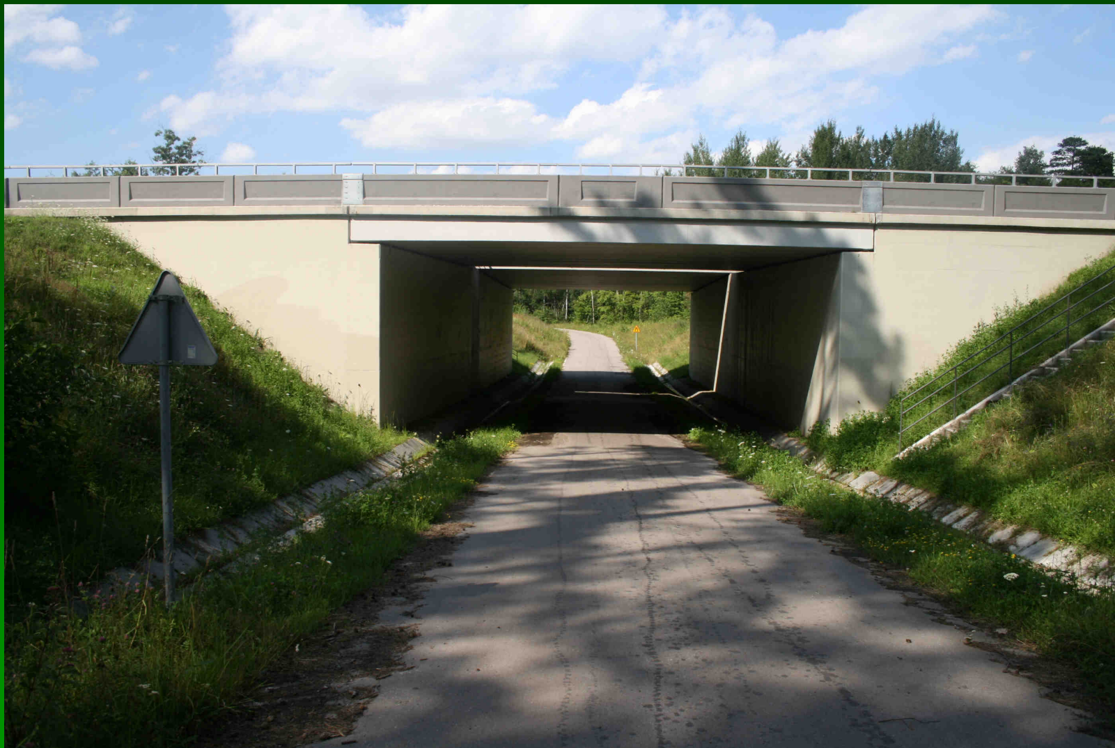
Wiadukt dla drogi gospodarczej, autostrada A4, km 289+000 (fot. R. Kurek)
