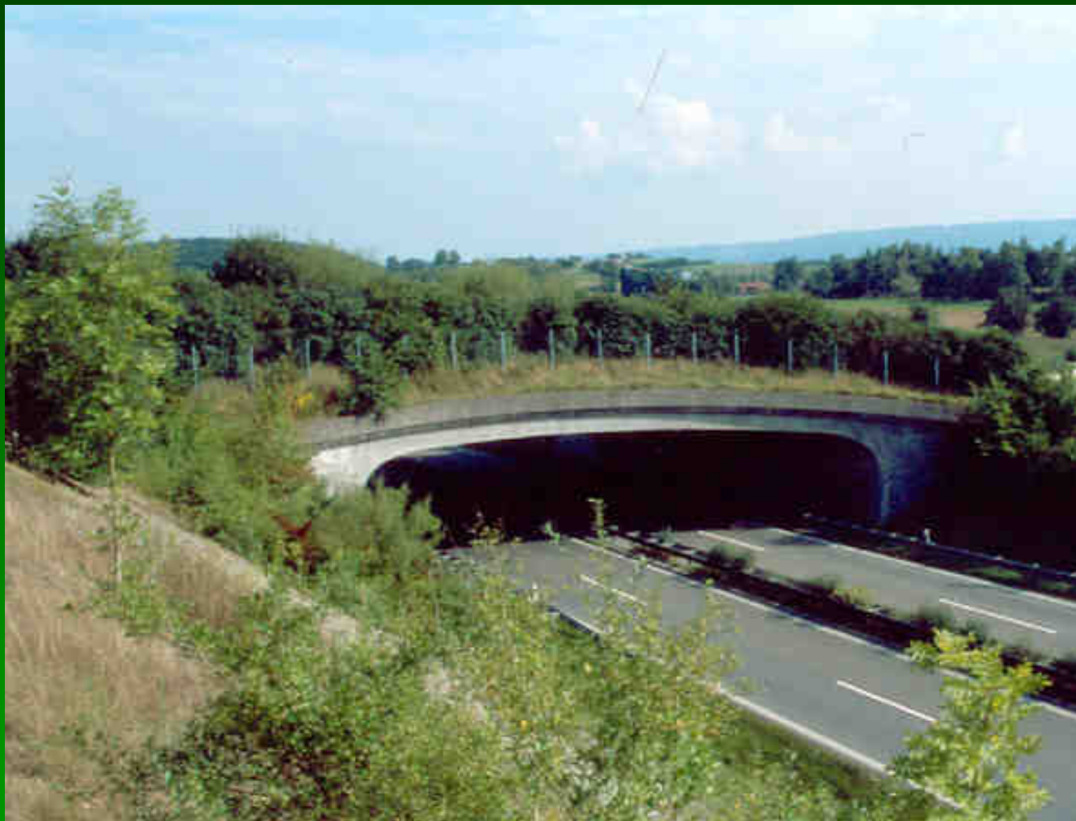
Przejście górne dla dużych zwierząt przy drodze B33 w Niemczech (fot. R. Kurek)
