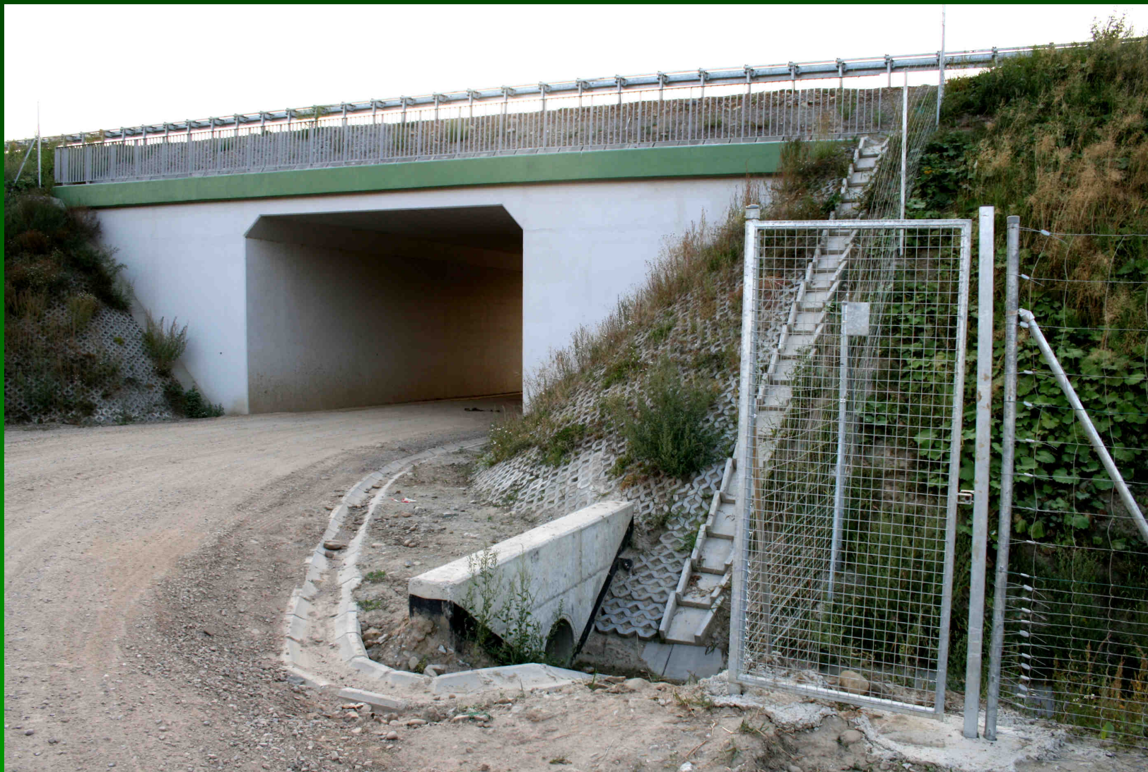
Wiadukt (nad drogą gospodarczą) w ciągu drogi S-69 w km 26+350 (fot. R. Kurek)
