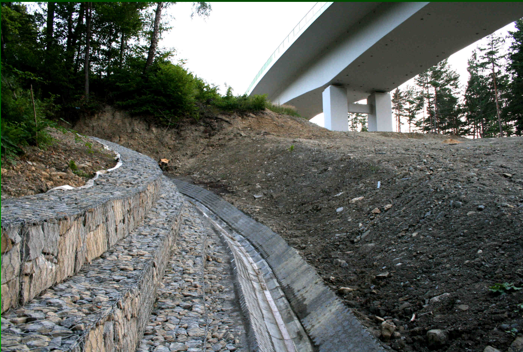
Estakada w ciągu drogi S-69 w km 37+900 (fot. R. Kurek)
