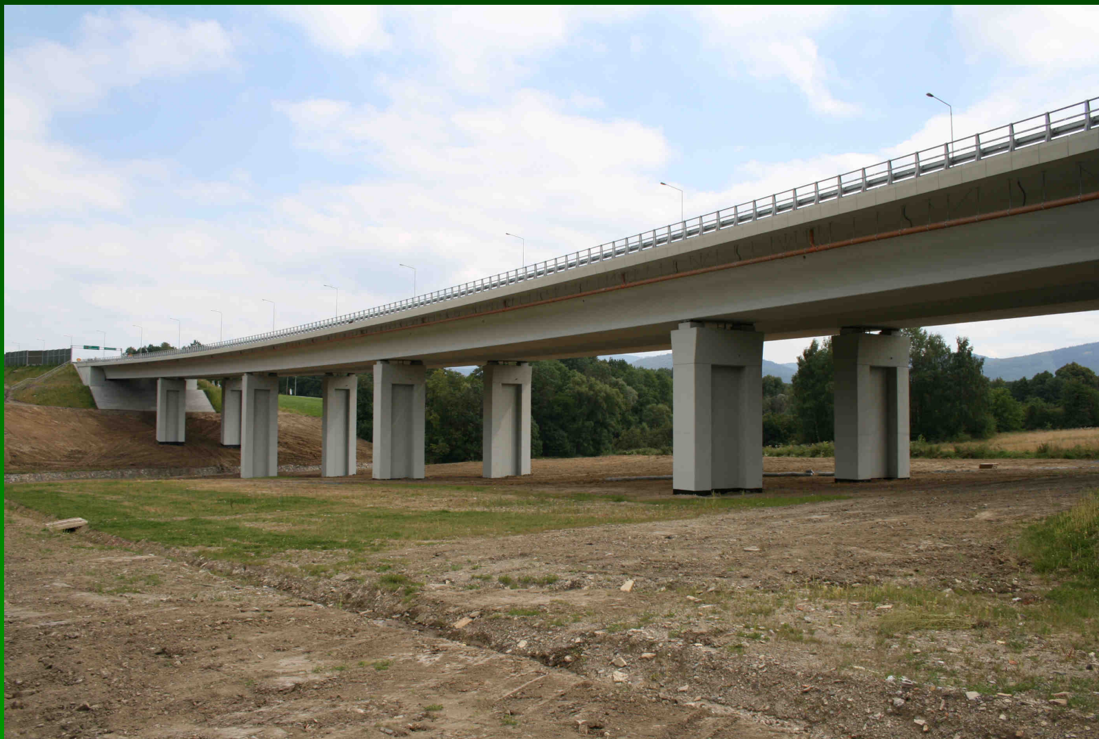
Estakada w ciągu drogi S-1 (Potok Łański) w km 613+100 (fot. R. Kurek)
