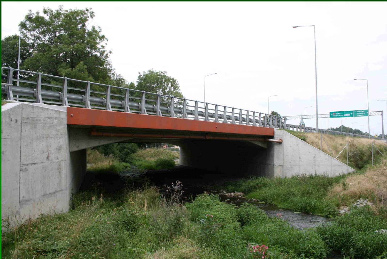
Most nad Potokiem Jasieniczanka, droga S-1, km 610+500 (fot. R. Kurek)
