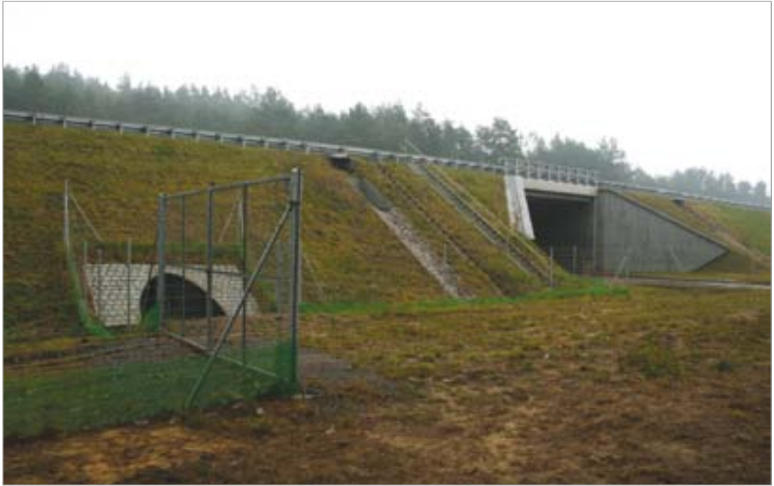
Fot. 5. Przejście dla małych zwierząt (przepust) zlokalizowane w bezpośrednim sąsiedztwie przejścia dolnego (zespolonego) dla średnich zwierząt – autostrada A1.
