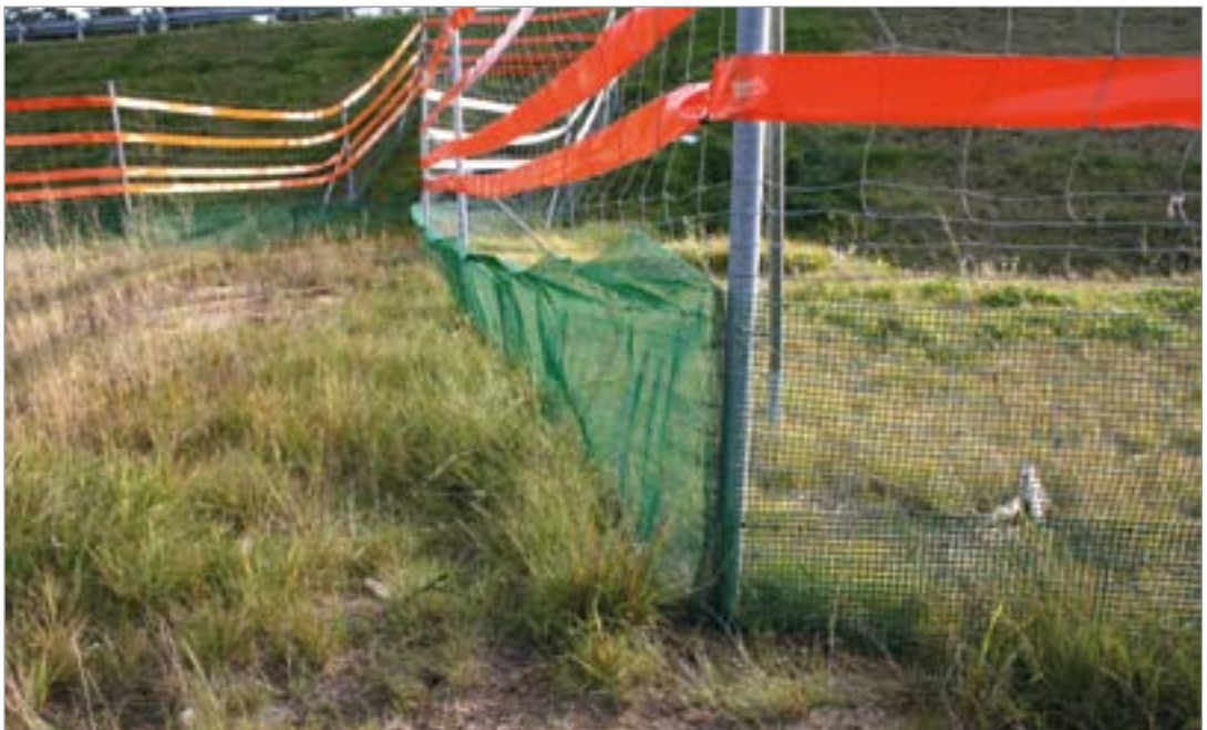
Fot. 104. Ogrodzenie wykonane za siatki polimerowej – materiał niezalecany ze względu na duże trudności z uzyskaniem szczelności oraz dużą podatność na uszkodzenia.
