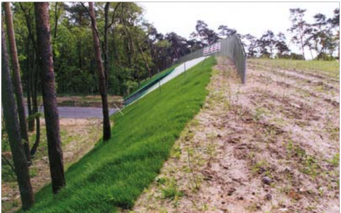
Fot. 84. Zbyt krótki i niewłaściwie zlokalizowany ekran przeciwołśnieniowy na powierzchni przejścia górnego – droga krajowa nr 5.
