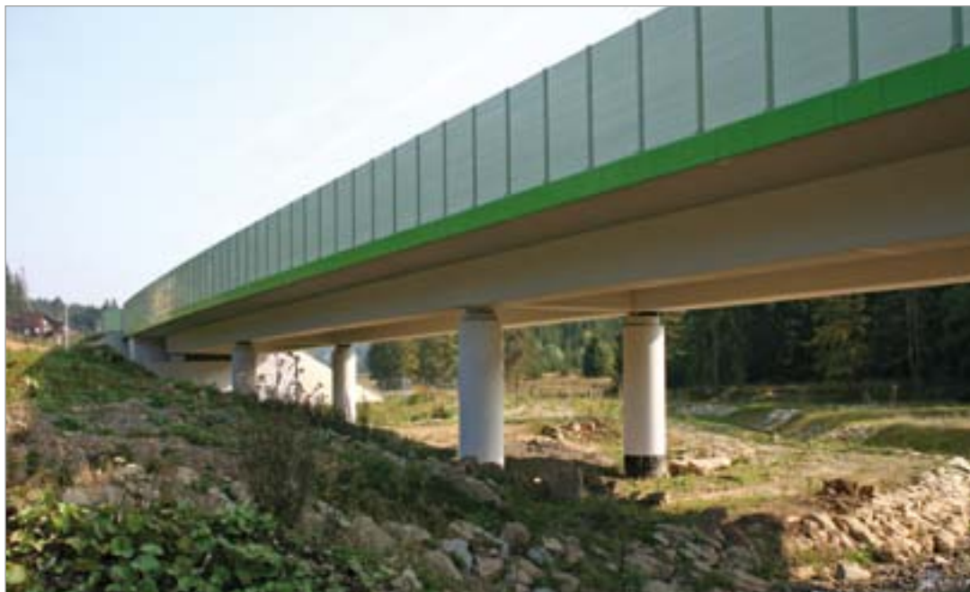
Fot. 141. Ekran panelowy na przejściu dolnym.
