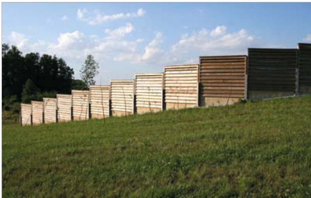
Fot. 150. Nieosłonięte przez roślinność konstrukcje ekranów mogą ograniczać skuteczność przejść górnych.
