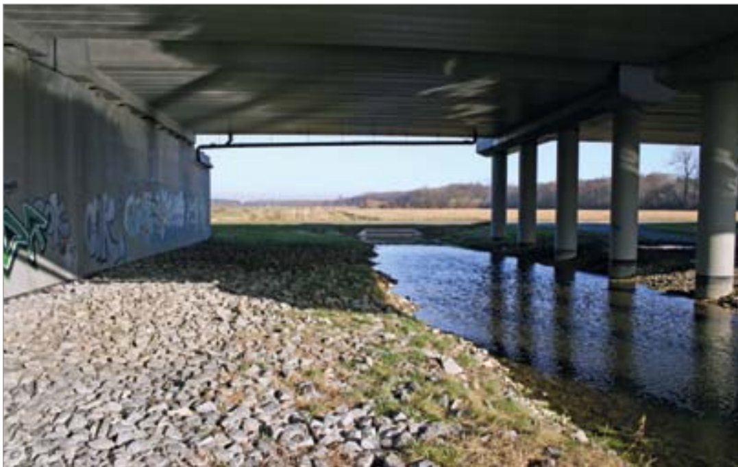
Fot. 118. Suche pólki pokryte niewłaściwym materiałem – grube kruszywo łamane (granit) – utrudnienia dla przemieszczania ssaków kopytnych.
