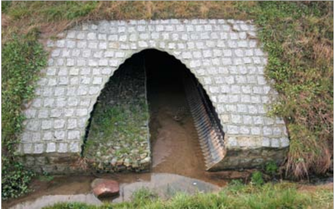
Fot. 97. Półka wykonana z gabionów bez pokrycia gruntem, bez połączenia z otaczającym terenem – autostrada A1.
