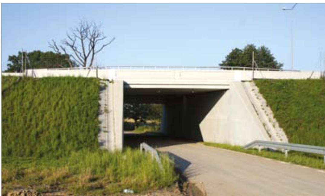
Fot. 22. Przykład przejazdu gospodarczego, który może (po odpowiedniej adaptacji) spełniać funkcje przejścia zespolonego dla nietoperzy i niektórych małych ssaków naziemnych.
