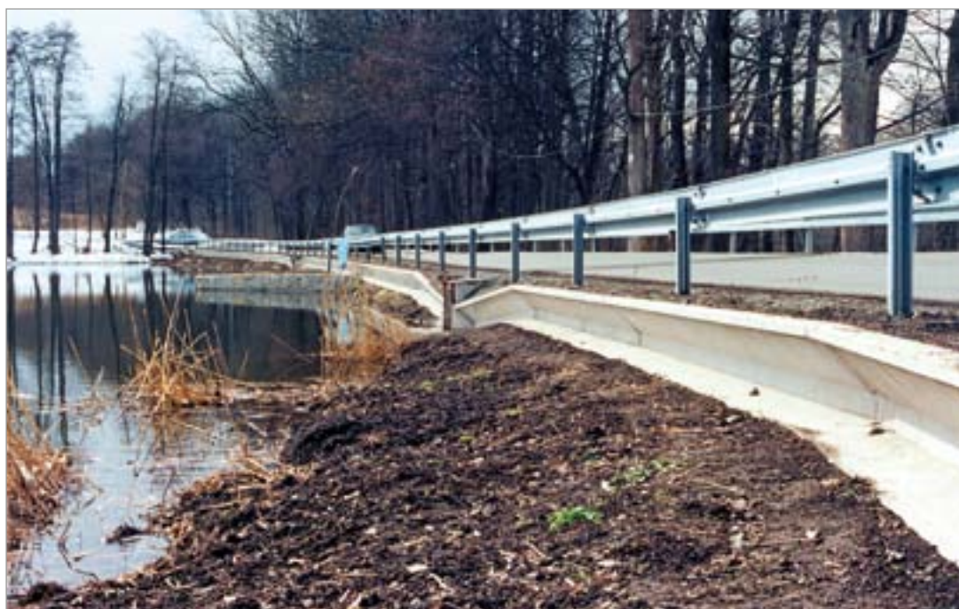
Fot. 125. Ogrodzenie ochronno-naprowadzające z prefabrykatów betonowych.
