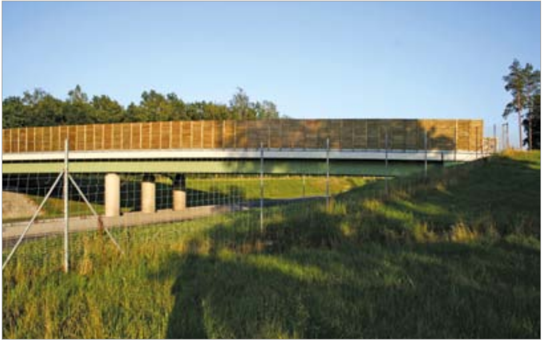
Fot. 37. Wąski wiadukt nad autostradą A4 (ok. 8 m. szer.) z lokalną drogą brukową – tego typu obiekty z ekranami mogą spełniać funkcje przejść dla nietoperzy (po wprowadzeniu nasadzeń naprowadzających).
