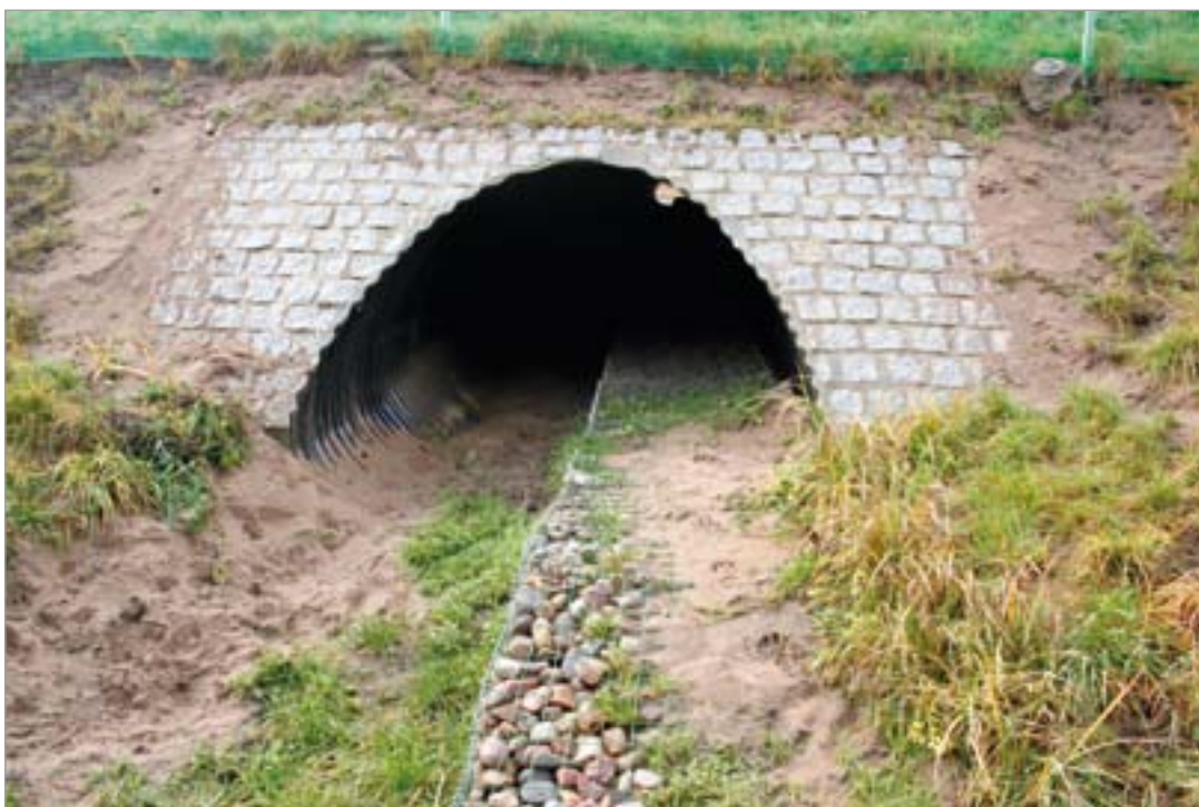
Fot. 119. Pólki gabionowe niedokładnie pokryte gruntem.
