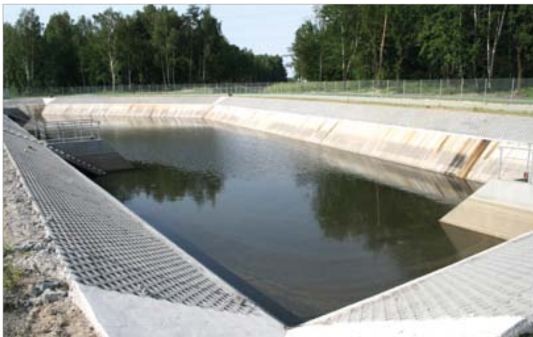
Fot. 152. Przykład zbiornika ekologicznego stanowiącego pułapkę dla płazów.
