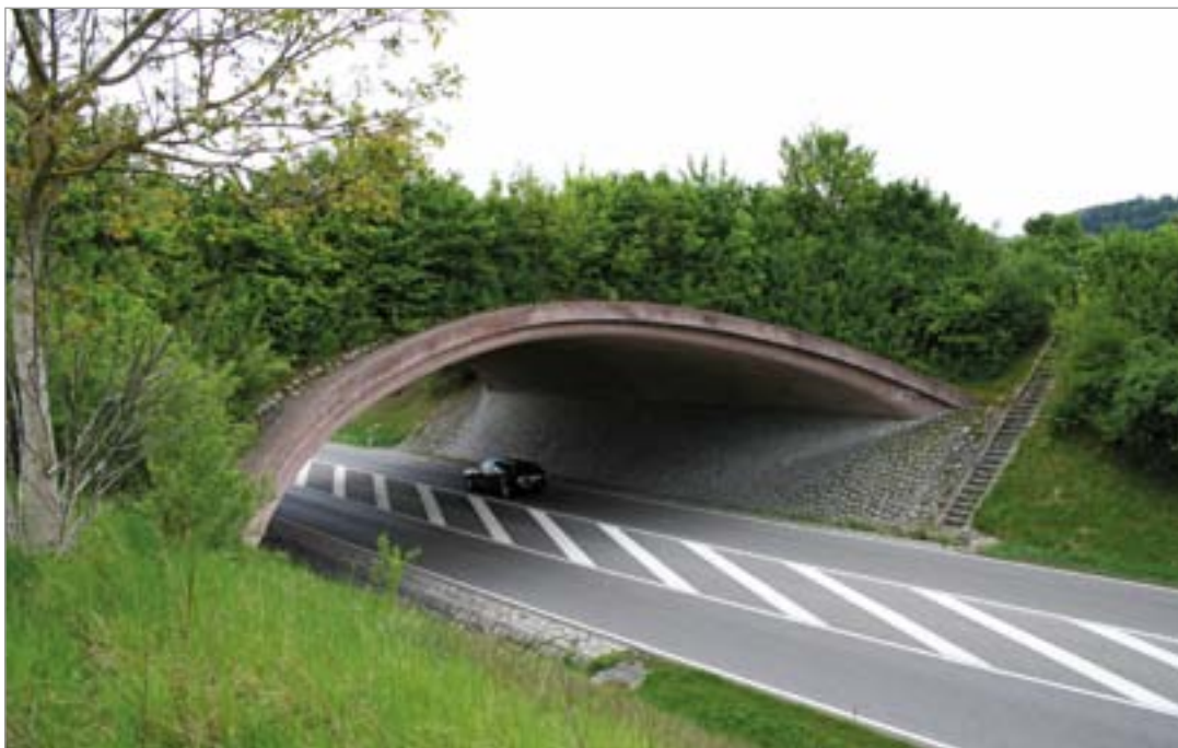
Fot. 26. Przejście górne dla dużych zwierząt przy drodze B31neu (Niemcy) – konstrukcja żelbetowa, łukowa.
