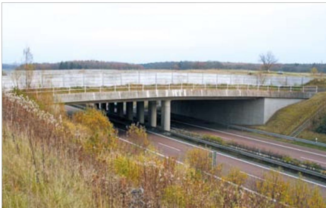
Fot. 17. Przejście górne dla średnich zwierząt zespolone z drogą gospodarczą – autostrada A20 (Niemcy).
