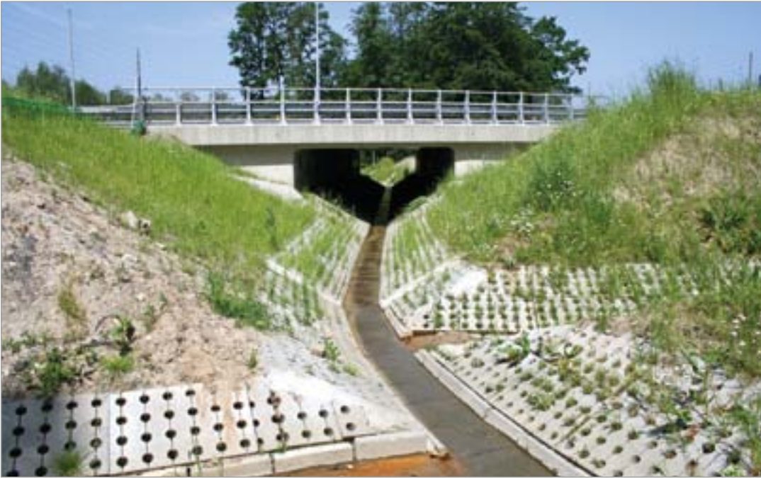
Fot. 95. Zniszczenie naturalnego koryta strumienia przez umocnienia z ażurowych płyt betonowych – autostrada A1.
