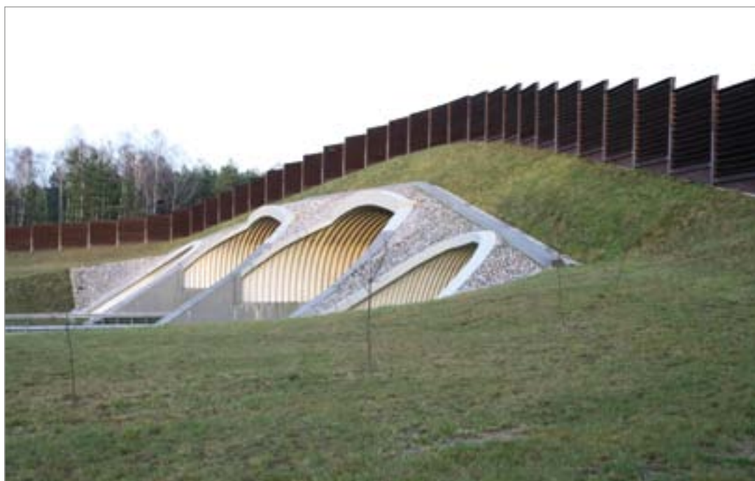
Fot. 70. Przejście górne nad autostradą i równoległymi drogami serwisowymi – autostrada A2.
