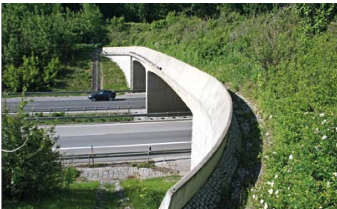
Fot. 140. Ekran betonowy na powierzchni przejścia górnego.
