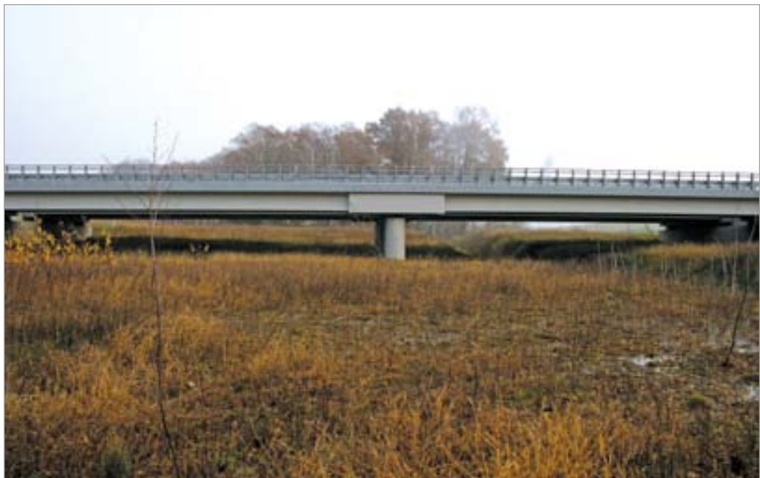
Fot. 19. Przejście dolne dla średnich zwierząt pod poszerzonym mostem dla strumienia – droga ekspresowa S-3.
