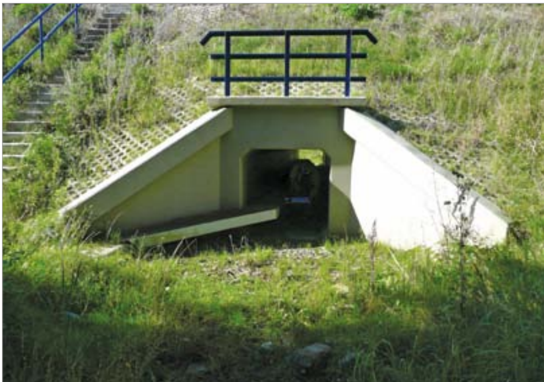
Fot. 162. Przejście dolne zespolone (z półką podwieszaną) dla małych zwierząt przy linii kolejowej Warszawa – Łódź.
