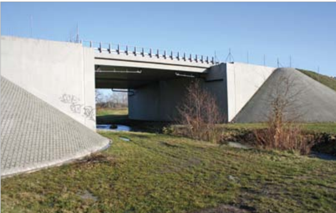
Fot. 77. Przejście posiadające duże, widoczne powierzchnie betonowe – trudne do wkomponowania w otoczenie i odstraszące niektóre zwierzęta – autostrada A2.
