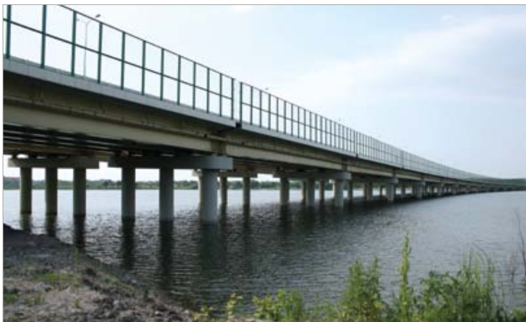
Fot. 142. Ekran transparentny na przejściu dolnym.
