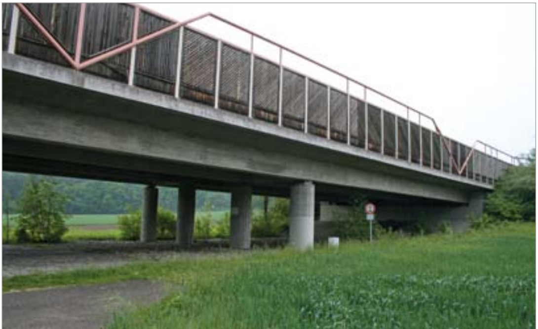
Fot. 138. Drewniany ekran pochłaniający na przejściu dolnym.
