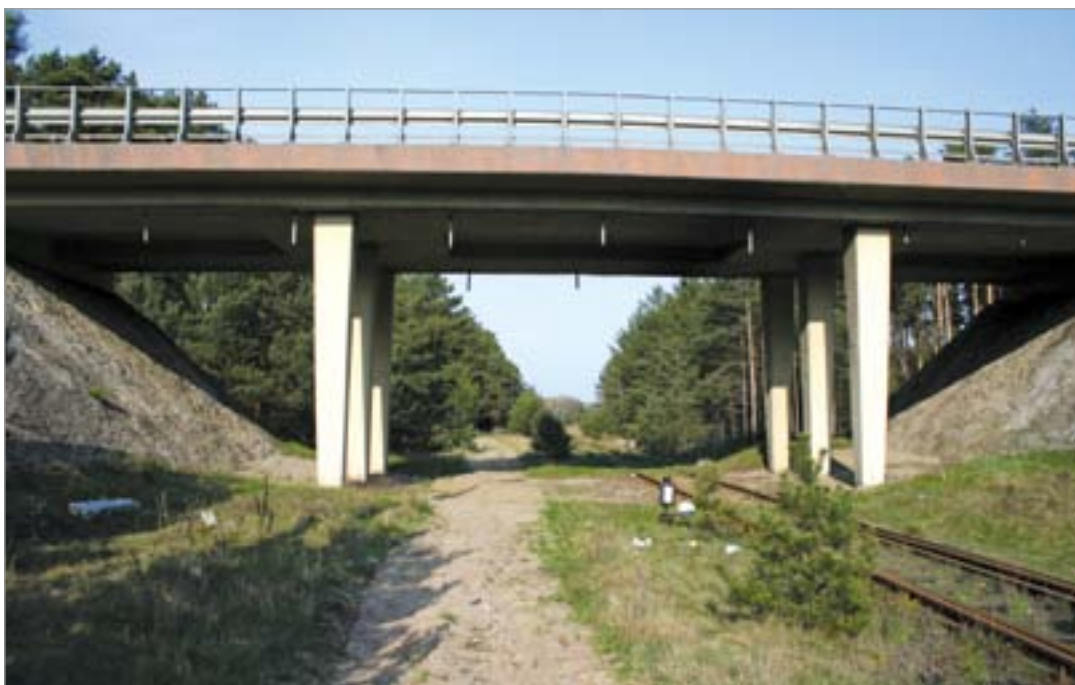
Fot. 20. Przejście dolne dla średnich zwierząt zespolone z linią kolejową – droga krajowa nr 10.
