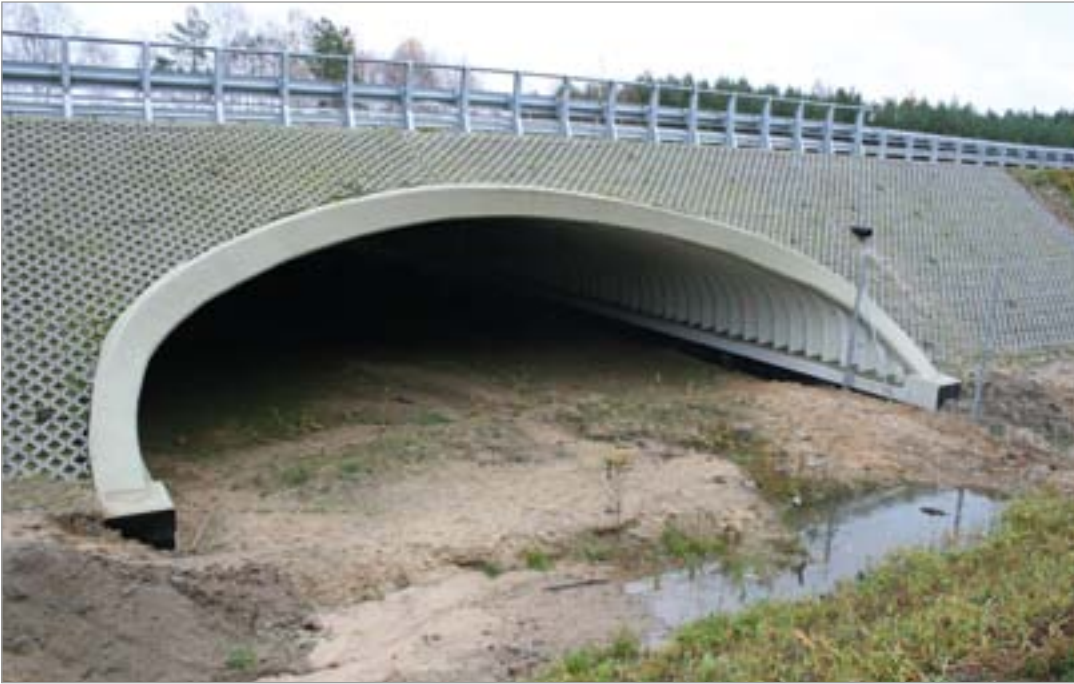
Fot. 40. Przejście dolne dla średnich zwierząt – konstrukcja z blachy falistej na ławach żelbetowych – droga ekspresowa S-3 (w budowie).
