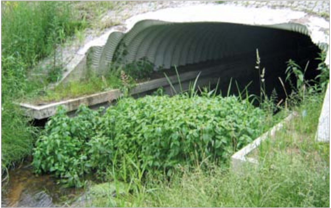
Fot. 57. Półka żelbetowa pokryta gruntem – przepust stalowy o profilu otwartym na ławach żelbetowych.
