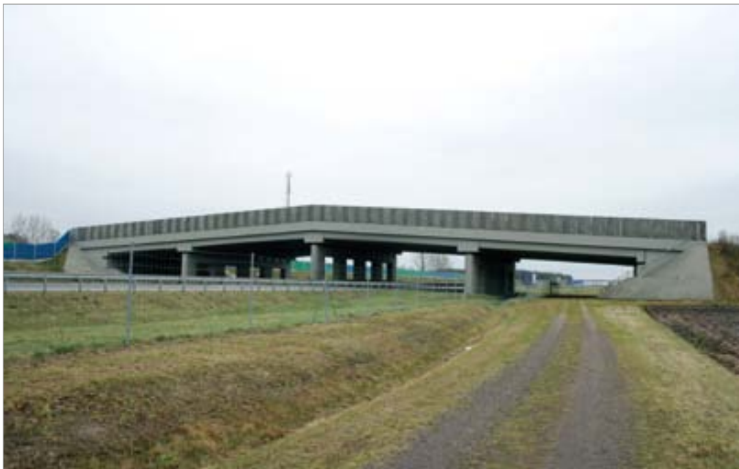
Fot. 112. Nieuzasadnione wydłużenie konstrukcji przejścia górnego ze względu na dodatkowe przęsła dla dróg serwisowych – autostrada A2.
