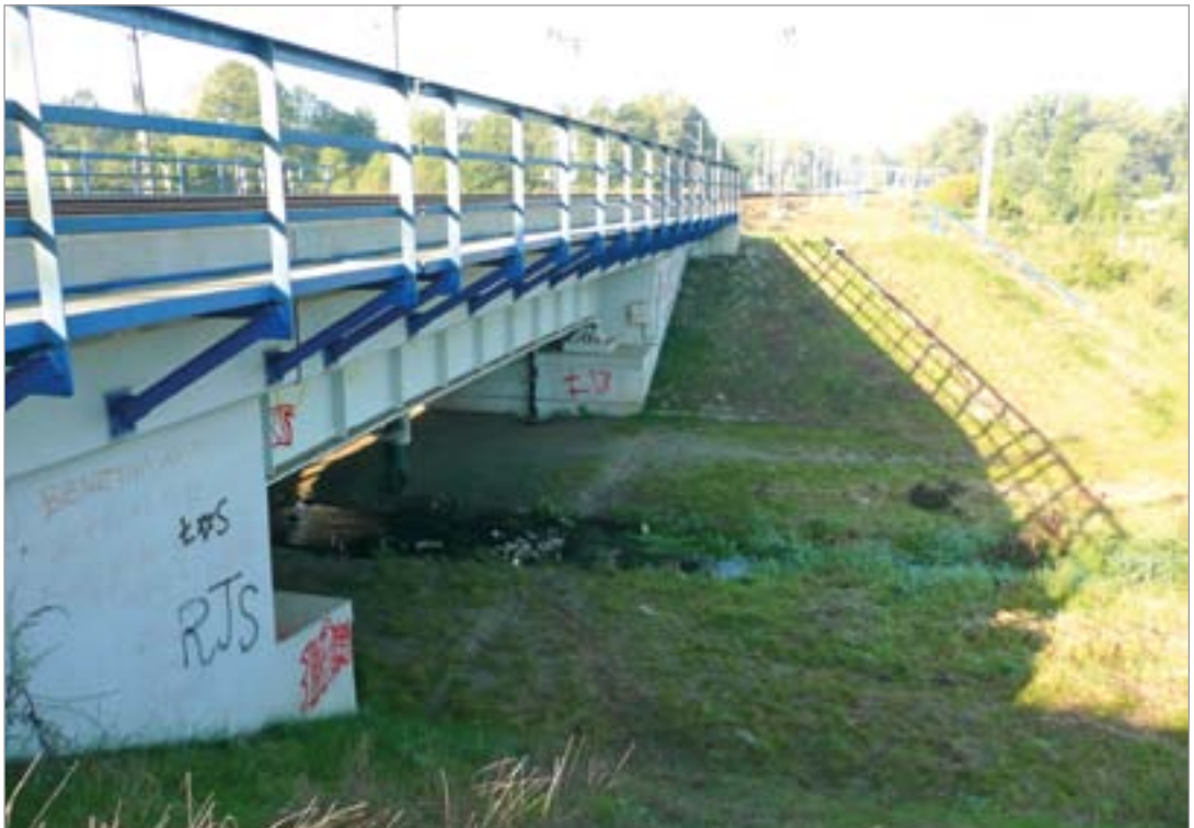
Fot. 164. Przejście dolne dla średnich zwierząt pod poszerzonym mostem przy linii kolejowej Warszawa–Łódź.
