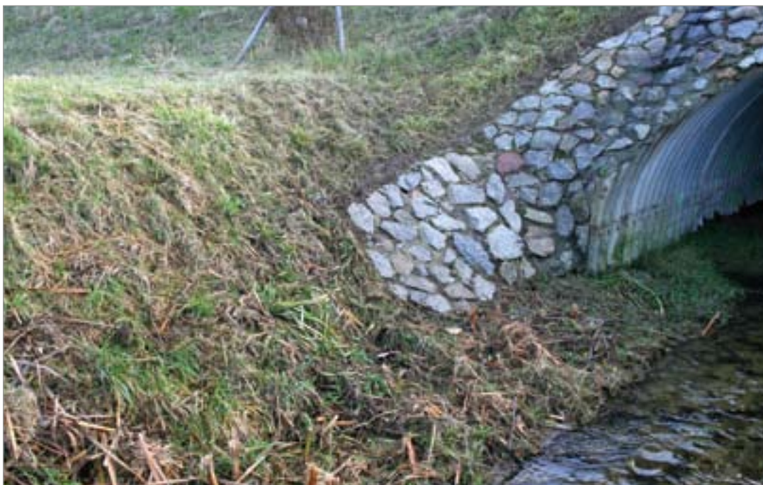
Fot. 55. Półka gruntowa w przepieście z blachy falistej.
