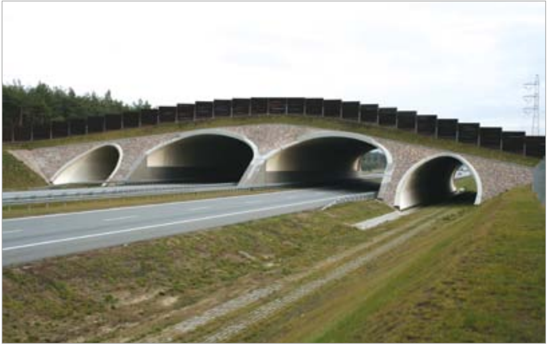
Fot. 28. Przejście górne dla dużych zwierząt przy autostradzie A2 – konstrukcja z blachy falistej.
