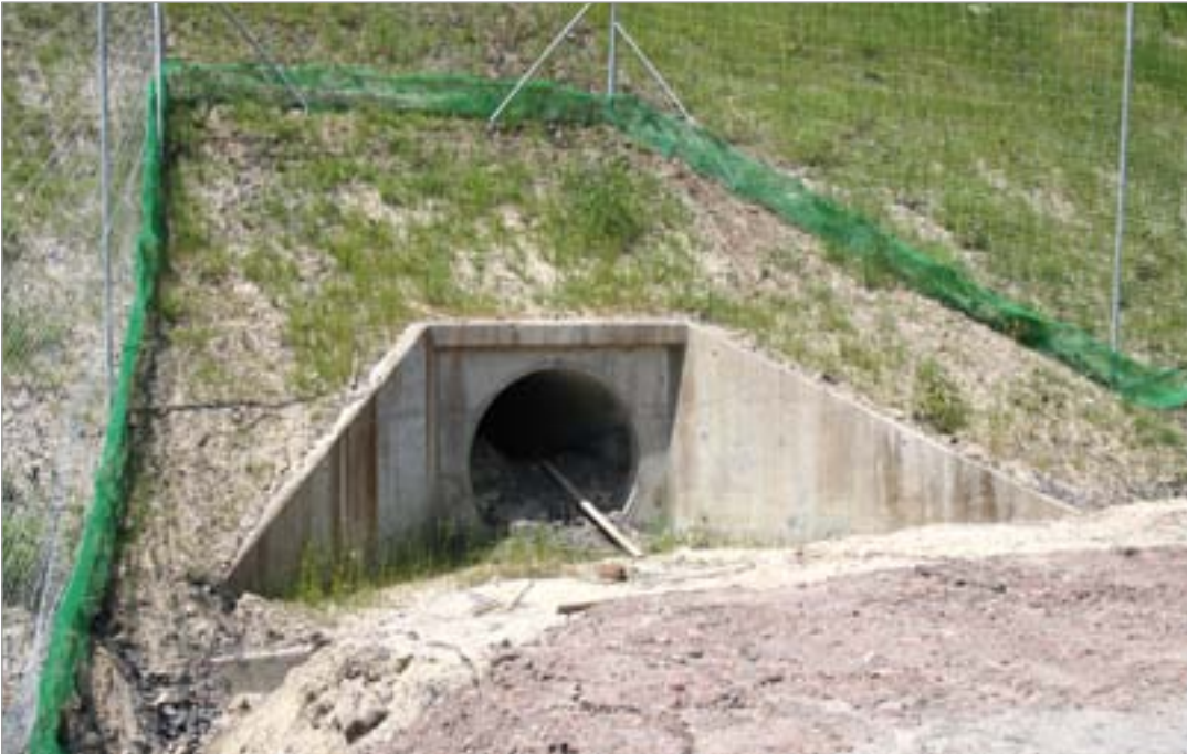
Fot. 82. Niewłaściwy, okrągły przekrój przejścia dla płazów. Zamknięty profil przepustu uniemożliwia utrzymanie odpowiedniej wilgotności podłoża – autostrada A1.
