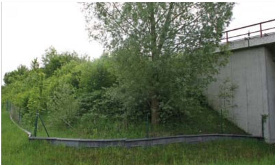
Fot. 63. Skarpy wokół przyczółków przejść dolnych powinny być pokryte gruntem i obsadzone roślinnością osłonowo-izolacyjną.
