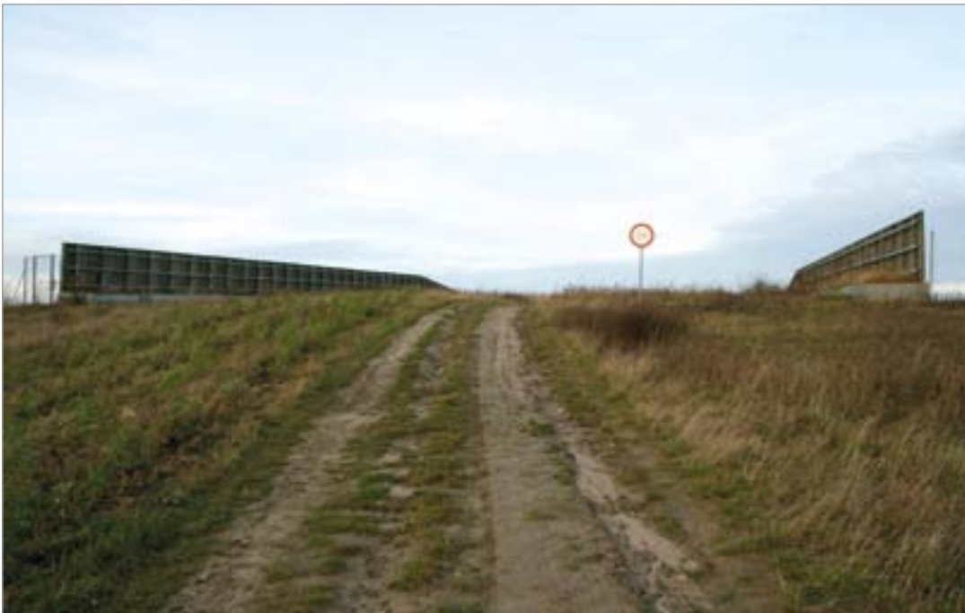
Fot. 89. Przykład nieskutecznych zabezpieczeń przed przejazdami z wykorzystaniem znaków drogowych – autostrada A2.
