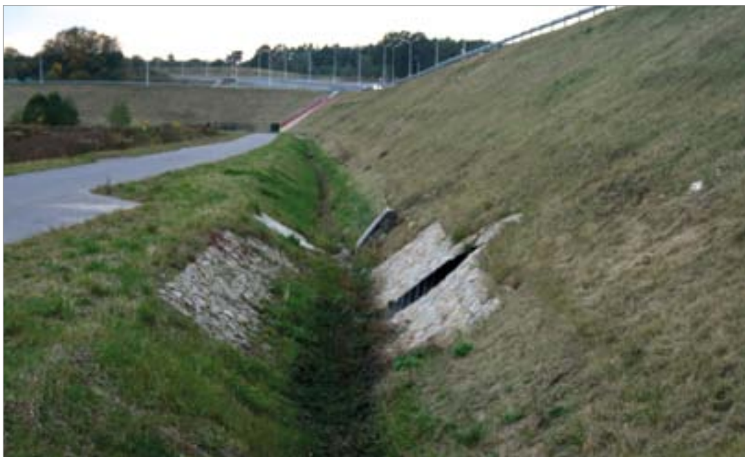
Fot. 106. Rów utrudniający dojście do małego przejścia dolnego.
