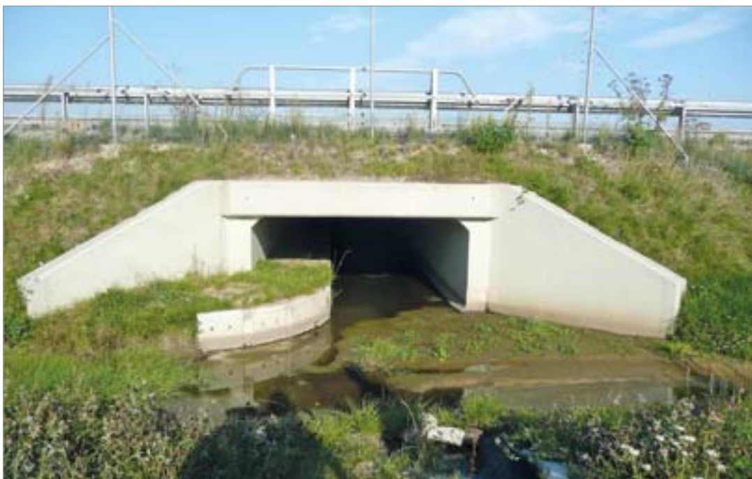
Fot. 56. Półka gruntowa z dodatkową ścianką zewnętrzną w przepieście żelbetowym.
