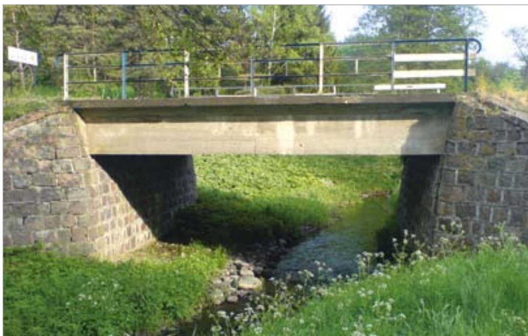
Fot. 54. Półka gruntowa pod małym mostem.
