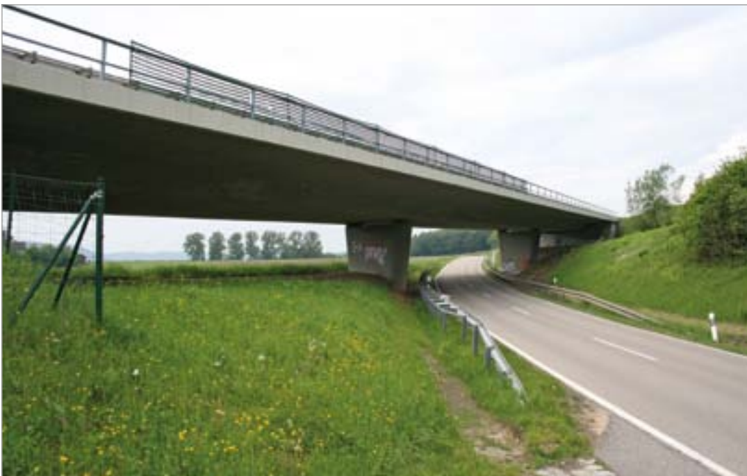
Fot. 92. Projektowanie przejść zespolonych pod wiaduktami dla ruchliwych dróg publicznych jest niewskazane.
