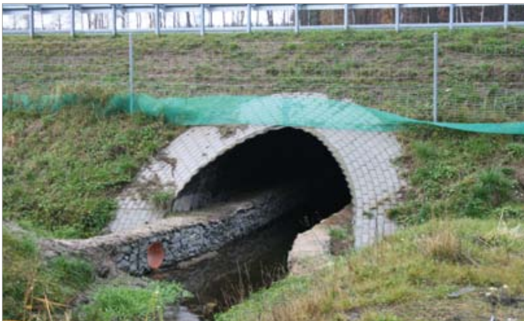
Fot. 105. Brak połączenia ogrodzeń dla małych zwierząt z wylotem przepustu powoduje nieskuteczność ich naprowadzania do przejścia.
