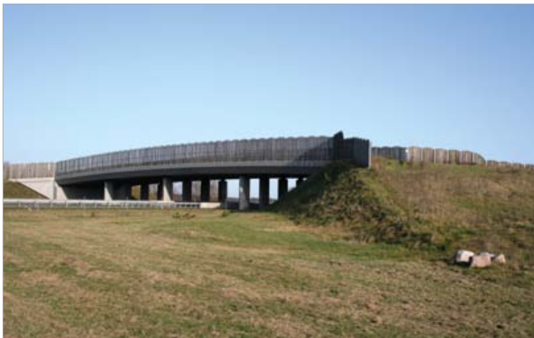
Fot. 74. Przejście o zbyt małym kącie rozwarcia najść oraz konstrukcji bez zmiennej szerokości – autostrada A2.
