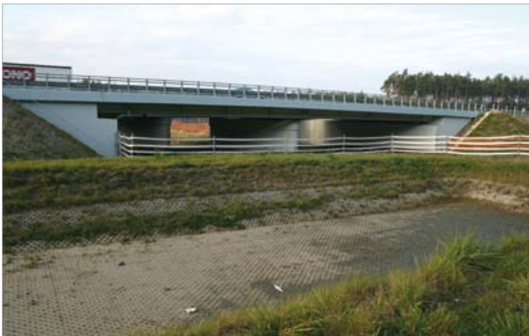
Fot. 101. Zbiornik ekologiczny utrudniający dojście do przejścia dolnego – autostrada A4.
