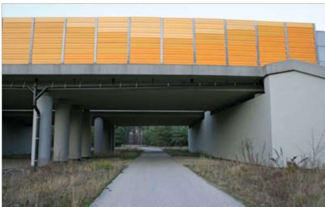
Fot. 151. Przykład ekranu panelowego o nieodpowiedniej (jaskrawej) barwie.
