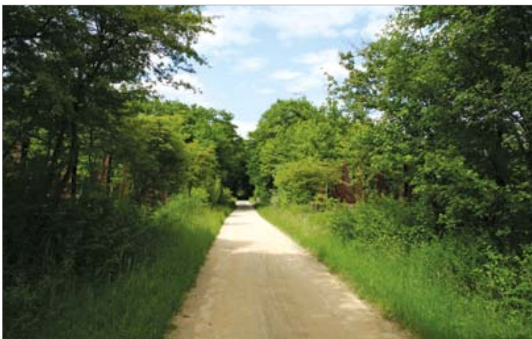
Fot. 36. Droga gruntowa pośrodku przejścia górnego dla średnich zwierząt – autostrada A36 (Francja).
