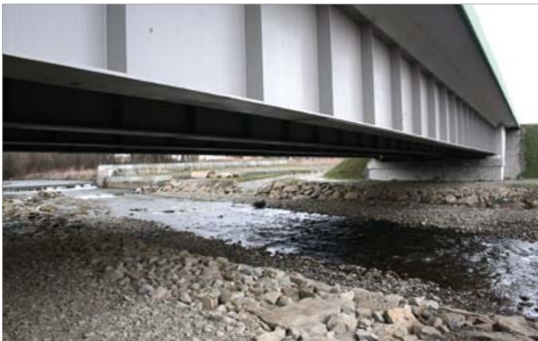
Fot. 158. W warunkach górskich zalecanym sposobem umocnienia koryt jest luźny narzut kamienny.
