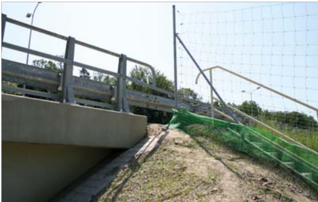
Fot. 134. Nieszczelne połączenie ogrodzeń z przejściem dolnym.
