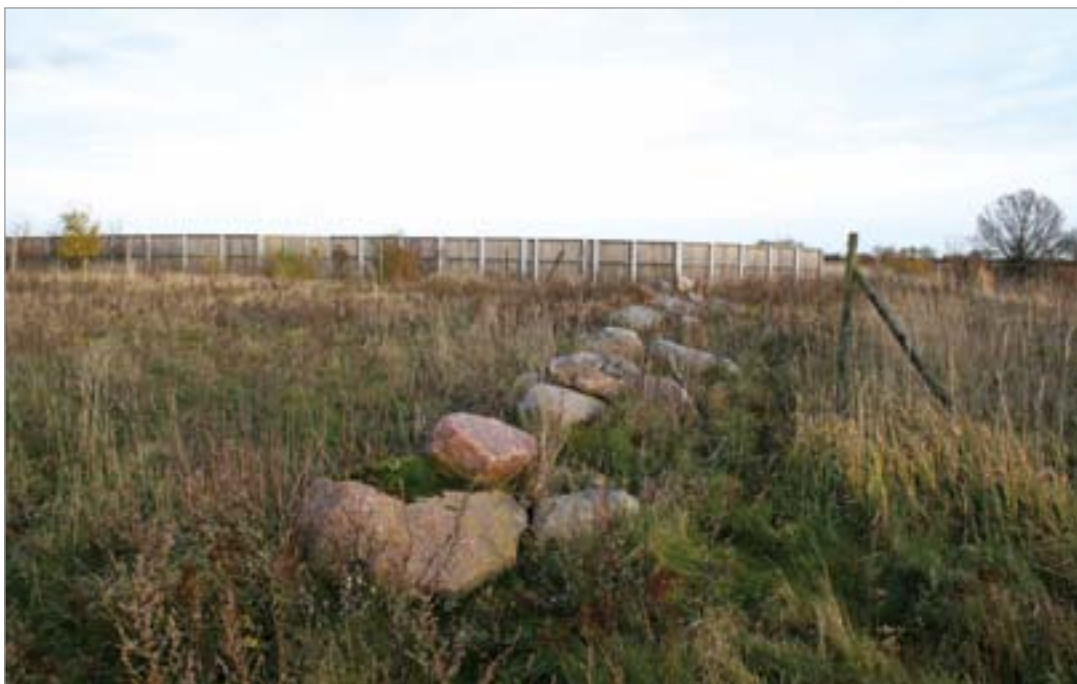
Fot. 32. Zabezpieczenia przed przejazdami w postaci głazów na powierzchni przejścia górnego – autostrada A20 (Niemcy).
