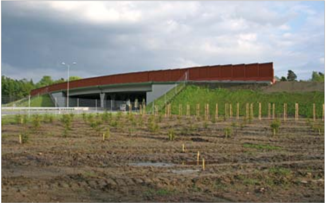
Fot. 146. Niewłaściwy przebieg ogrodzenia i ekranu na powierzchni przejścia górnego powodujący utrudnione naprowadzanie zwierząt.
