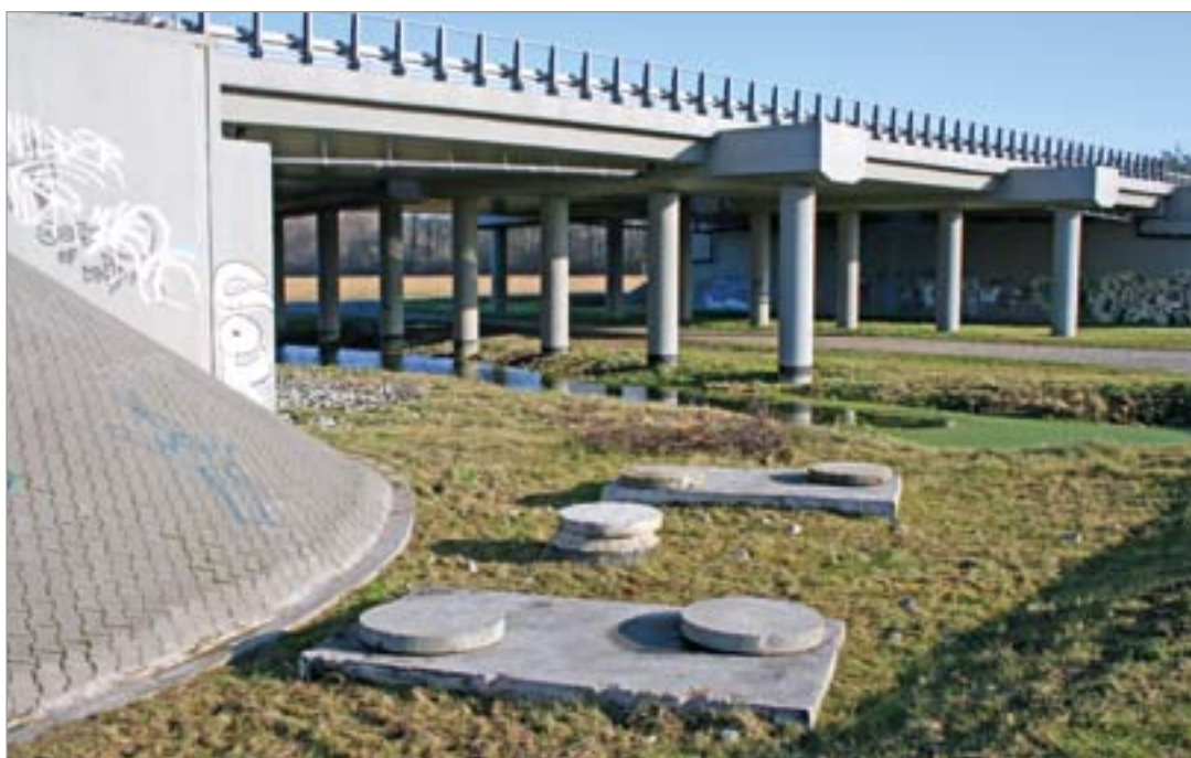
Fot. 117. Obiekty odwodnieniowe pozostające na powierzchni terenu wpływają odstraszaająco na niektóre gatunki zwierząt.
