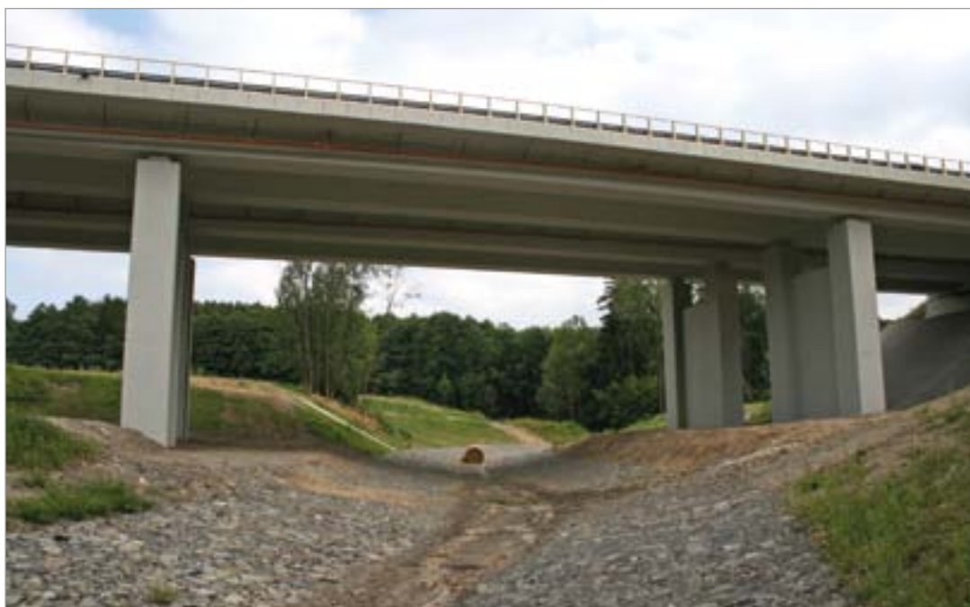
Fot. 94. Zniszczenie naturalnego koryta potoku przez umocnienia z materacy gabionowych – droga ekspresowa S-1.
