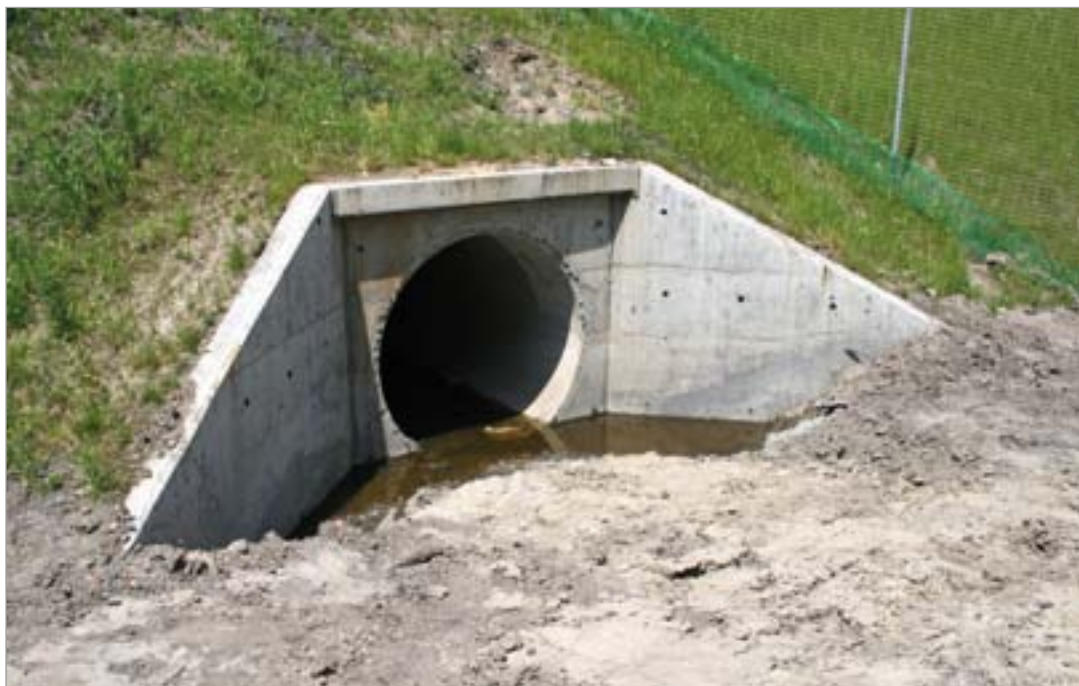
Fot. 114. W przypadku przepustów o profilu zamkniętym ich lokalizacja poniżej poziomu terenu powoduje stagnowanie wody opadowej.
