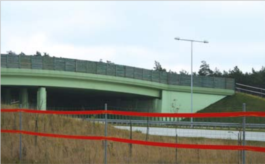
Fot. 109. Niedopuszczalne jest zlokalizowane przejść dla dużych zwierząt przy oświetlonych odcinkach dróg – autostrada A4.
