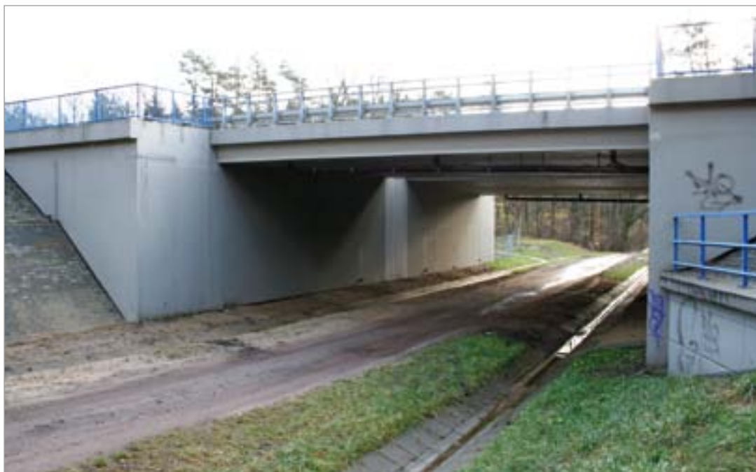
Fot. 93. Otwarte rowy, zwłaszcza umocnione elementami betonowymi, ograniczają efektywną szerokość przejść – autostrada A2.
