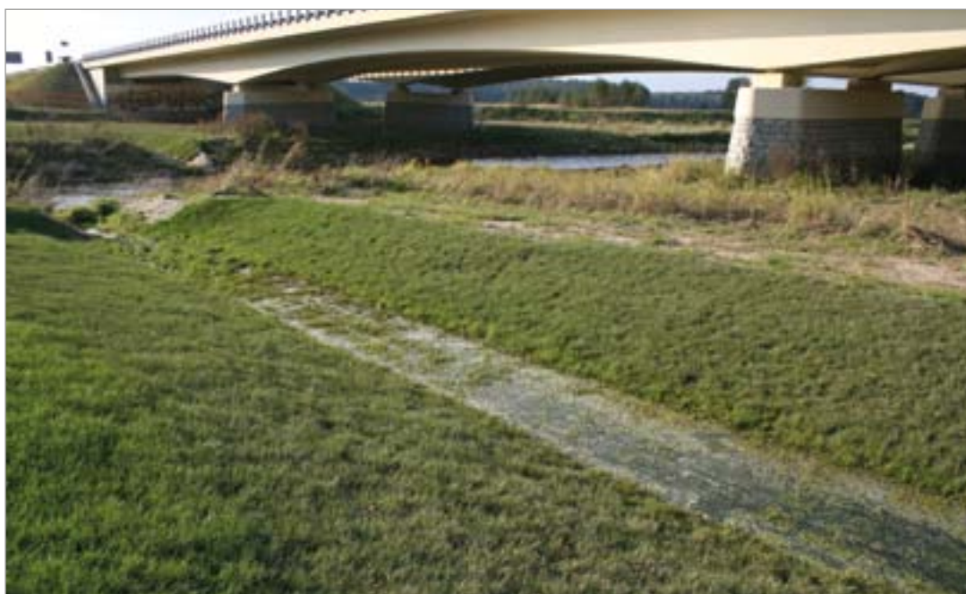
Fot. 65. Przykład rowu o wypłaszczonych skarpach w otoczeniu mostu krajobrazowego – autostrada A4.
