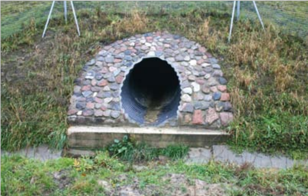
Fot. 115. Powierzchnia przejścia dla małych zwierząt bez płynnego połączenia z otaczającym terenem – próg stanowiący przeszkodę dla wielu gatunków.
