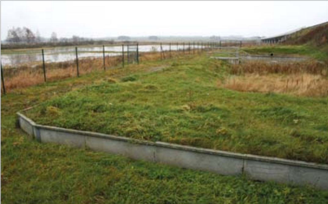
Fot. 66. Obiekty odwodnieniowe zabezpieczone ogrodzeniami (z polimerobetonu) przed wchodzeniem pól – autostrada A20 (Niemcy).
