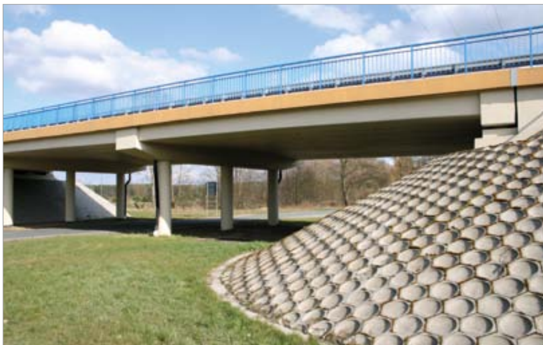
Fot. 100. Niekorzystne rozwiązanie – umacnianie skarp w strefach dostępnych dla zwierząt przy pomocy materiałów betonowych – droga krajowa nr 11.
