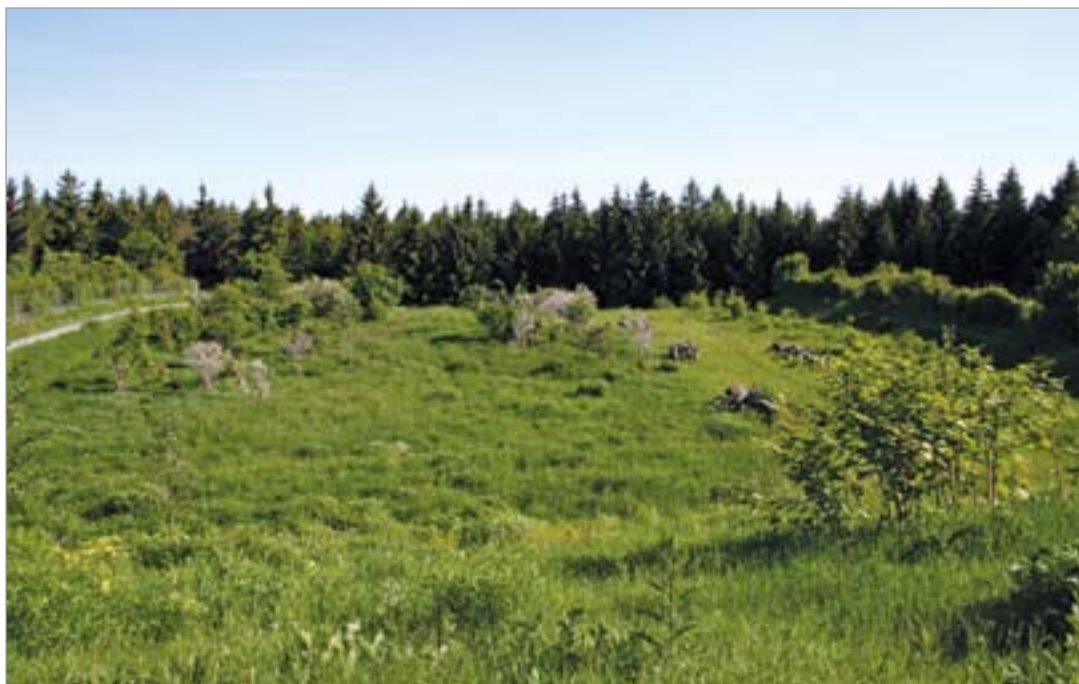
Fot. 29. Powierzchnia przejścia górnego dla dużych zwierząt przy autostradzie A4 (Niemcy).
