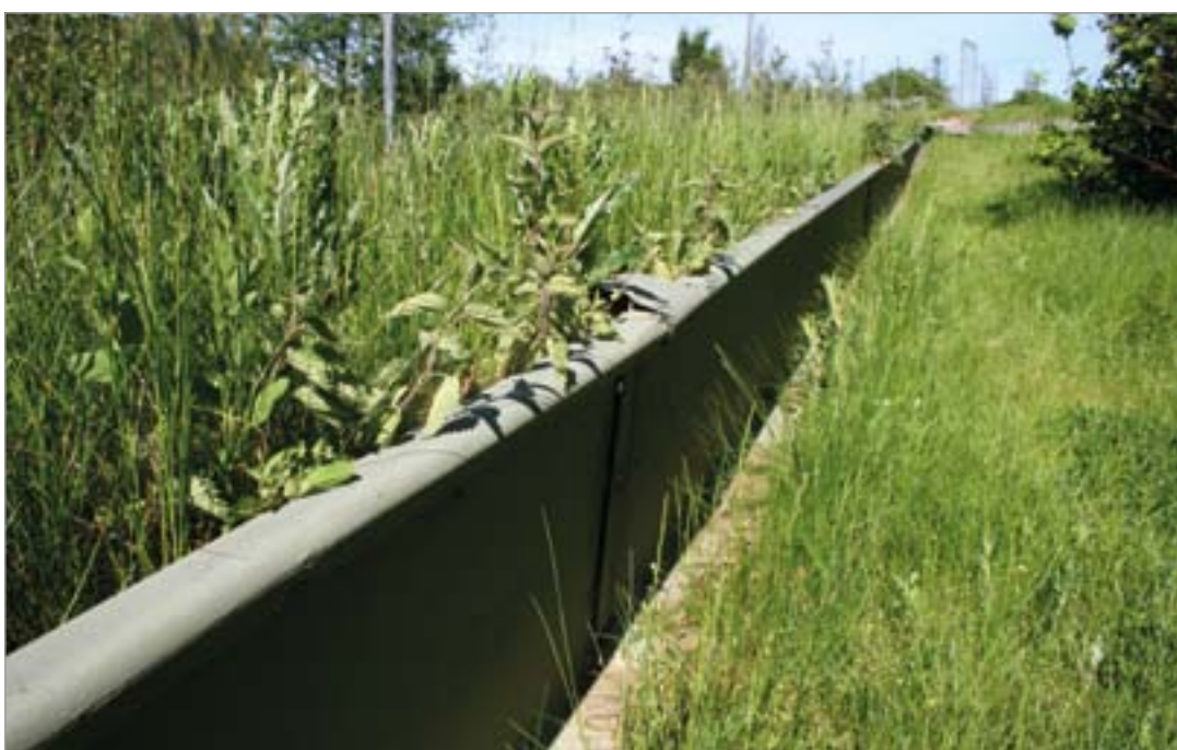
Fot. 127. Ogrodzenie ochronno-naprowadzające z płyt stalowych malowanych.
