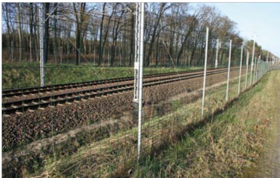
Fot. 159. Ogrodzenie ochronne dla dużych zwierząt wzdłuż linii kolejowej E20 w Puszczy Rzepińskiej.
