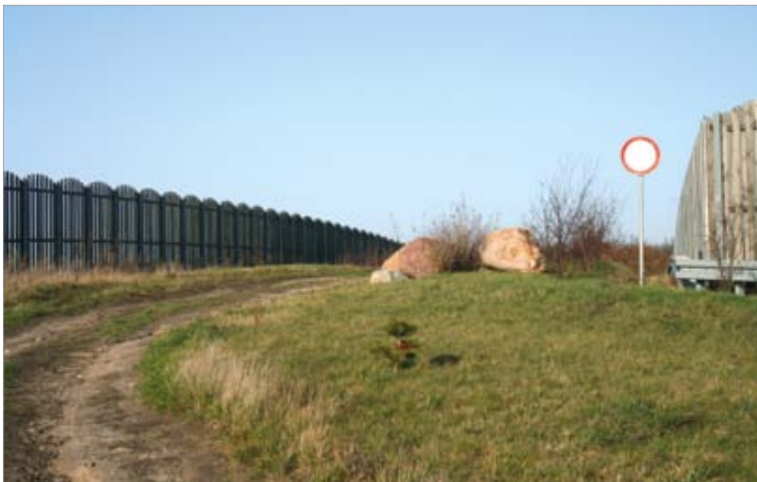
Fot. 33. Zabezpieczenia przed przejazdami w strefie przeznaczony dla zwierząt na przejściu górnych, wykonane z głazów – autostrada A2.
