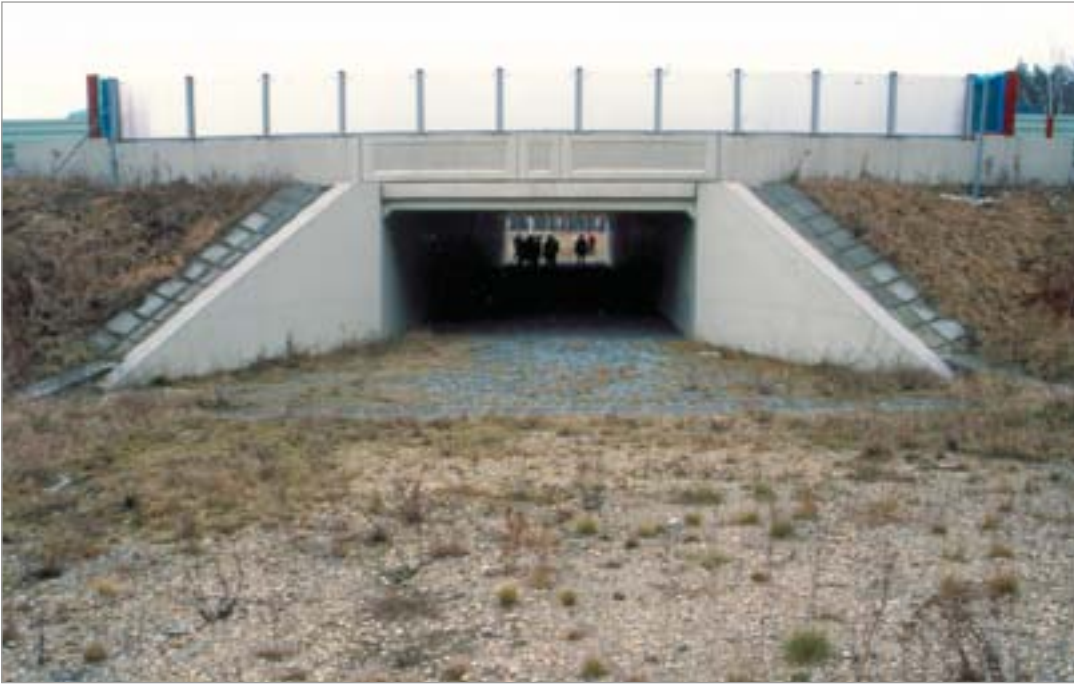
Fot. 76. Przejście dolne o wymiarach niedostosowanych do wymagań ssaków kopytnych, dodatkowo brak okna doświetleniowego – autostrada A4.
