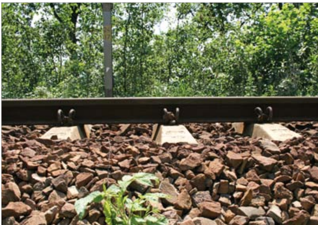
Fot. 165. Szczeliny pod szynami należy pozostawiać na każdym odcinku linii kolejowej kolidującej z siedliskami płazów.
