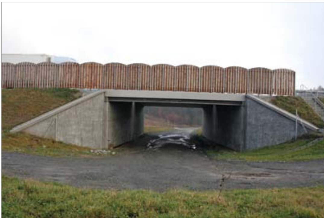
Fot. 145. Przykład przejścia dolnego o zbyt krótkich ekranach przeciwoślnościowych.
