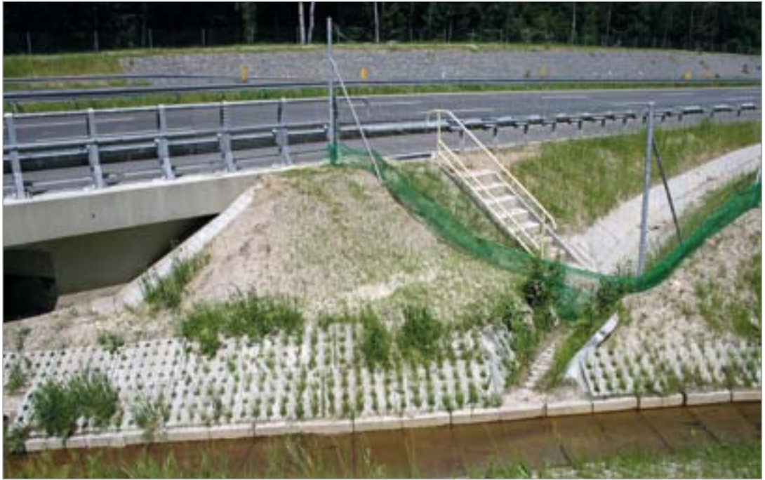
Fot. 132. Ogrodzenie poprowadzone w niewłaściwy sposób przy przejściu dolnym – brak naprowadzania zwierząt oraz duże ryzyko kolizji.
