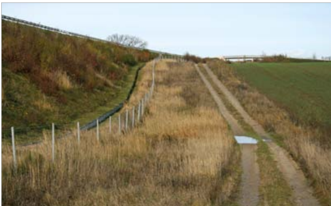
Fot. 64. Przykład drogi serwisowej wzdłuż autostrady A20 (Niemcy) – drogi o takiej nawierzchni mogą przebiegać w otoczeniu przejść.
