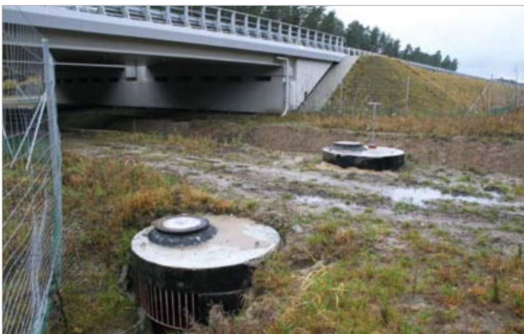
Fot. 102. Separatory utrudniające dojście do przejścia dolnego oraz stanowiące pułapkę dla płazów – droga ekspresowa S-3.
