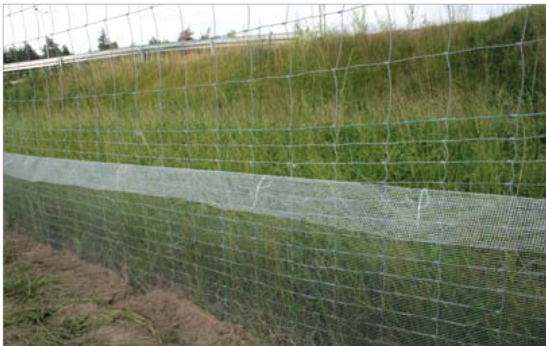
Fot. 123. Ogrodzenie ochronno-naprowadzające z siatki stalowej ocynkowanej.
