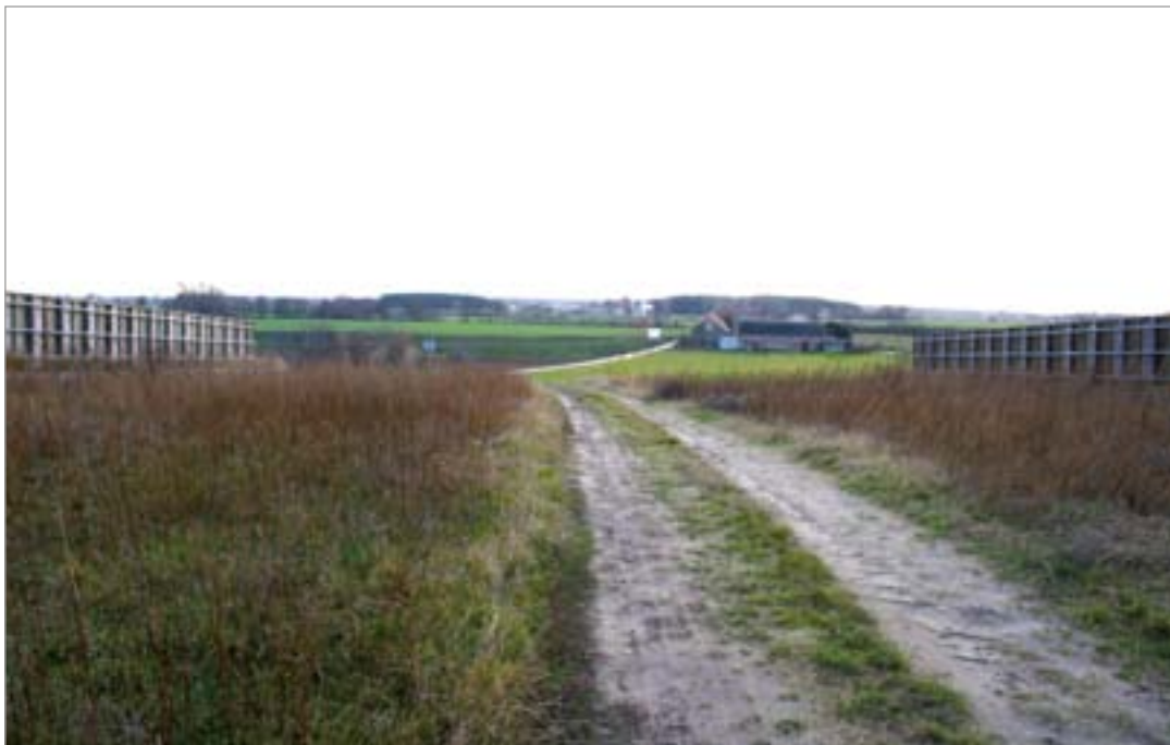
Fot. 3. Przejście o parametrach dla dużych ssaków leśnych zlokalizowane w obszarach polnych, dodatkowo lokalizacja przy niekorzystnym przebiegu niwelety drogi oraz w bezpośrednim sąsiedztwie terenów zabudowy – autostrada A2.
