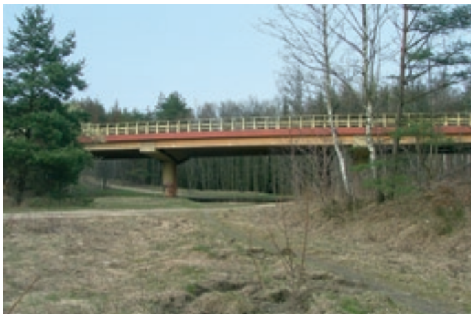
Fot. 7. Duże przejście dolne zespolone z drogą gospodarczą (gruntową) – droga ekspresowa S-6 (Obwodnica Trójmiasta).
