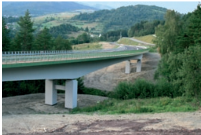
Fot. 8. Estakada dobrze wkomponowana w otoczenie – długie przeszła, „delikatna” konstrukcja. Droga ekspresowa S-69. Fot. R. Kurek
