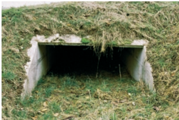
Fot. 9. Przejście (przepust) dla małych zwierząt o przekroju prostokątnym pod lokalną drogą w południowych Niemczech. Fot. R. Kurek
