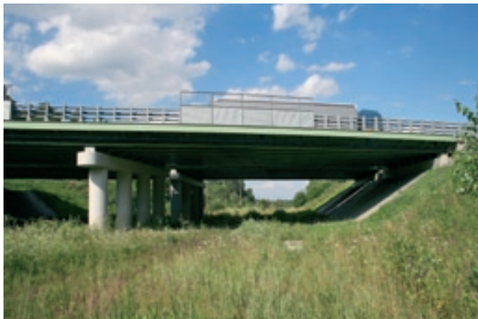
Fot. 6. Duże przejście dolne zespolone z linią kolejową – autostrada A4, okolice Gliwic.
