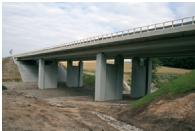
Fot. 3. Duże przejście dolne pod estakadą w dolinie potoku Babska Studnia, droga ekspresowa S-1. Fot. R. Kurek
