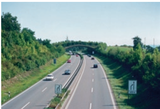
Fot. 6. Osłonowe nasadzenia roślinności wzdłuż drogi ekspresowej B33 w Niemczech, w oddali górne przejście dla zwierząt (zielony most Hohereute, szer. 35 m). Fot. R. Kurek
