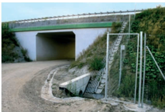
Fot. 7. Przykład obiektu źle wkomponowanego w otoczenie – widoczne elementy odwodnienia i odsłonięta konstrukcja przyczółków. Obiekt nie będzie spełniał funkcji przejścia dla zwierząt. Droga ekspresowa S-69, przejazd gospodarczy. Fot. R. Kurek
