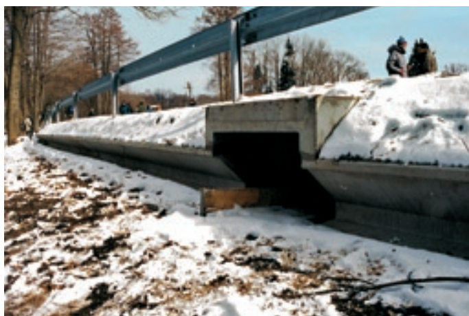
Fot. 11. Przepust dla płazów z ogrodzeniem naprowadzającym w Jeleniowie (Park Narodowy Gór Stołowych). Fot. R. Kurek
