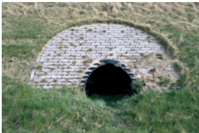
Fot. 10. Przejście (przepust) dla małych zwierząt o przekroju owalnym – obwodnica Piły, DK nr 11. Fot. R. Kurek
