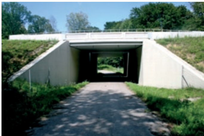
Fot. 3. Utwardzone drogi na powierzchni przejścia – kluczowy element odstrasżający zwierzęta. Autostrada A4, przejazd gospodarczy dla drogi leśnej. Fot. R. Kurek
