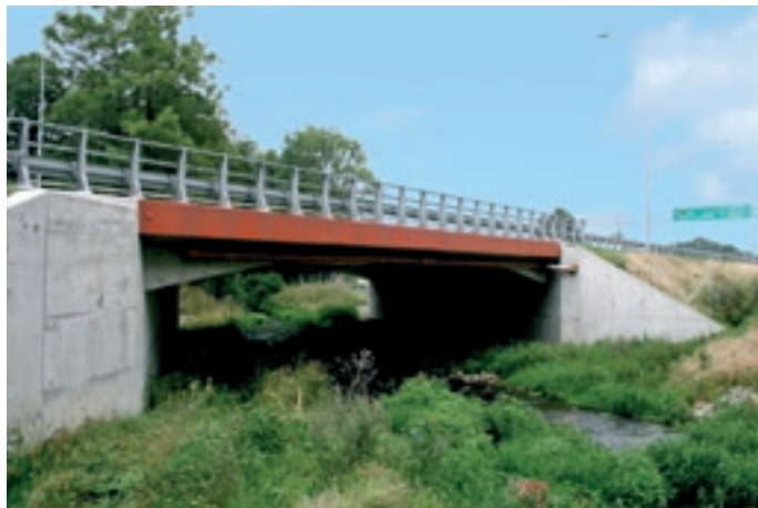
Fot. 5. Most nad potokiem zlokalizowany przy oświetlonym węźle – obiekt nie będzie wykorzystywany przez średnie i duże ssaki. Droga ekspresowa S-1. Fot. R. Kurek
