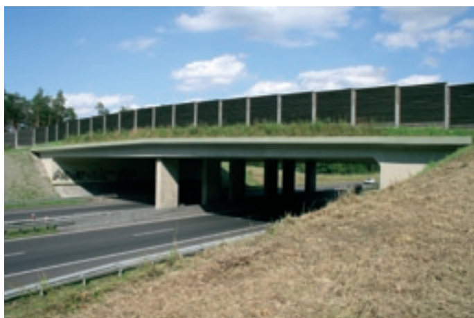
Fot. 2. Duże przejście górne (zielony most, szer. 35 m), autostrada A4 okolice Gliwic. Fot. R. Kurek
