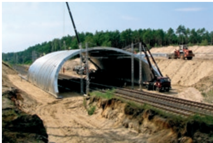
Fot. 9. Przejścia górne powinny być lokowane w wykopach co ułatwia spełnienie warunku o dopuszczalnym nachyleniu powierzchni. Linia kolejowa E20. Fot. K. Czechowski
