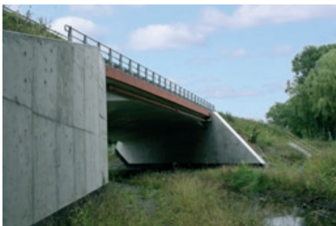
Fot. 8. Średnie przejście dolne pod poszerzonym mostem – most nad Szerokim Potokiem, droga ekspresowa S-1, okolice Bielska-Białej.
