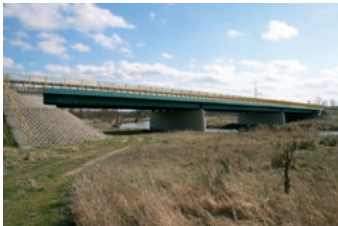
Fot. 4. Duże przejście dolne pod poszerzonym mostem – most nad rzeką Gwda, obwodnica Piły DK nr 11. Fot. R. Kurek
