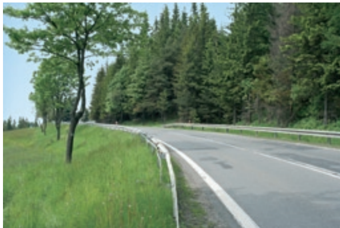
Fot. 4. Droga krajowa nr 47 na odcinku: Rdzawka–Klikuszoza – kolizja z korytarzem migracyjnym o znaczeniu międzynarodowym. Fot. R. Kurek
