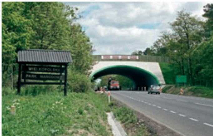
Fot. 5. Przejścia dla zwierząt powinny być budowane także przy drogach jednojezdniowych gdy natężenie ruchu przekracza 10 tys. poj./dobę (droga kraj. nr 5, okolice Sęszewa) Fot. R. Kurek
