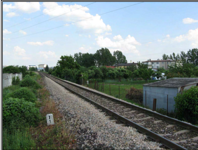
Fot. 14 Widok na bocznicę kolejową– widok z ul. Mleczarskiej w kierunku wschodnim
