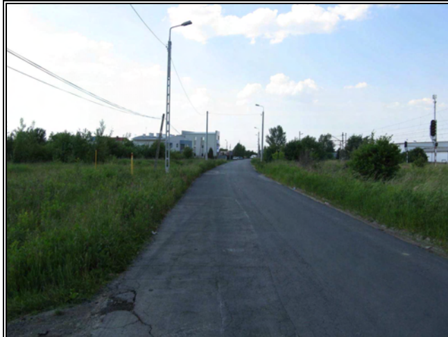
Fot. 18 Istniejąca droga wzdłuż torów kolejowych w okolicy planowanego przystanku „Piaseczno Północ”
