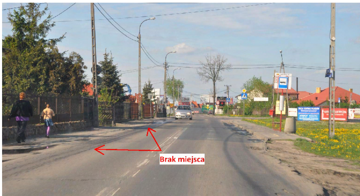
Rysunek 8.38 Ulica Głębocka, okolice skrzyżowania z ulicą Lewandów.
