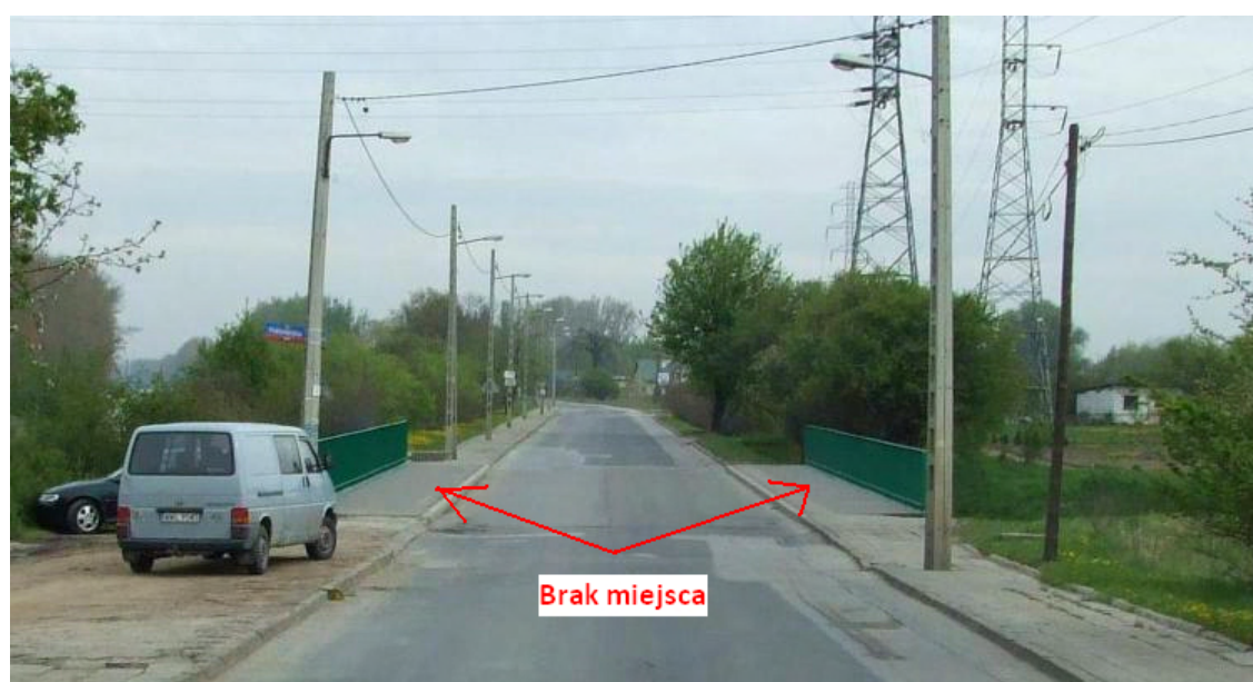
Rysunek 8.30 Ulica Białołęcka, mostek nad ujściem Kanału Bródnowskiego.
