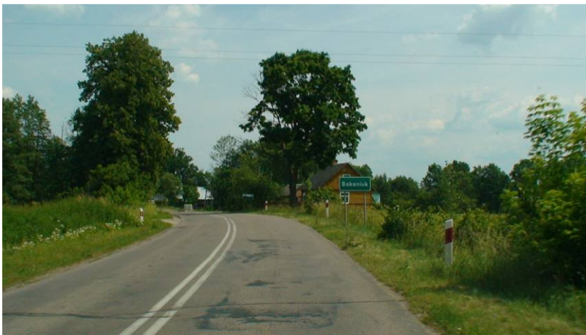
Fot. 5. Typowy przekrój poprzeczny na DW665, odcinek Raczki-Suwalki
