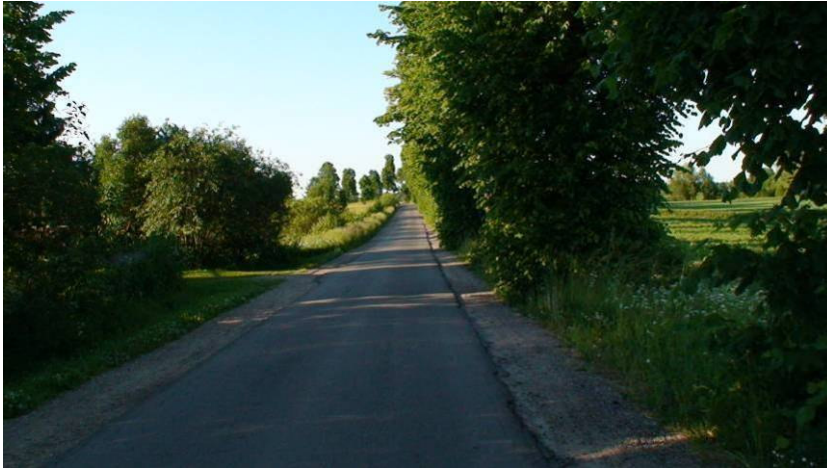
Fot. 4. Typowy przekrój poprzeczny na DW661, odcinek Raczki-Kalinowo
